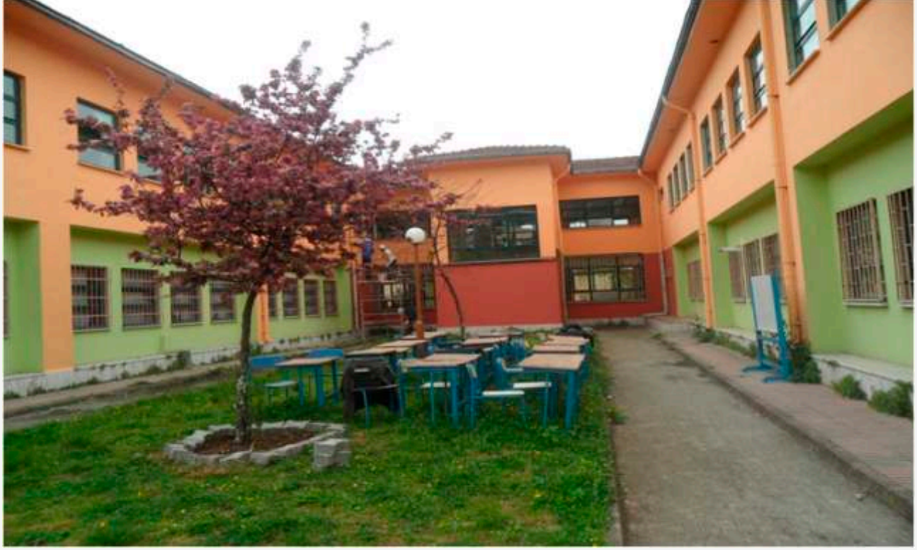
TEVFİK FİKRET İLKÖĞRETİM OKULU DIŞ CEPHE BOYASI
