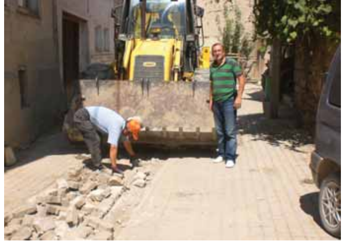
Bölcek Mahallesi İçme Suyu Yeni Hat Çalışması
