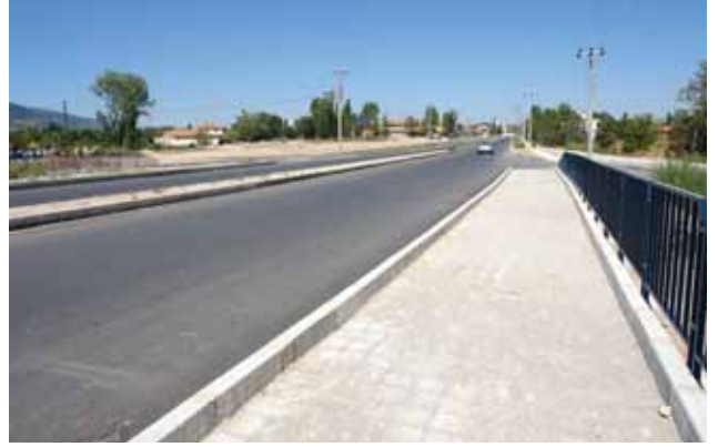
Bölcek Mahallesi Yol Genişletme Çalışmaları
