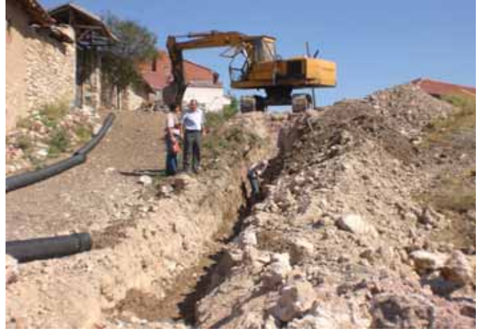
İnköy Mahallesi Yeni Kanalizasyon Hattı Çalışması
