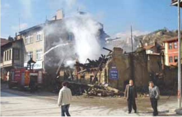
Ahşap Bina Yangını
