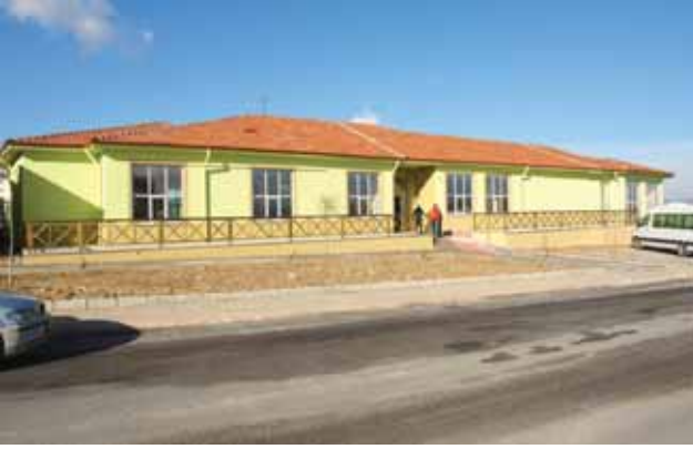
Belediye Sosyal Tesis Binası
