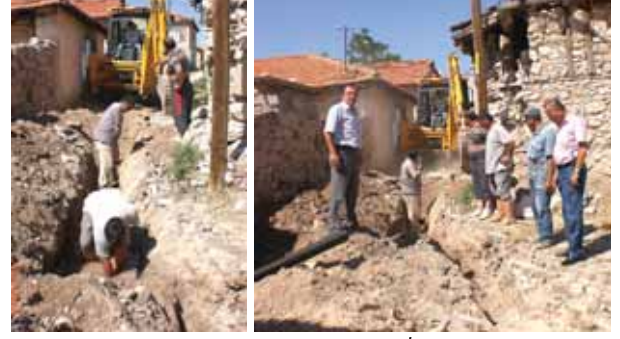
Alayunt Mahallesi Yeni İçme Suyu Hattı Yapımı
