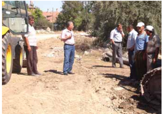
Kirazpınar Mahallesi Yeni Kanalizasyon Hattı Çalışması
