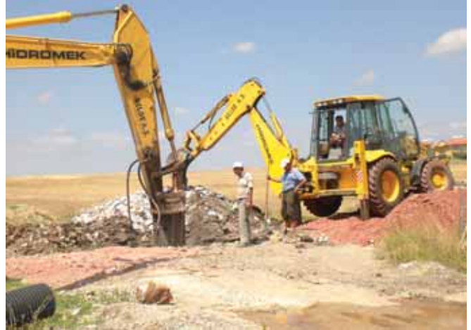
Yoncalı Kanalizasyon Hattı Çalışması
