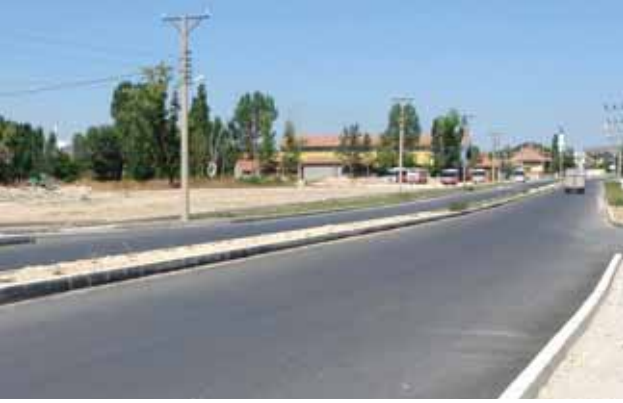
Bölcek Mahallesi Yol Genişletme Çalışmaları
