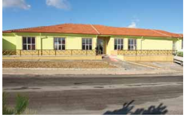
Belediye Sosyal Tesis Binası
