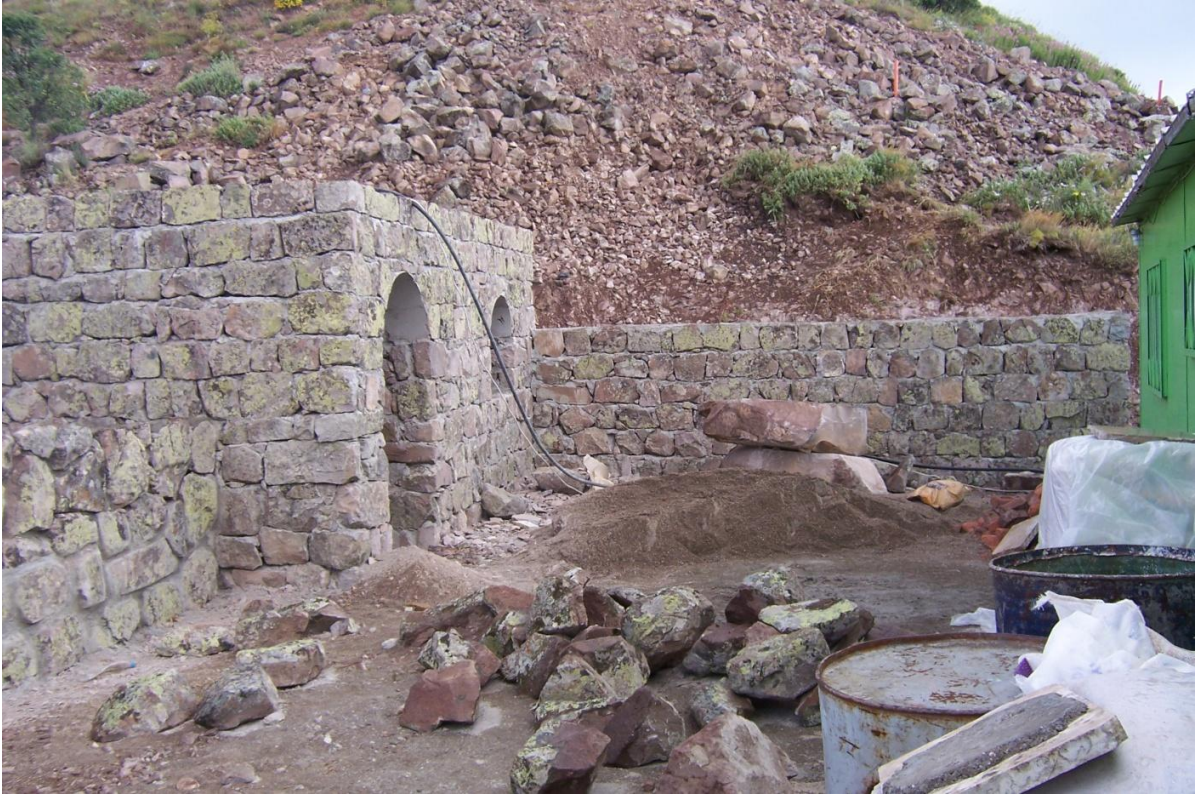
3-Mesire alanı bina tamirati yapıldı.
