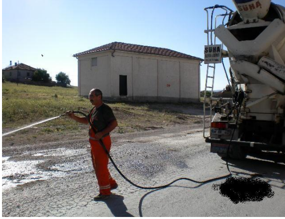
Asfalt üzerine hazır beton araçlarından dökülen betonla mücadele.
