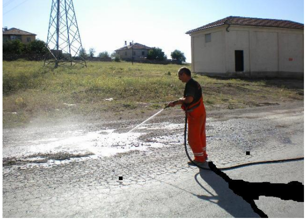
Asfalt üzerine hazır beton araçlarından dökülen betonla mücadele.
