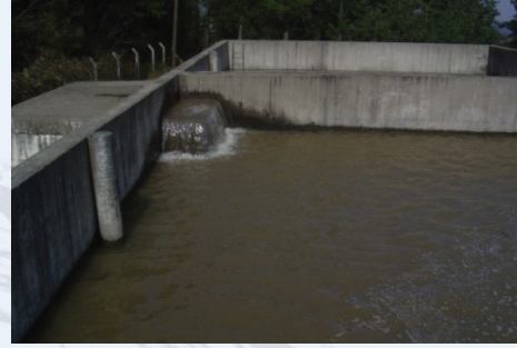
Hacımercan İçmesuyu Arıtma Tesisi Dinlenme Havuzu
