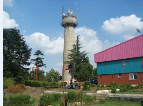
Maltepe İçmesuyu Arıtma Tesisleri
