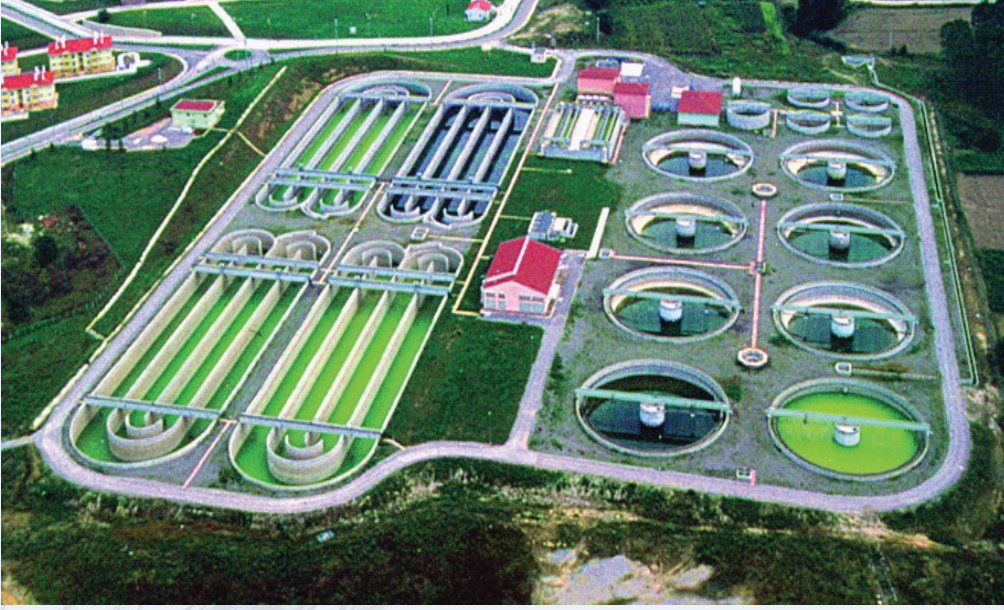
Karaman Atıksu Arıtma Tesisi
