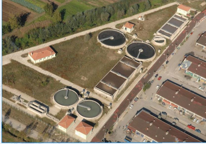
Akyazı Atıksu Arıtma Tesisi
