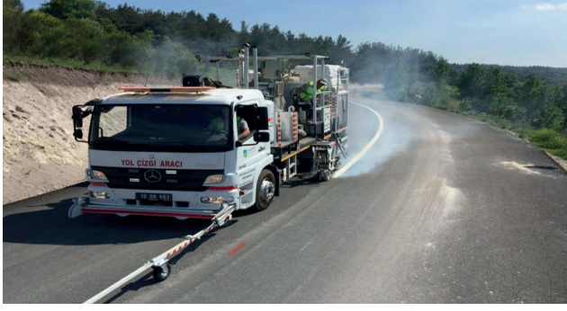
Altıeylül İlçesi Pamukçu – Türkali termoplastik yol çizgi çalışması.
