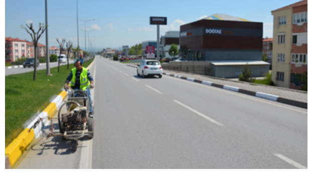
Altıeylül İlçemiz Yeni İzmir Yolu Bordür çalışması.
