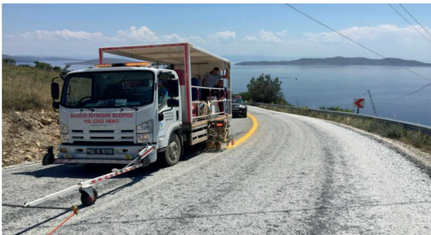
Marmara İlçemiz Saraylar Mahallesi arası yol çizgi çalışması.
