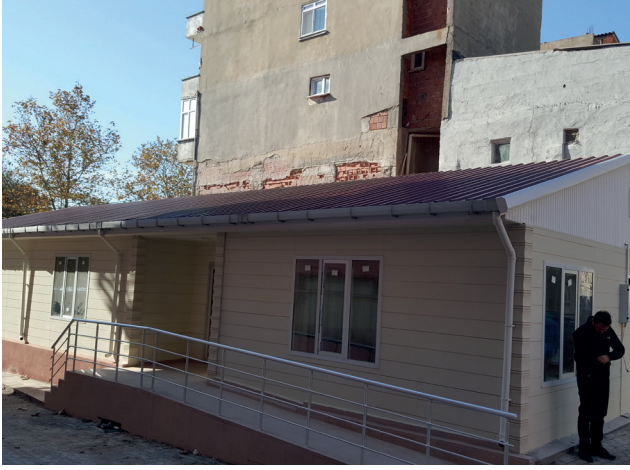
186.000,00 TL Bedelli Erdek İlçesi Karşıyaka Mah. Prefabrik Ek Hizmet Binası Yapım İşi
