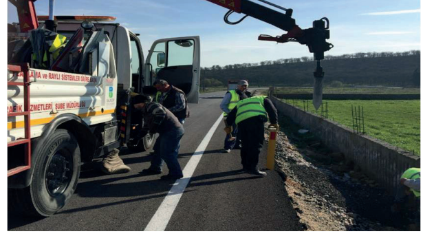
Karesi İlçemiz Şamlı – Boğazköy Mahalle yolu CTP (Yol Kenar Dikmesi) çalışması.
