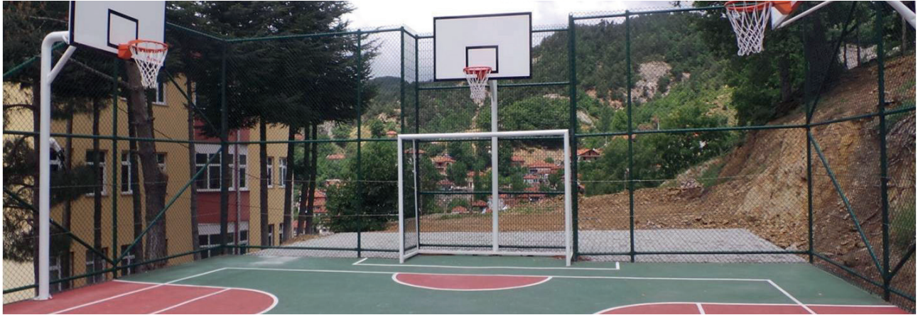
Gümeli Mahallesine 1 Adet Semt Spor Sahası , Değirmenbaşı Mahallesine 1 Adet Tel Örgülü Toprak Saha Yapılmıştır. Maliyet : 123.000,00 TL
