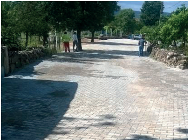
92.000,00 TL Bedelli İvrindi İlçesi Sofular Mahallesi Çamköy Sokağı Parke Taşı Yapım İş Tamamlanmıştır.
