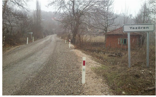
Savaştepe İlçesi Yazören Mahallesi CTP ( Yol Kenar Dikmesi ) ve Kırsal Mahalle Yön Bilgilendirme Levha Çalışması.
