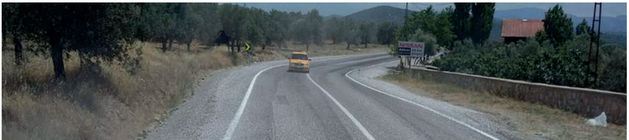
Gömeç İlçemiz Karaağaç – Artur Mahalle yolu çizgi çalışması.
