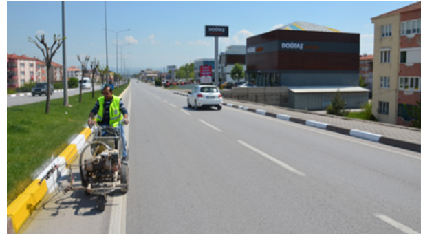
Ayvalık İlçemizde toplamda 279 adet trafik işaret levhası ve 48 adet kırsal mahalle yön bilgilendirme levhası takılmıştır.
