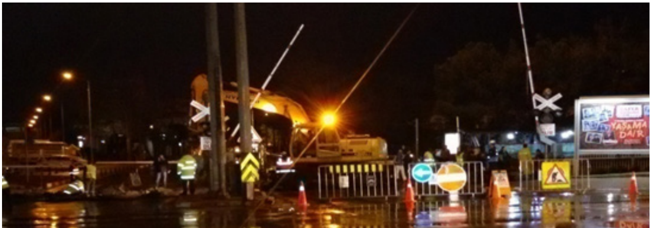
YOL KAPAMA/İŞARETLEME ÇALIŞMALARI
