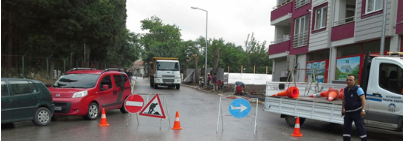
YOL KAPAMA/İŞARETLEME ÇALIŞMALARI
