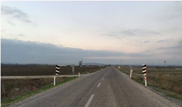
Manyas İlçesi Akçaova Mahallesi Trafik Levha ve CTP (Yol Kenar Dikmesi) Çalışması.
