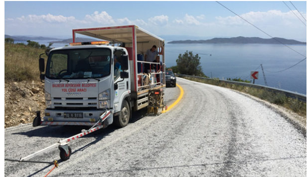
Marmara İlçesi Saraylar Yol Çizgi Çalışması.
