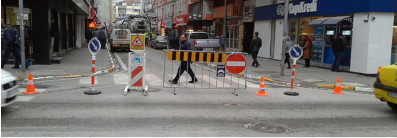
YOL KAPAMA/İŞARETLEME ÇALIŞMALARI
