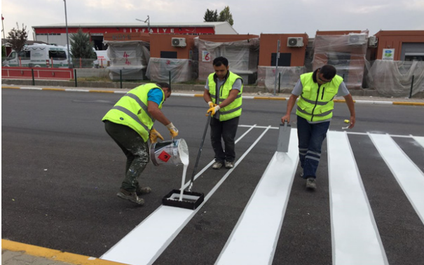
Karesi İlçesi Paşaalani Mahallesi Dereboyu Caddesi Yavaşlama Ön Uyarı Çizgi Çalışması.
