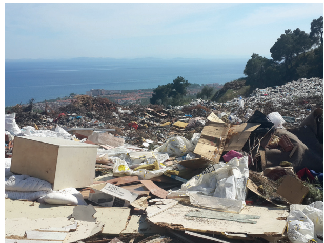
Şekil 3.2 Rehabilitate Edilecek Vahşi Depolama Alanı Örneği
