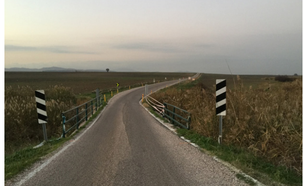
Bandırma İlçesi Küleflü Mahallesi Trafik Levha ve CTP (Yol Kenar Dikmesi) Çalışması.
