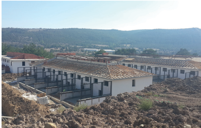
Şekil 3.4 İvrindi Sokak Hayvanları Rehabilitasyon Merkezi
