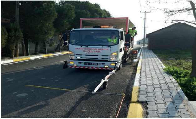
Bandırma İlçemiz Ömerli Mahallesi yol çizgi çalışması.
