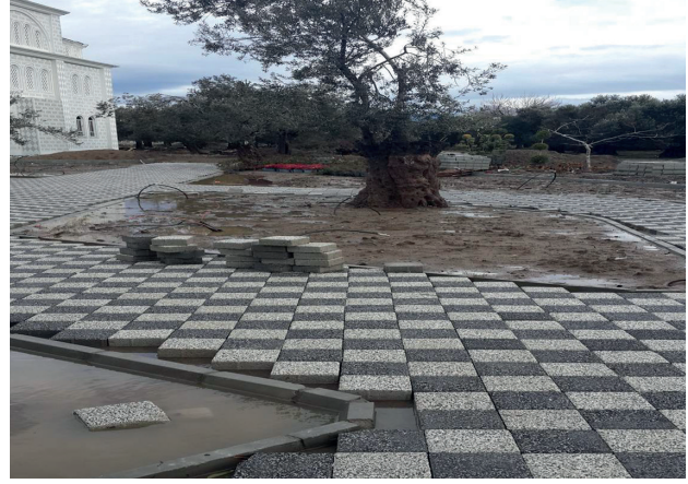
Hamambası ve Temaşalık Mahallelerinde düzenleme yapım işi devam etmektedir. Toplam alan : 1.405 m 2 Maliyet : 369.400,00 TL
