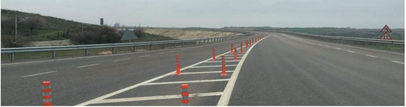
Altıeylül İlçesi sınırlarındaki - Organize Sanayi Yolu trafik güvenliği açısından delinatör çalışması
