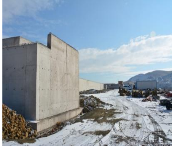
Atık Su Arıtma Tesisi İnşaatı
