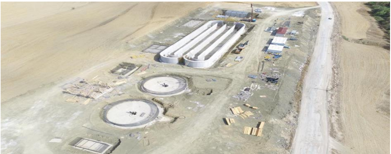
Atık Su Arıtma Tesisi İnşaatı
