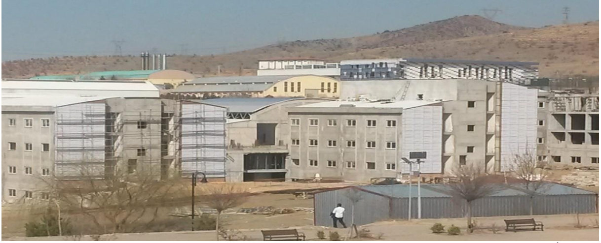
Fen-Edebiyat Fakültesi İnşaatı
