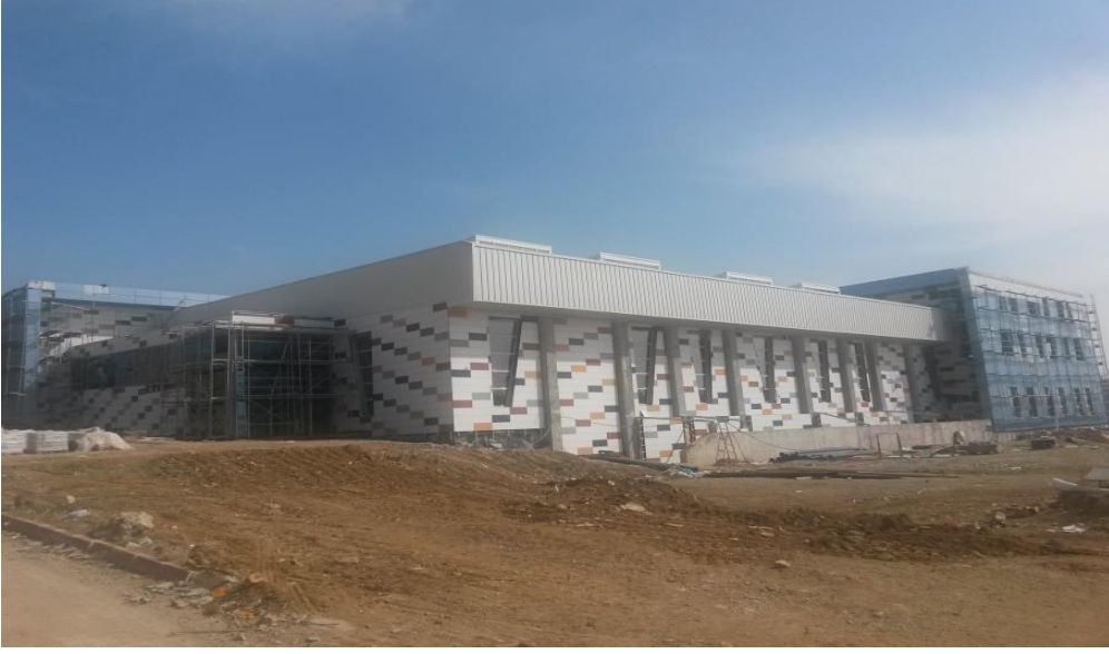
Açık ve Kapalı Spor Tesisi İnşaatı
