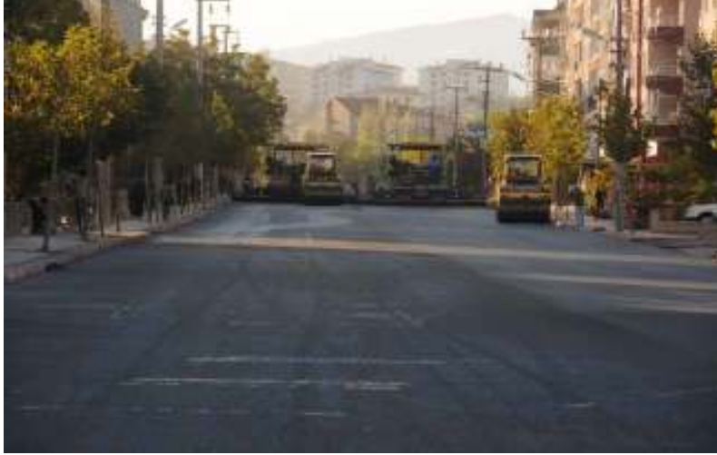
BAĞBAŞI MAHALLESİ ŞEHİT NEVZAT ASLAN BULVARI ASFALT ÇALIŞMASI
