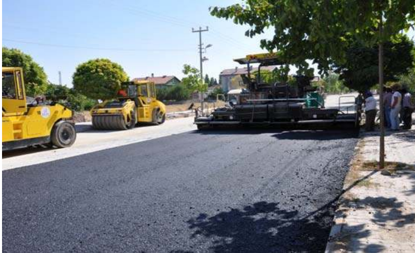
AHİEVİRAN MAH. NURSULTAN NAZARBAYEV CADDESİ ASFALT ÇALIŞMASI
