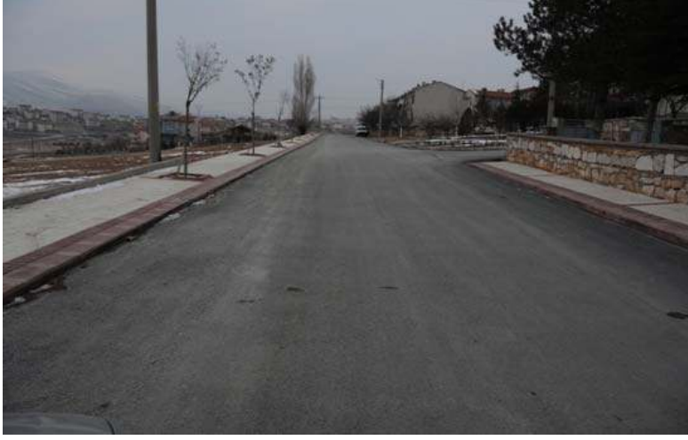
KERVANSARAY MAHALLESİ ÇATI YAPI ASFALT ÇALIŞMASI
