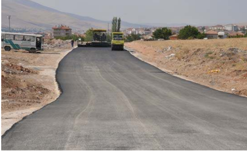
BAHÇELİEVLER MAHALLESİ 1735. SOKAK ASFALT ÇALIŞMASI
