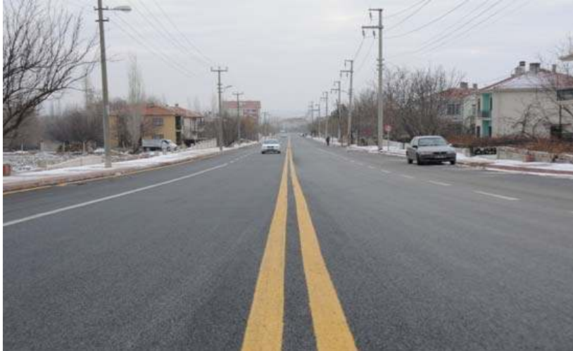
BAĞBAŞI MAHALLESİ NEŞET ERTAŞ BULVARI ASFALT ÇALIŞMASI
