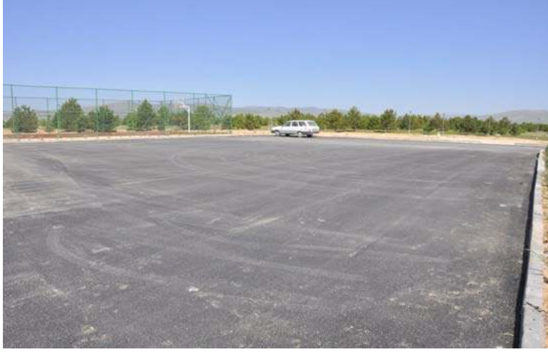
KENT PARK YAN YOLLAR ASFALT ÇALIŞMASI
