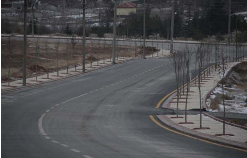
ŞEHİT MUZAFFER DEMİR CADDESİ ASFALT ÇALIŞMASI
