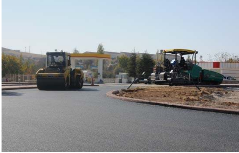
ÇUKURÇAYIR MAHALLESİ GÖKPETROL KAVŞAĞI ASFALT ÇALIŞMASI
