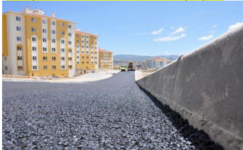
BAĞBAŞI MAHALLESİ TOKİ KONUTLARI ASFALT ÇALIŞMASI
