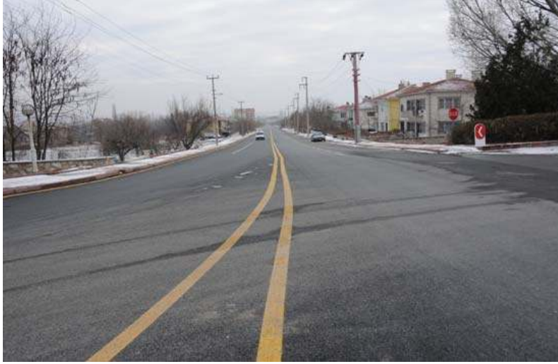
BAĞBAŞI MAHALLESİ NEŞET ERTAŞ BULVARI ASFALT ÇALIŞMASI
