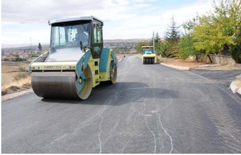
KERVANSARAY MAHALLESİ ÇATI YAPI ASFALT ÇALIŞMASI
