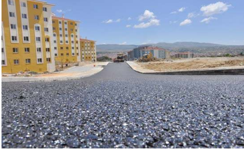
BAĞBAŞI MAHALLESİ TOKİ KONUTLARI ASFALT ÇALIŞMASI
