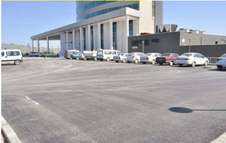
MAKİSSOS OTEL ASFALT ÇALIŞMASI
