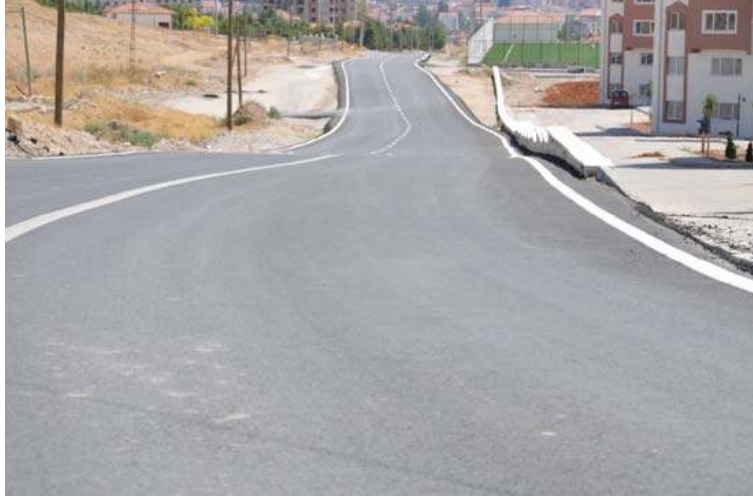
BAĞBAŞI MAH. ŞEHİT SAHİR KURUTLUOĞLU CAD. ASFALT ÇALIŞMASI
