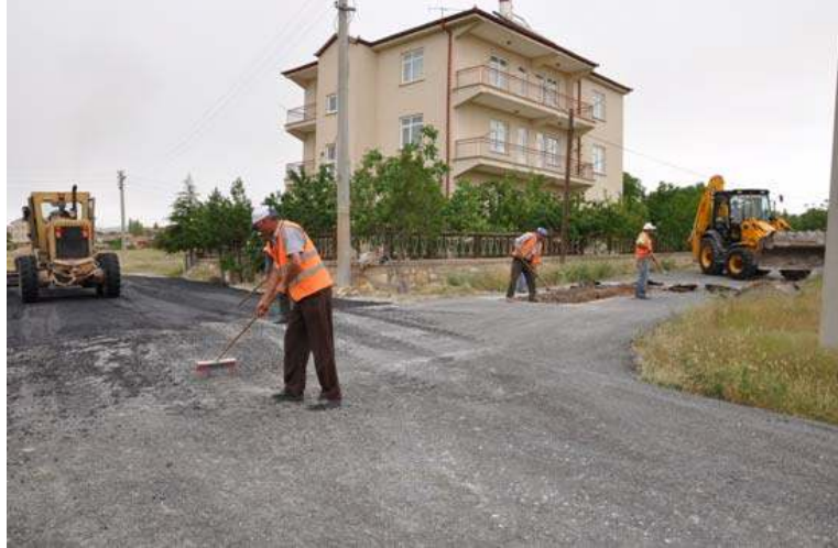
KERVANSARAY MAHALLESİ 2220. VE 2221 SOKAKLARDA ASFALT ÇALIŞMASI
