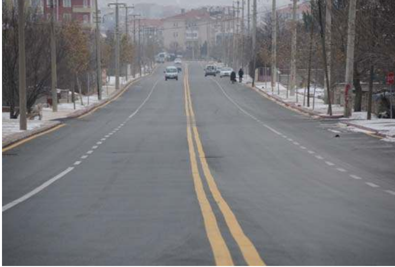
BAĞBAŞI MAHALLESİ NEŞET ERTAŞ BULVARI ASFALT ÇALIŞMASI
