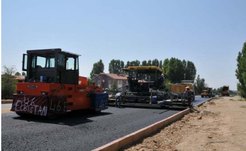
ŞEHİT EKREM ÜLKER CADDESİ ASFALT ÇALIŞMASI
