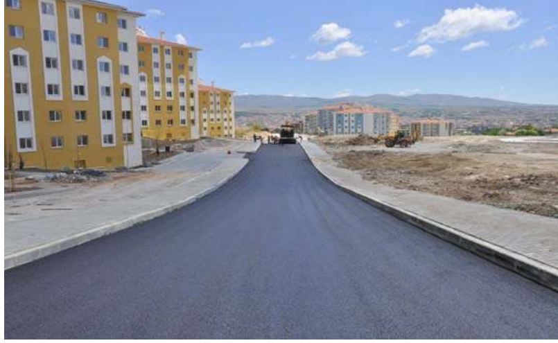
BAĞBAŞI MAHALLESİ TOKİ KONUTLARI ASFALT ÇALIŞMASI
