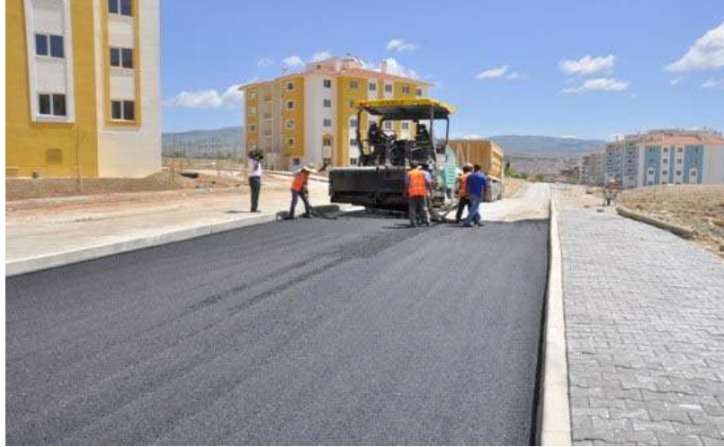
BAĞBAŞI MAHALLESİ TOKİ KONUTLARI ASFALT ÇALIŞMASI
