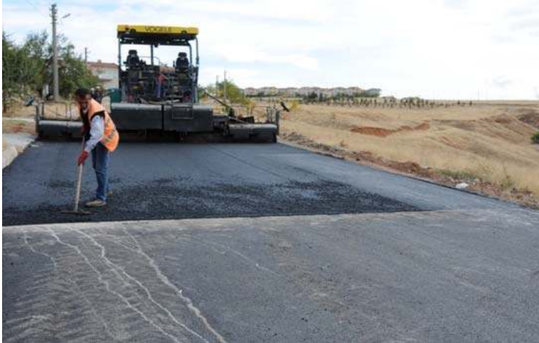
KERVANSARAY MAHALLESİ ÇATI YAPI ASFALT ÇALIŞMASI
