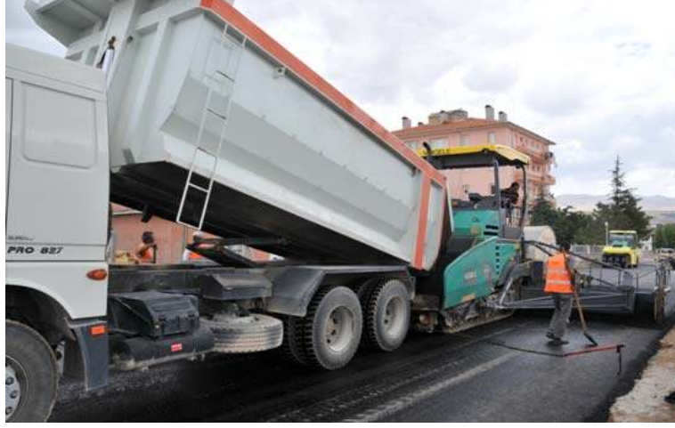
BAĞBAŞI MAH. ŞEHİT SAHİR KURUTLUOĞLU CAD. ASFALT ÇALIŞMASI
