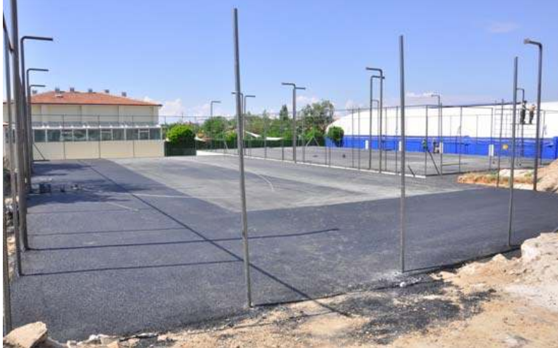
TENİS KORTU ASFALT ÇALIŞMASI
