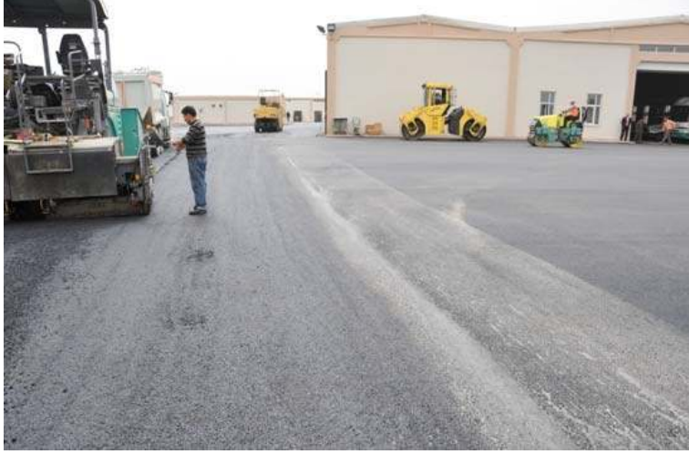
KERVANSARAY MAHALLESİ ÇATI YAPI ASFALT ÇALIŞMASI
