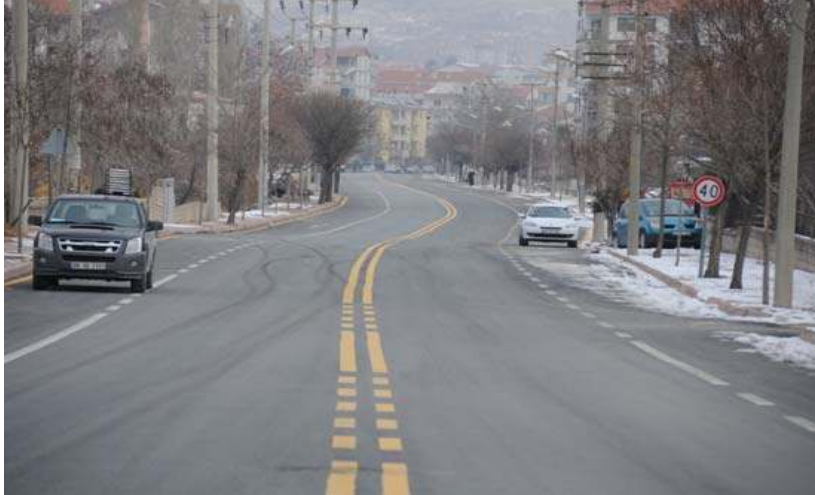
AHİEVİRAN MAH. NURSULTAN NAZARBAYEV CADDESİ ASFALT ÇALIŞMASI
