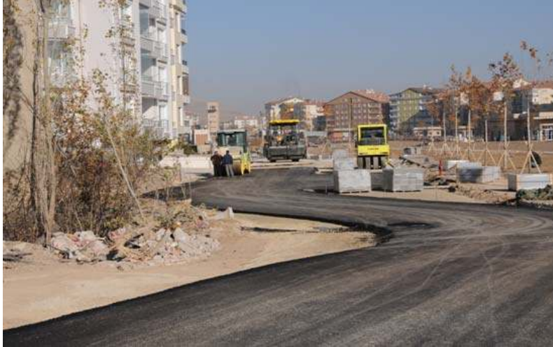
KENT PARK YAN YOLLAR ASFALT ÇALIŞMASI
