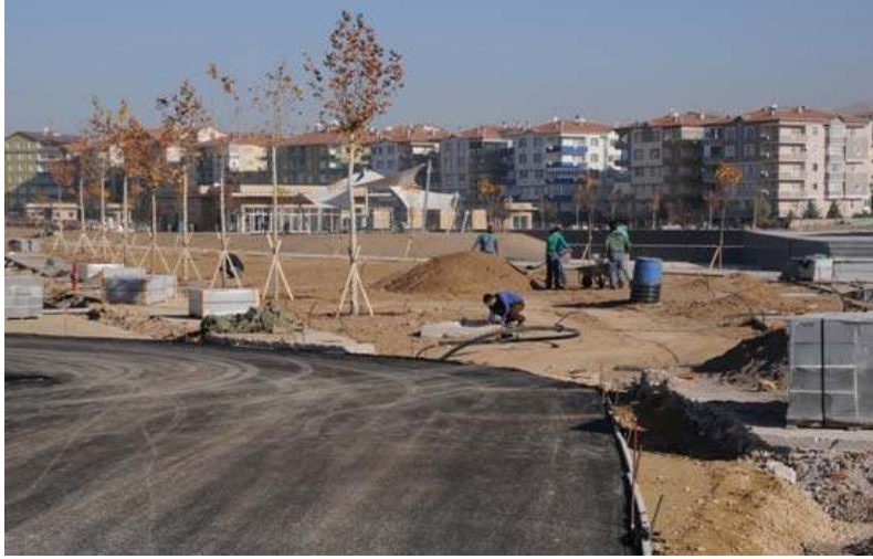
KENT PARK YAN YOLLAR ASFALT ÇALIŞMASI
