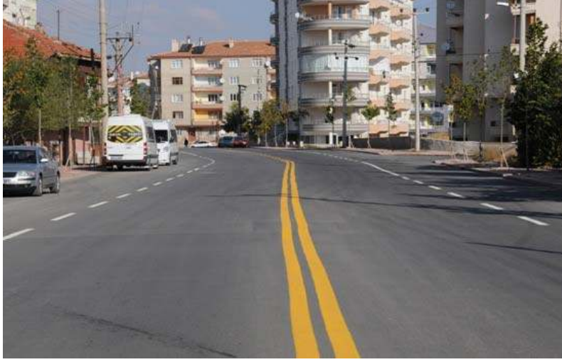
BAHÇELİEVLER MAHALLESİ SELGAH CADDESİ ASFALT ÇALIŞMASI
