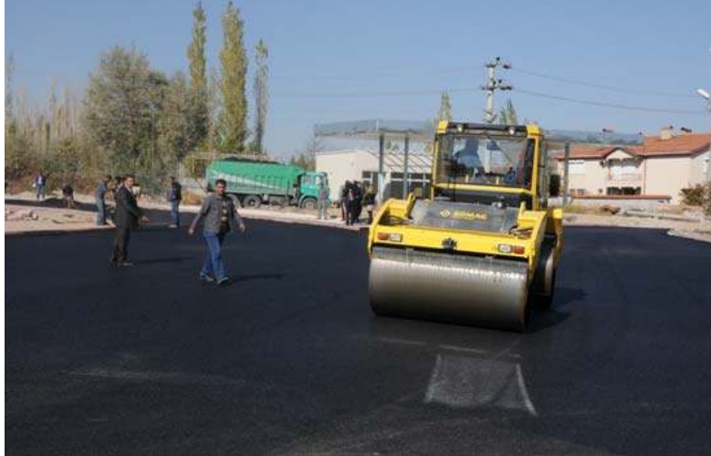
ÇUKURÇAYIR MAHALLESİ GÖKPETROL KAVŞAĞI ASFALT ÇALIŞMASI
