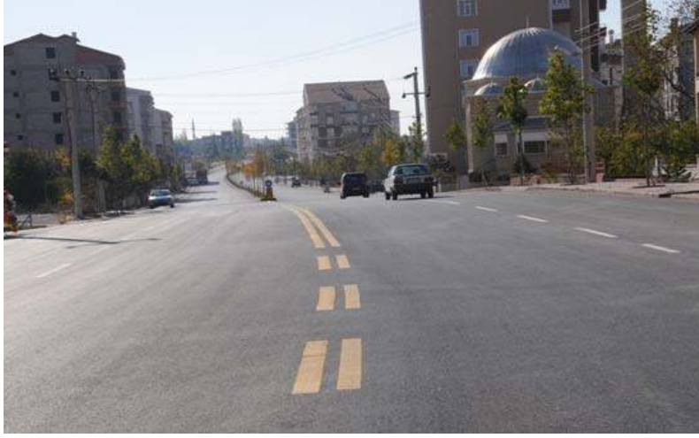
BAHÇELİEVLER MAHALLESİ SELGAH CADDESİ ASFALT ÇALIŞMASI
