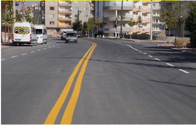
BAHÇELİEVLER MAHALLESİ SELGAH CADDESİ ASFALT ÇALIŞMASI
