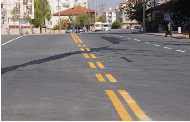
BAHÇELİEVLER MAHALLESİ SELGAH CADDESİ ASFALT ÇALIŞMASI
