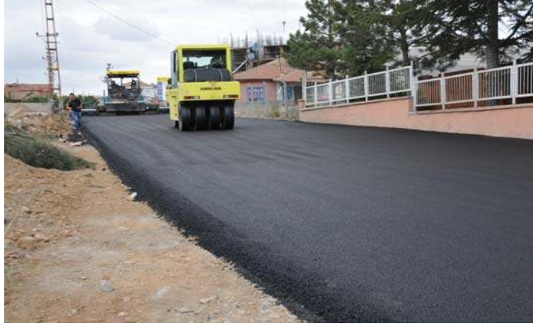
BAĞBAŞI MAH. ŞEHİT SAHİR KURUTLUOĞLU CAD. ASFALT ÇALIŞMASI
