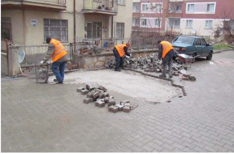
YENİCE MAHALLESİ 161. SOKAK
