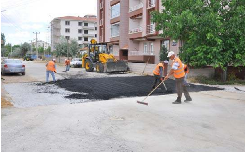
NASUHDDE MAHALLESİ KUYUBAŞI CADDESİ
