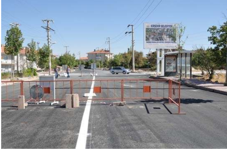
BAĞBAŞI MAHALLESİ ŞEHİT NEVZAT ASLAN BULVARI ASFALT ÇALIŞMASI
