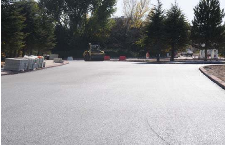
ÇUKURÇAYIR MAHALLESİ GÖKPETROL KAVŞAĞI ASFALT ÇALIŞMASI
