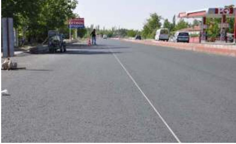
ŞEHİT EKREM ÜLKER CADDESİ ASFALT ÇALIŞMASI
