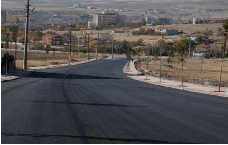
KERVANSARAY MAHALLESİ ŞEHİT MUZAFFER DEMİR CADDESİ ASFALT ÇALIŞMASI
