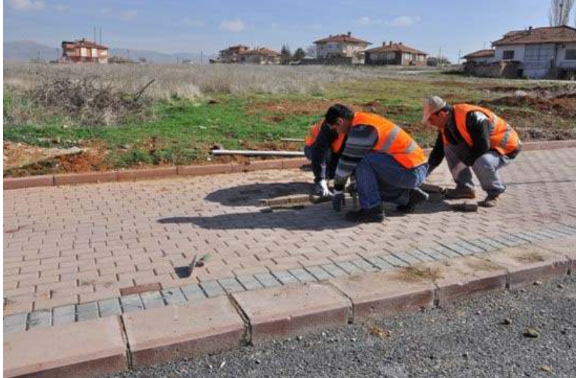
BAHÇELİEVLER MAHALLESİ SELGAH CADDESİ
