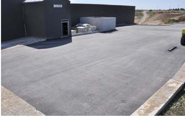
MAKİSSOS OTEL ASFALT ÇALIŞMASI
