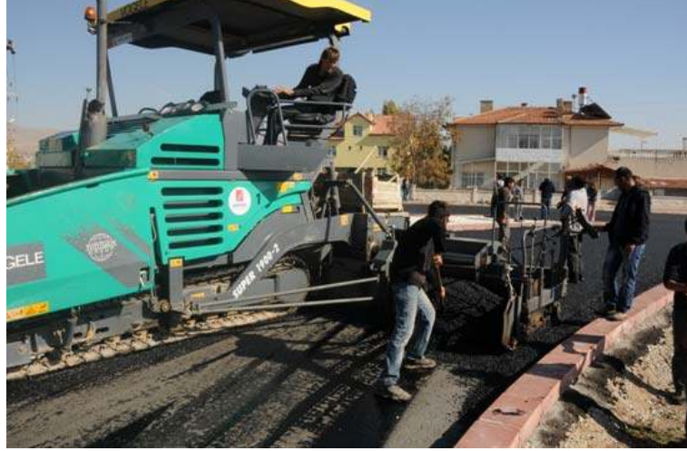
ÇUKURÇAYIR MAHALLESİ GÖKPETROL KAVŞAĞI ASFALT ÇALIŞMASI
