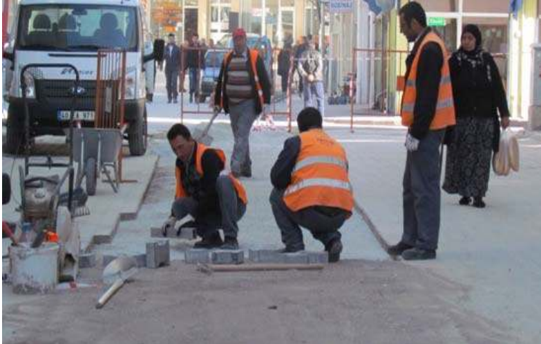
YENİCE MAHALLESİ 181. SOKAK
