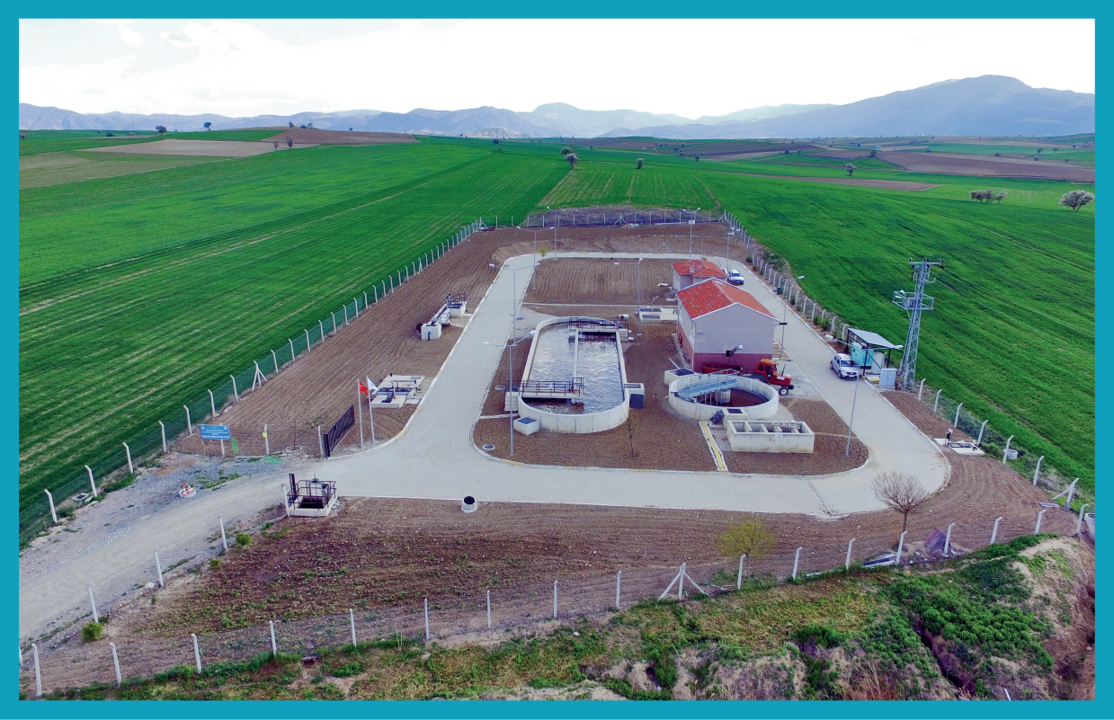
Bozkurt Atıksu Arıtma Tesisi
