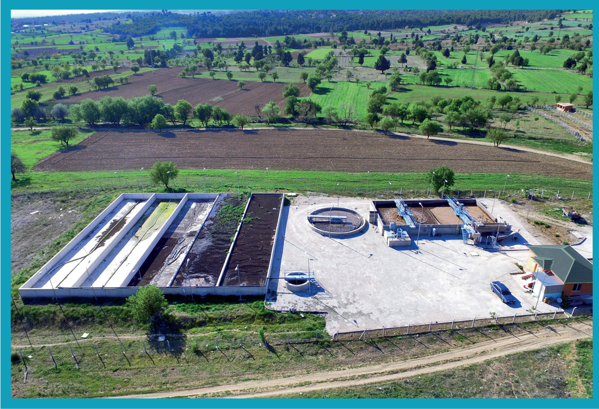
Acıpayam-Yeşilyuva Atıksu Arıtma Tesisleri
