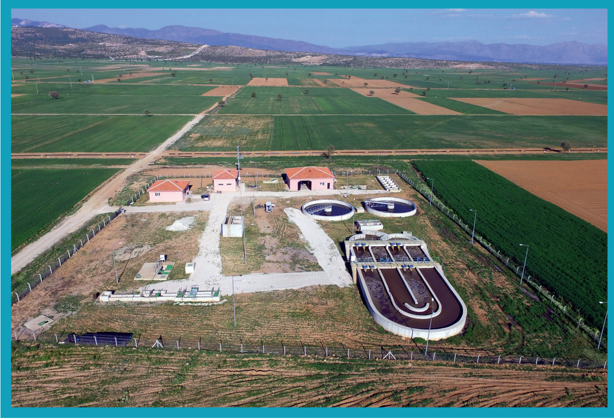
Serinhisar Atıksu Arıtma Tesisleri
