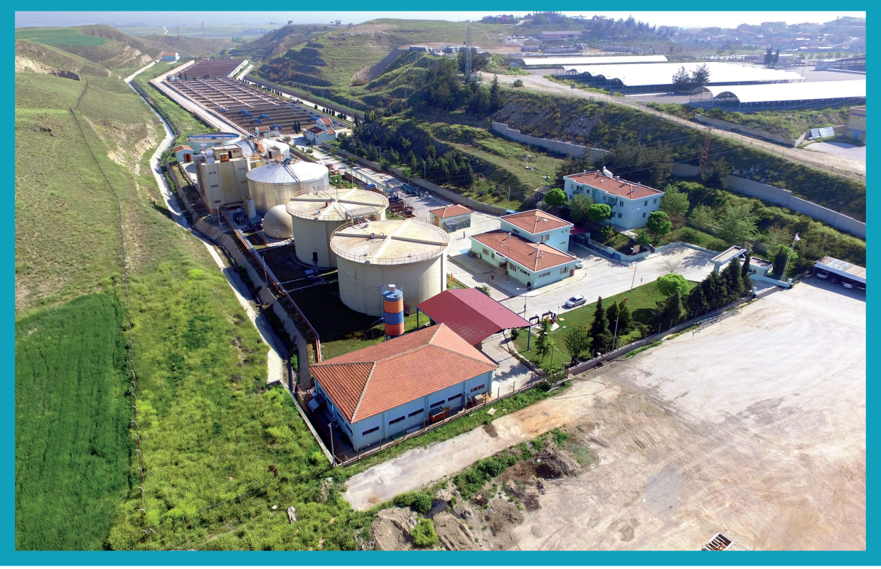
Merkez Atıksu Arıtma Tesisi
