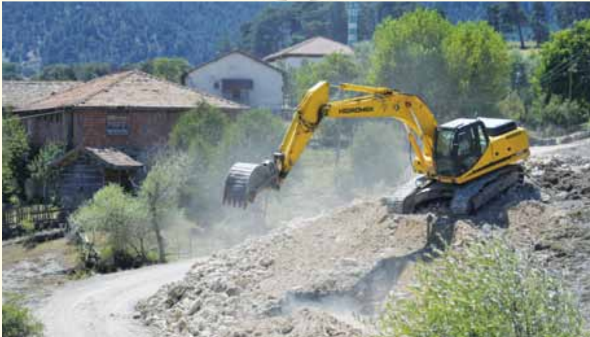
İhsangazi Cambaz Köyü Yol Genişletme Çalışmaları
