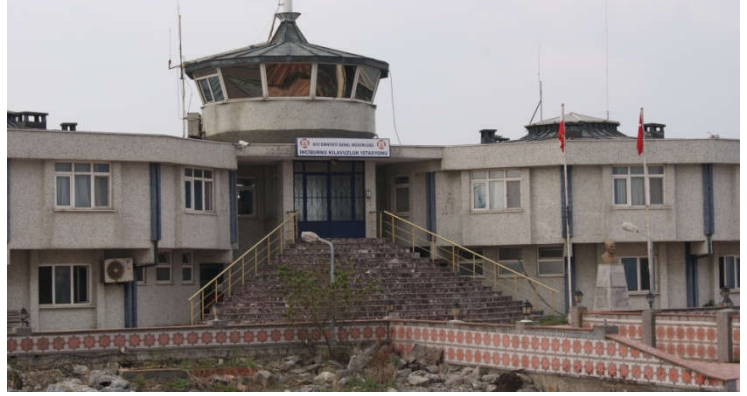
İNCİBURNU KILAVUZLUK İSTASYONU
