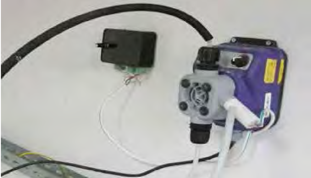
RESİM 1. KUYULARDA OTOMATİK HAVA TAHLİYE SİSTEMLİ KLOR DOZLAMASI
