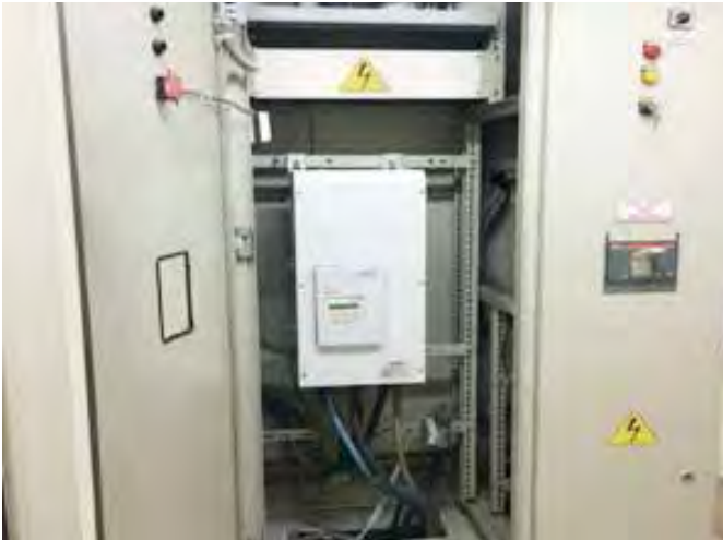
ALAVARDI POMPA İSTASYONU 3. MOTOR SOFT STARTER DÖNÜŞÜMÜ
