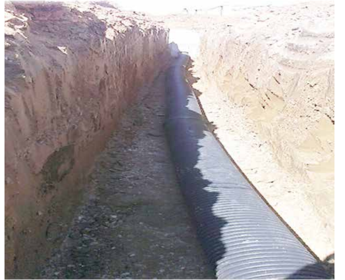
Seydişehir İlçesi Stat Mahallesi Kanalizasyon Şebeke Çalışması
