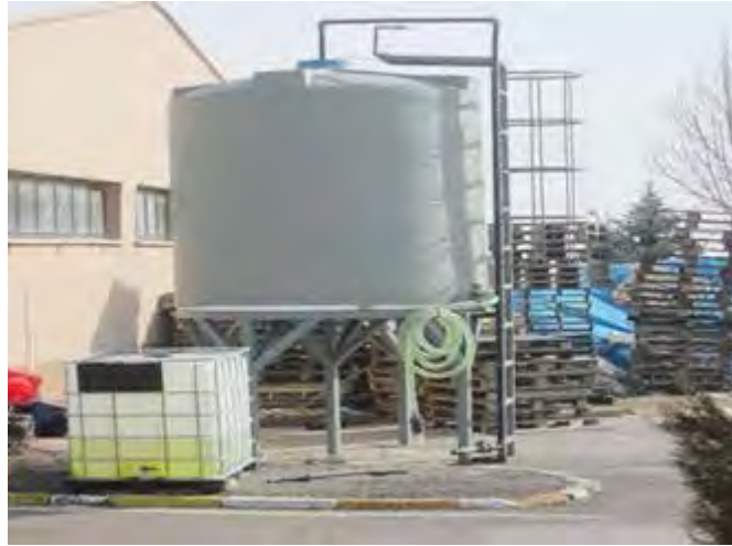
RESİM 4. 10 TONLUK KLOR DEPOLAMA TANKI
