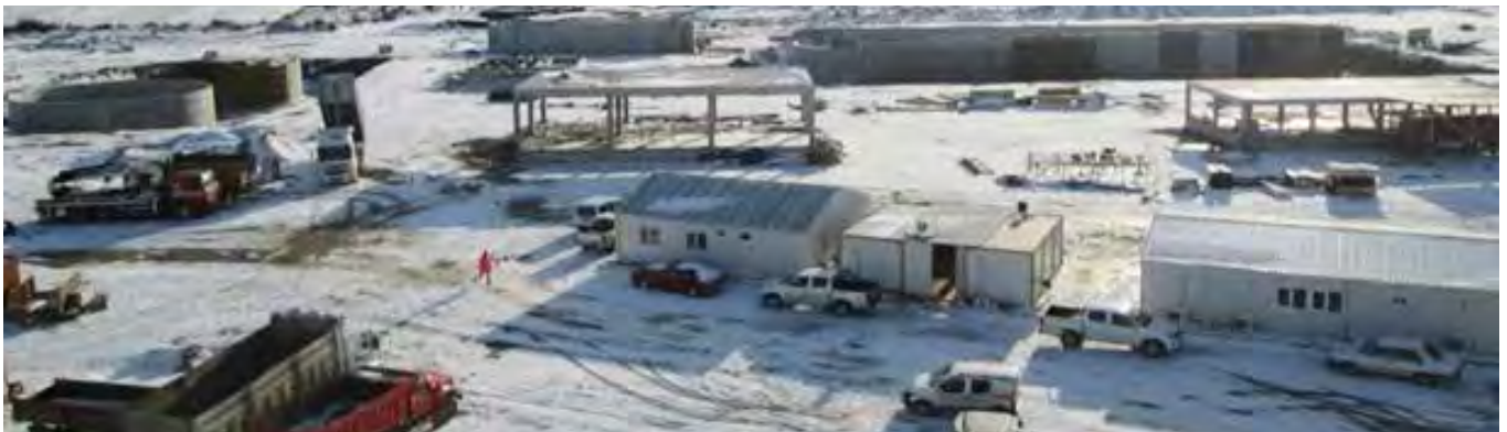
Fotoğraf 35. Seydişehir Atıksu Arıtma Tesisi
