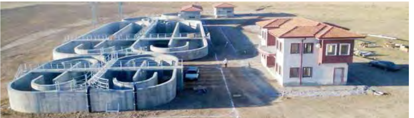
Fotoğraf 36. Sarayönü Atıksu Arıtma Tesis i
