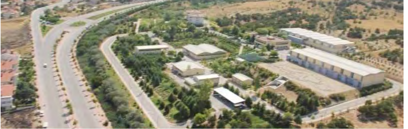
Resim 4. Konya İçme Suyu Arıtma Tesisi
