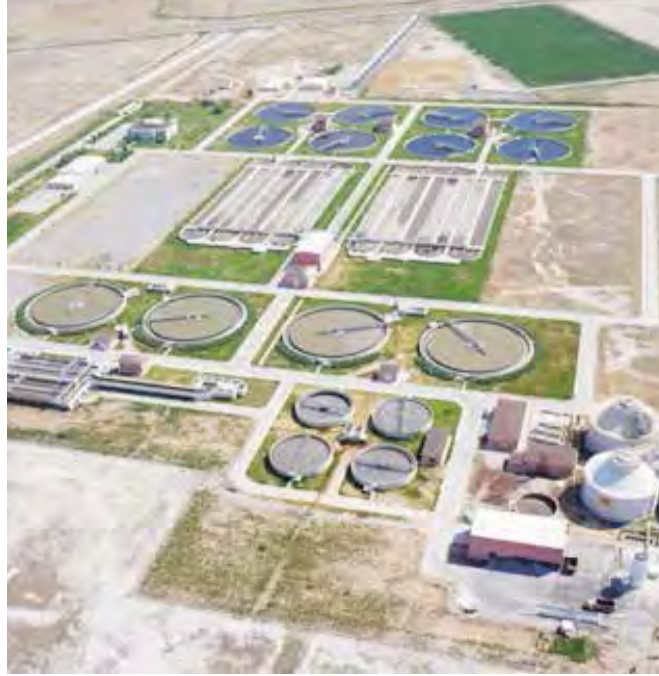
Fotoğraf 1. Konya Atıksu Arıtma Tesisi
