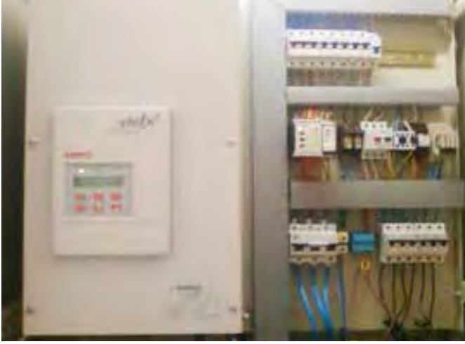
SOFT STARTER VE FREKANS KONVERTÖRÜ
