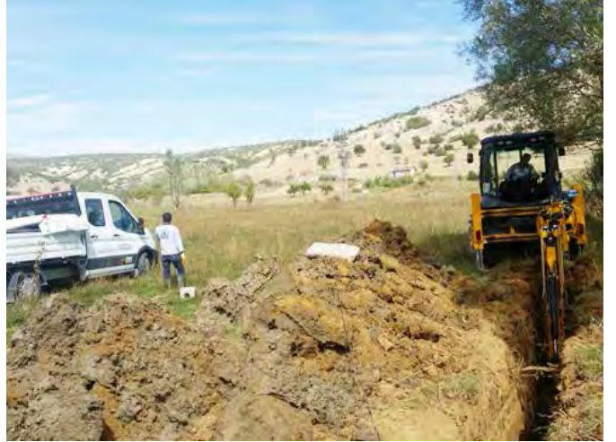
TEPE KENT YENİ ÇELİK BORU HATTINA YENİ RE- DRESÖRLÜ KATODİK KORUMA TESİSİ MONTAJI YAPILDI.
