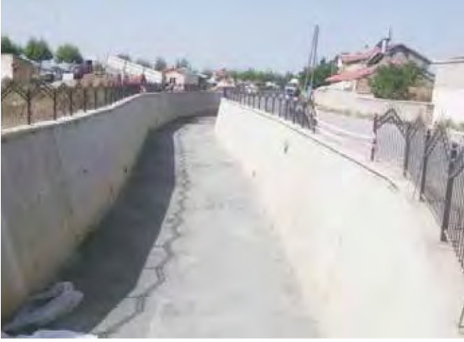
MERAM SELBASAN ÇAYI SAHA BETONU
