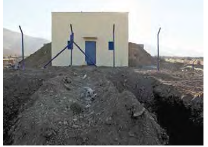
YENİ DEPO YAPIMI İLE İLGİLİ ÖRNEK RESİMLER LADİK MERKEZ 300 M 3 'LÜK GÖMME SU DEPOSU
