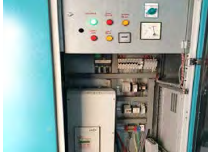
TOKİ TERFİ ELEKTRİK PANOLARI VE SCADA REVİZYONU
