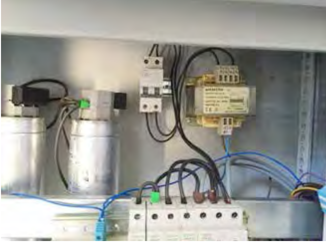
ILGIN-YUNAK VE YUNAK PIRIBEYLİ KORUMA AMAÇLI İZOLASYON TRAFOSU MONTAJI
