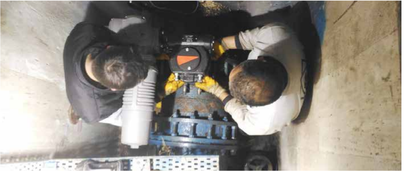
Resim 3. Filtre ünitesi DN 450'lik aktuatör vana değişimi.
