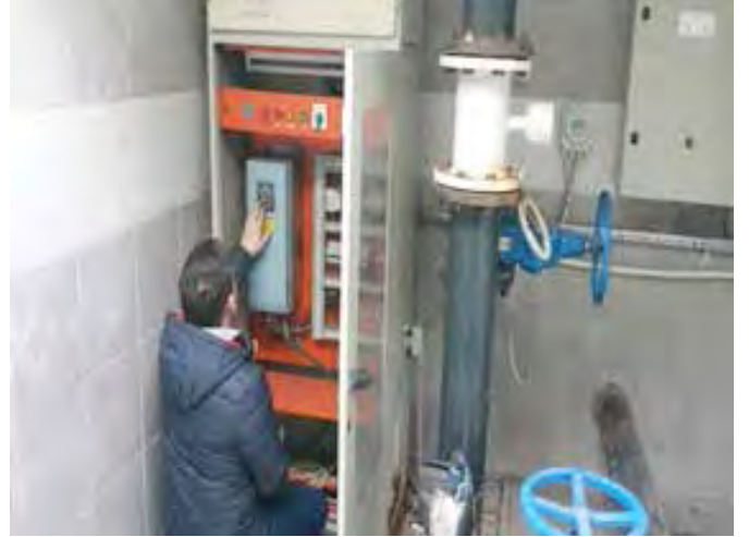
ARIOĞLU-1 KUYUSU SCADA MONTAJI
