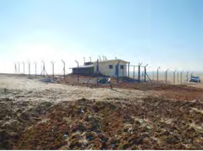
KULU – YAZIÇAYIR MAH. 100 M 3 'LÜK SU DEPOSU
