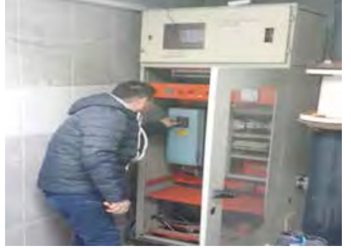
SOFT STARTER VE FREKANS KONVERTÖRÜ
