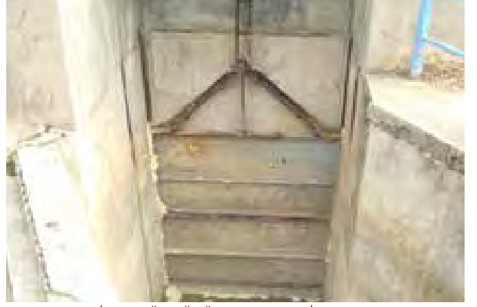
RESİM 8. SÜRGÜLÜ KAPAK TAMİR SONRASI.
