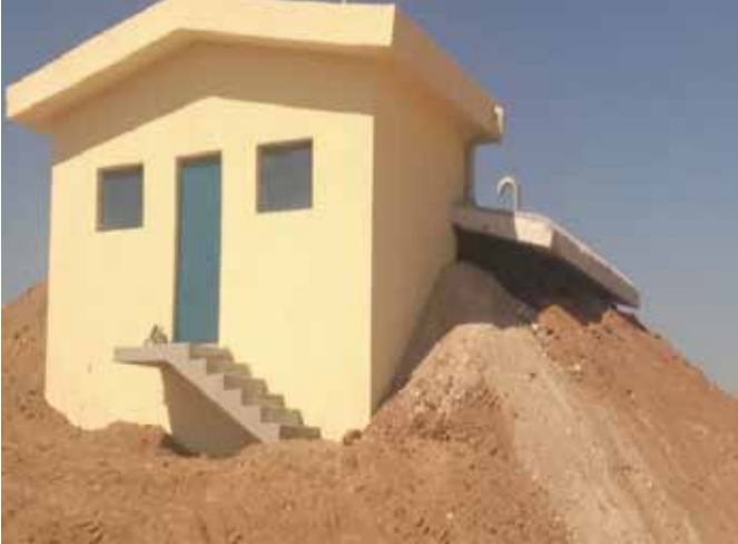
ÇUMRA DİNEKSARAY 100 M3 LÜK GÖMME SU DEPOSU
