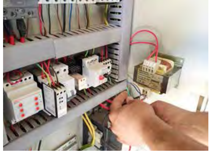
ILGIN-YUNAK VE YUNAK PIRIBEYLİ KORUMA AMAÇLI İZOLASYON TRAFOSU MONTAJI
