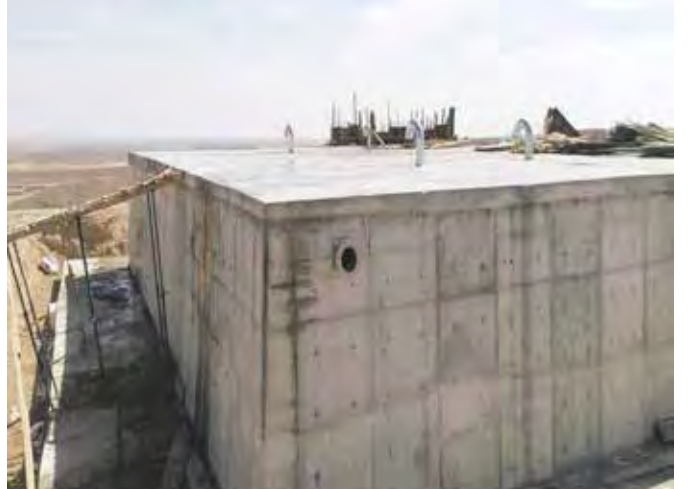
EREĞLİ MERKEZ 10.000 M3 LÜK GÖMME SU DEPOSU
