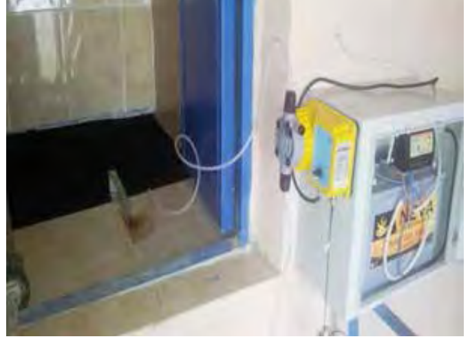
RESİM 2-3. DEPOLARDA GÜNEŞ PANELLİ OTOMATİK KLORLAMA SİSTEMİ
