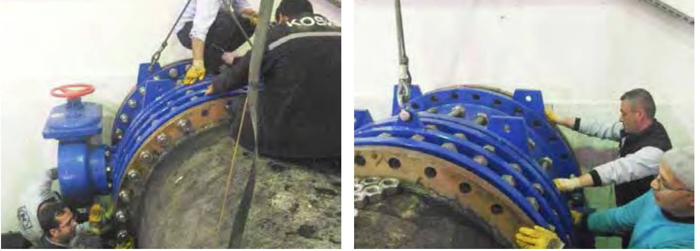
RESİM 4-5. ARİF BİLGE (P3) POMPA İSTASYONUNDA, DN 1300'LÜK KELEBEK VANANIN YERİNE MONTAJI.
