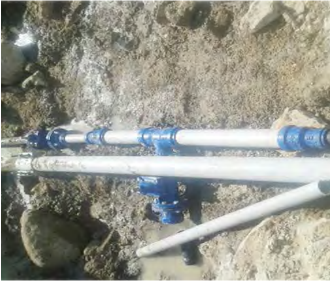
Çumra İlçesi Adakale Mahallesi Yeni Şebeke Çalışması
