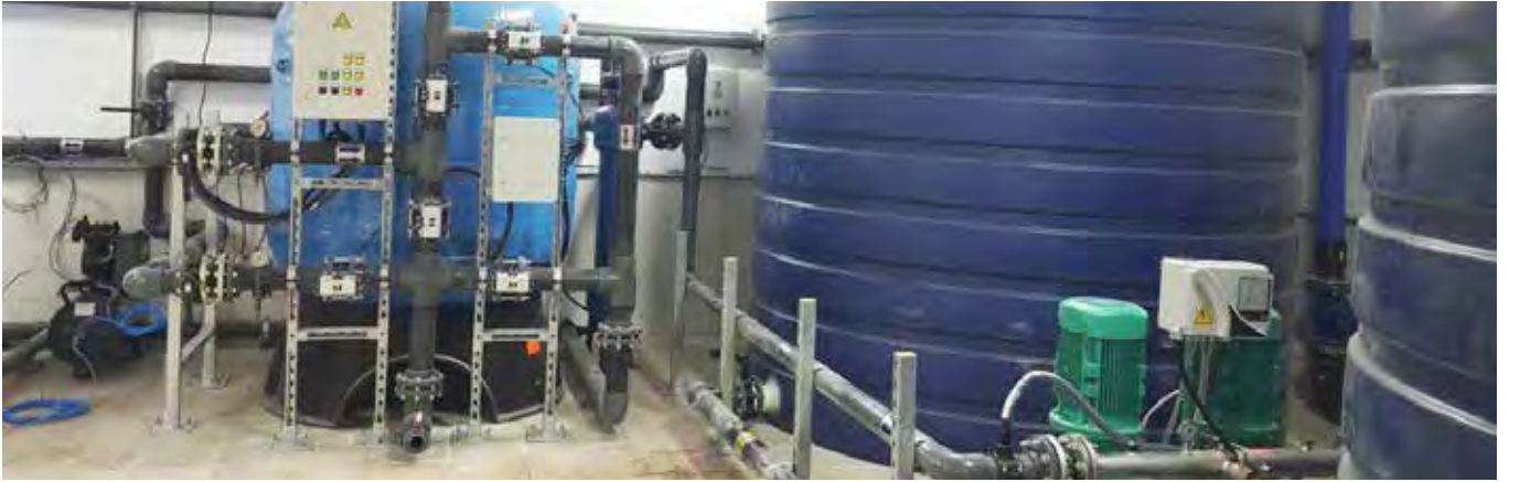
Resim 5. Çumra Tahtalı Paket Arıtma Tesisi
