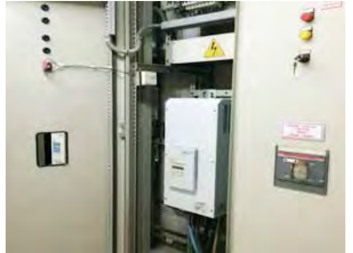
ALAVARDI POMPA İSTASYONU 3. MOTOR SOFT STARTER DÖNÜŞÜMÜ
