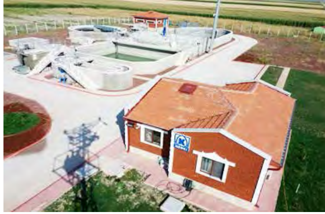
Fotoğraf 22. Ortakaraören Atıksu Arıtma Tesisi
