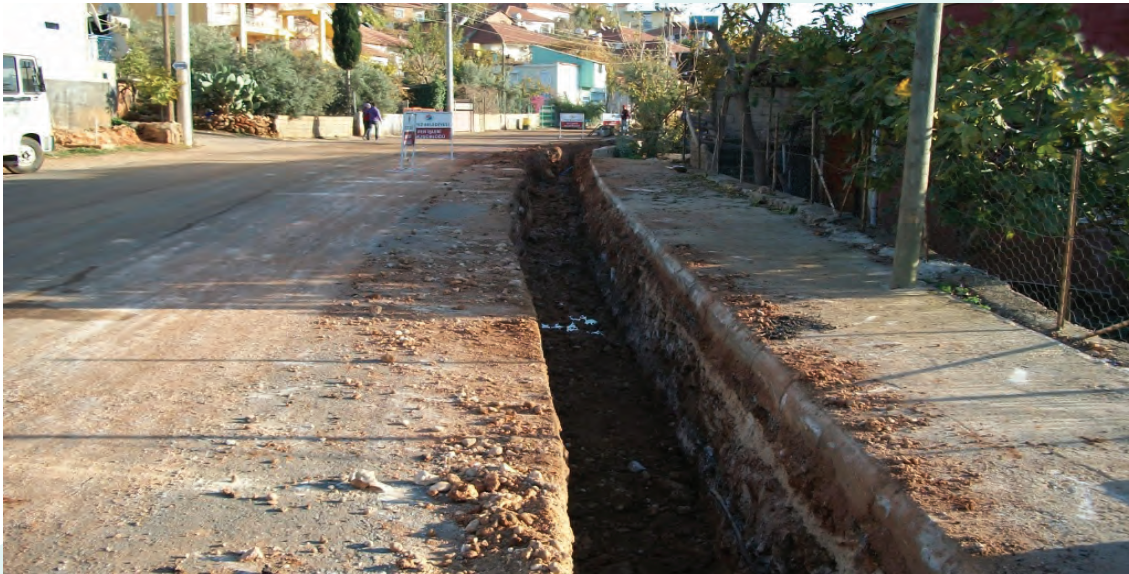
❖ Yağmur Suyu Drenaj Çalışması
