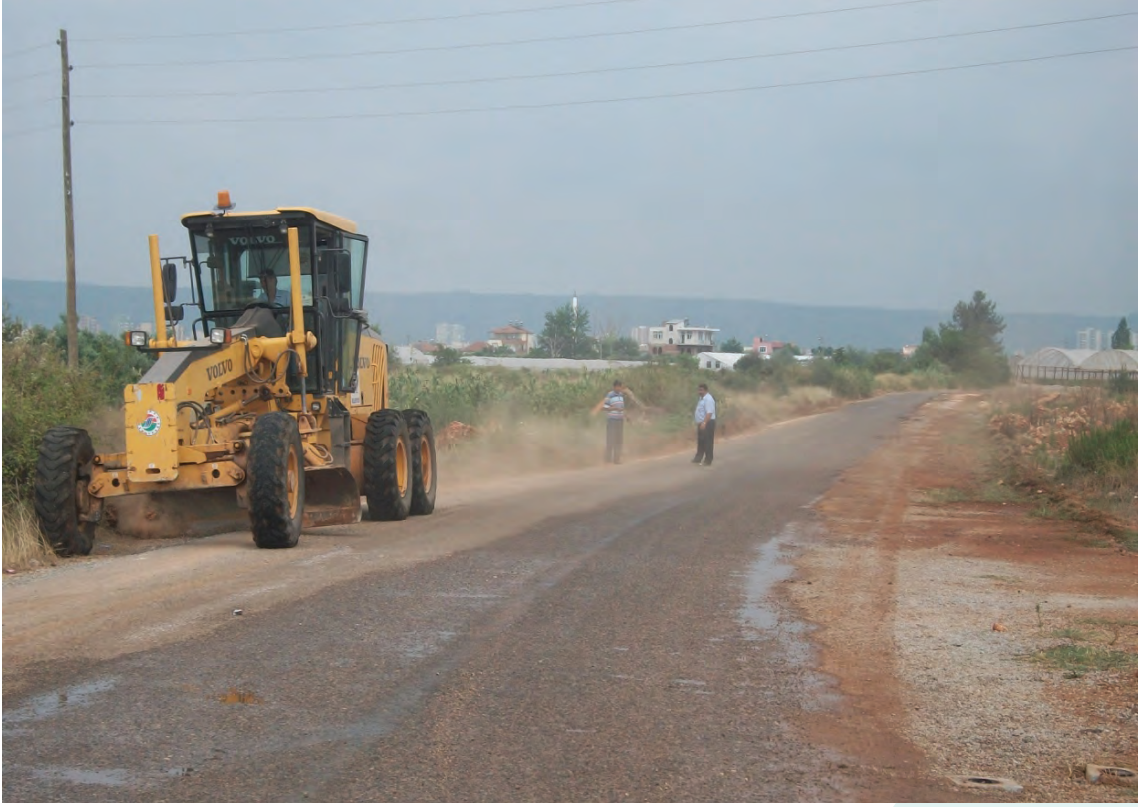
❖ Yol Yapım Çalışmaları
