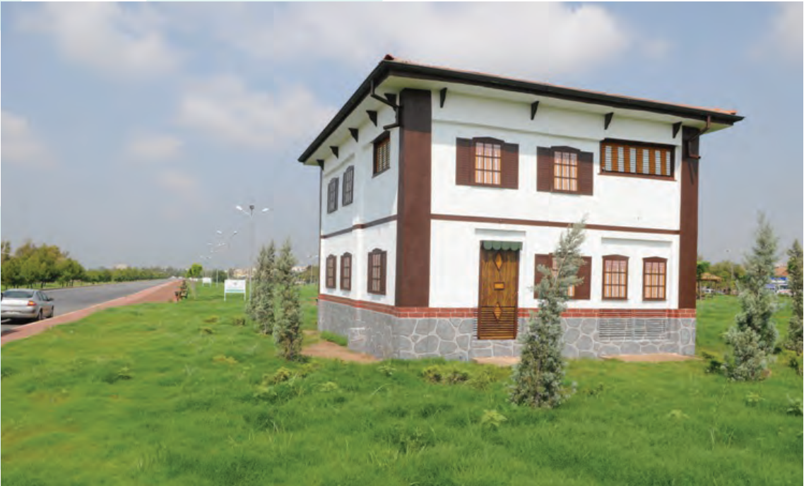
❖ Gülveren Mahallesi Trafo Çalışması
