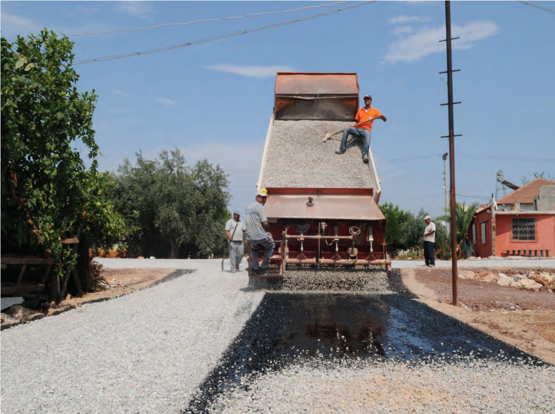
❖ Sathi Kaplama Asfalt Serim Çalışması
