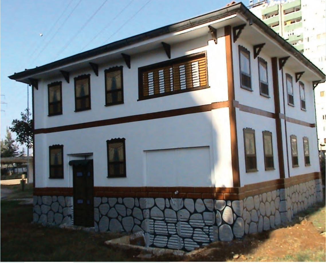
❖ Trafonun Düzenlendikten sonraki hali
