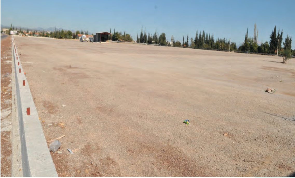
❖ Baraj Mahallesi Açık Araç Pazarının Stabilize Döşeme Esnasındaki Görüntüsü
