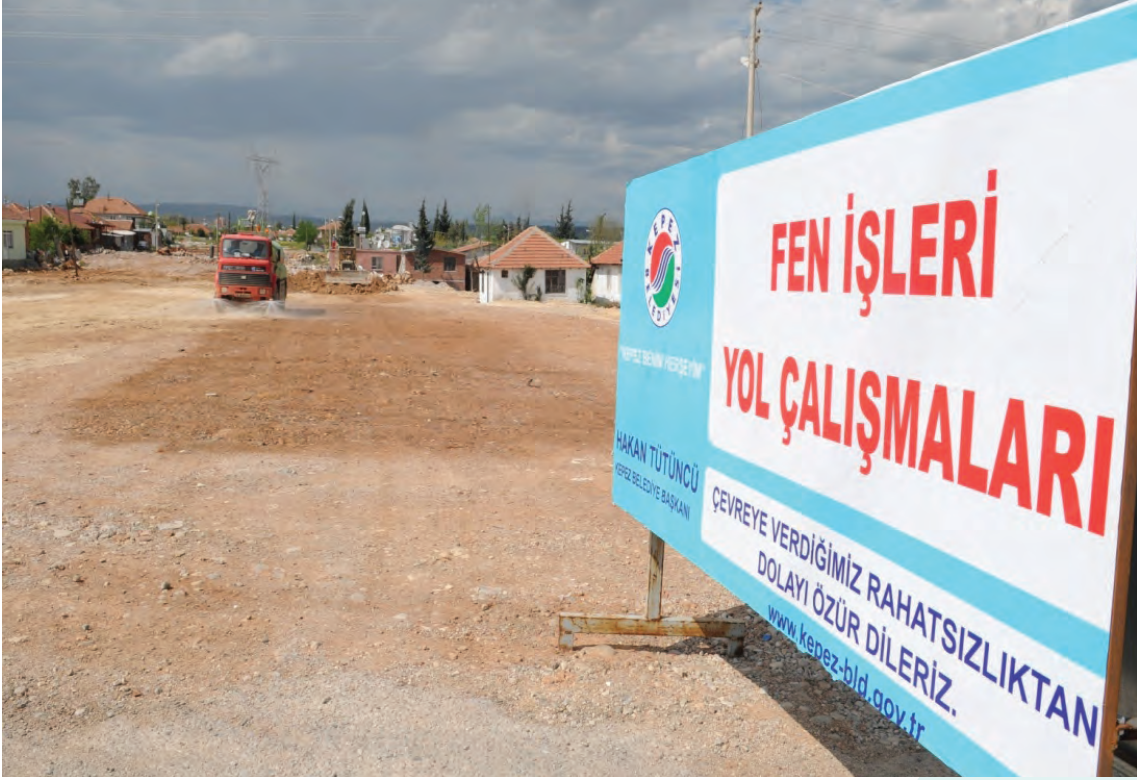
❖ Gazi Mahallesi Stabilize Yol Yapım Çalışması
