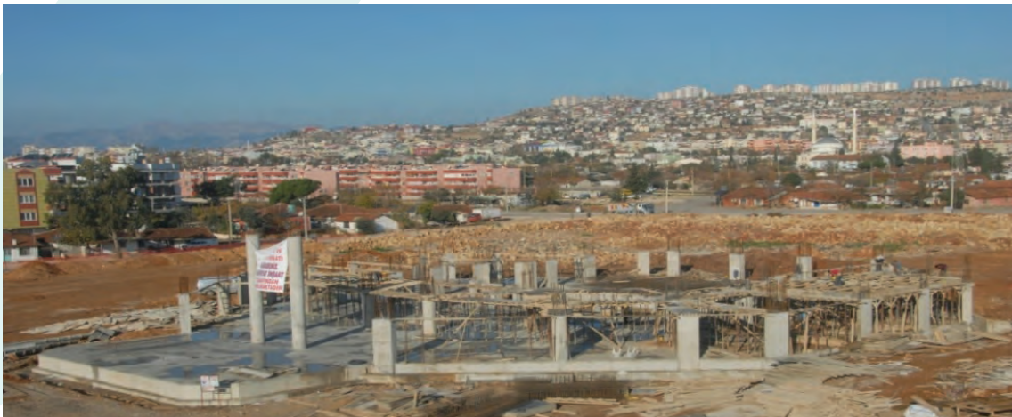
❖ Kültür Merkezi İnşaatı
