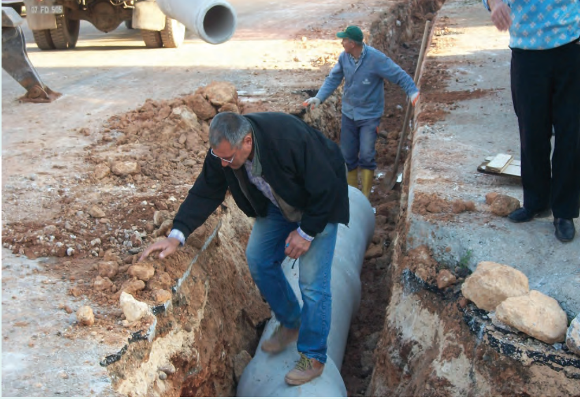
❖ Yağmur Suyu Menfez (Büz) Döşeme Çalışması
