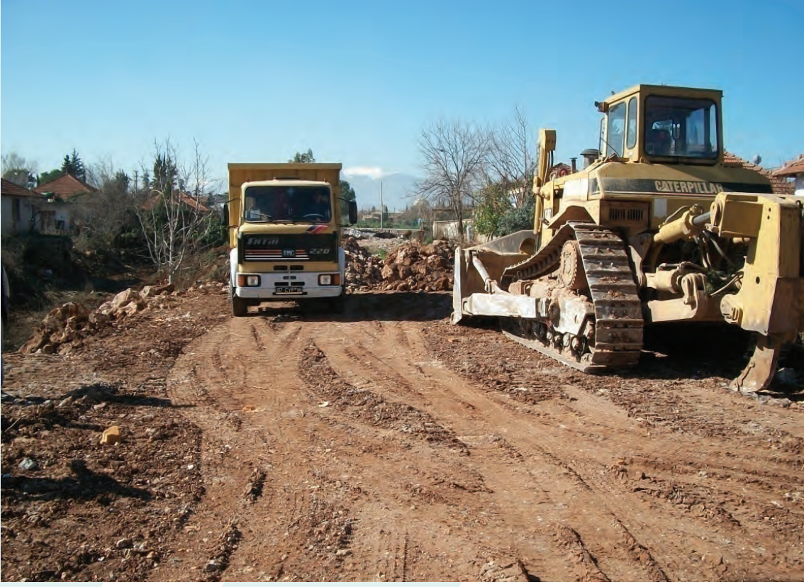
❖ Yeni Açılan Yol Çalışması
