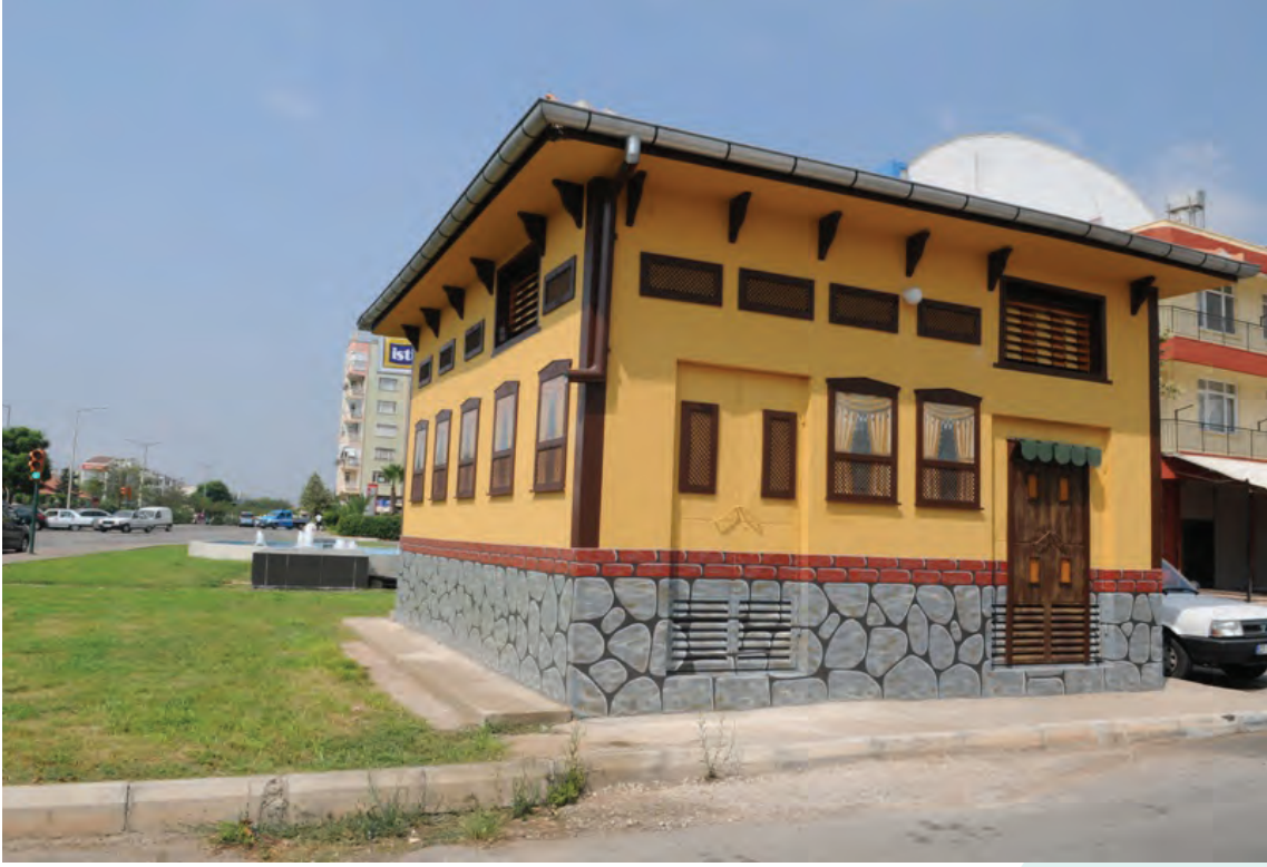
❖ Yükseliş Mahallesi Trafo Çalışması
