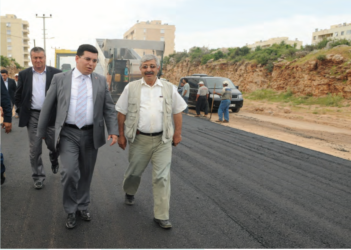
❖ Çankaya Mahallesi Sıcak Asfalt Serme Çalışması
