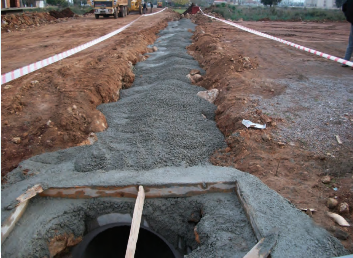
❖ Yağmur Suyu Drenaj Çalışması
