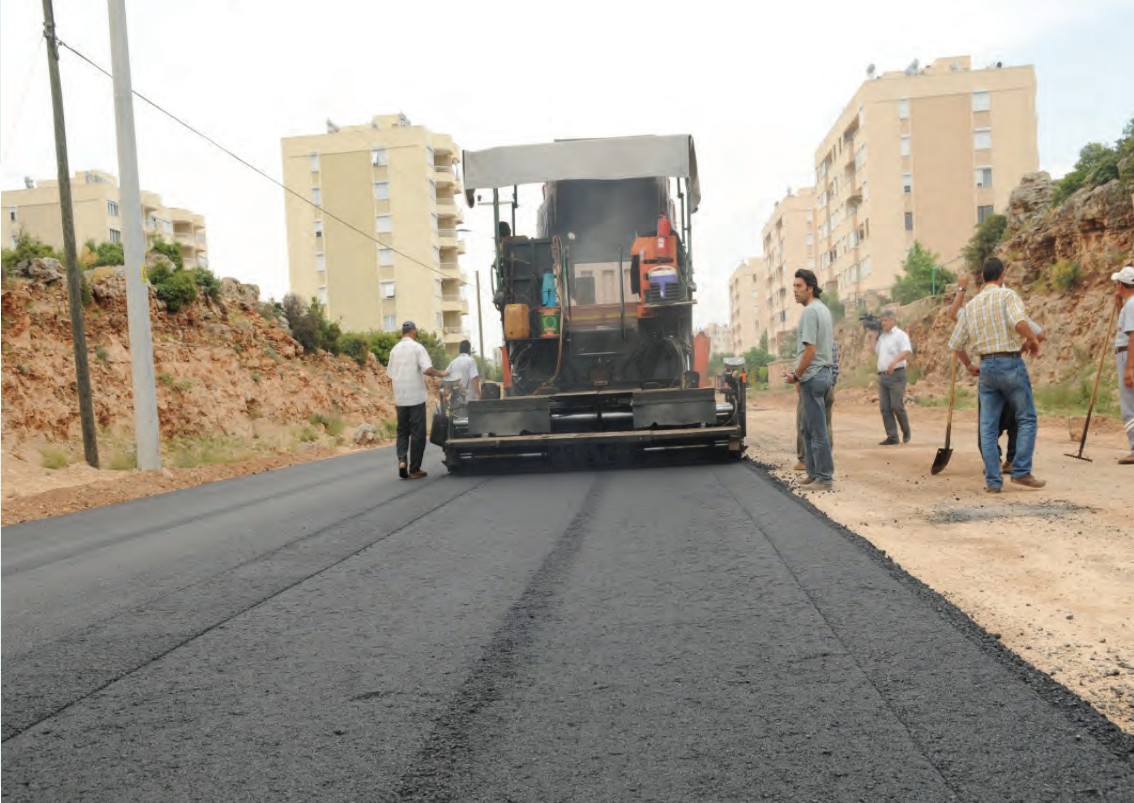
❖ Çankaya Mahallesi Sıcak Asfalt Serme Çalışması
