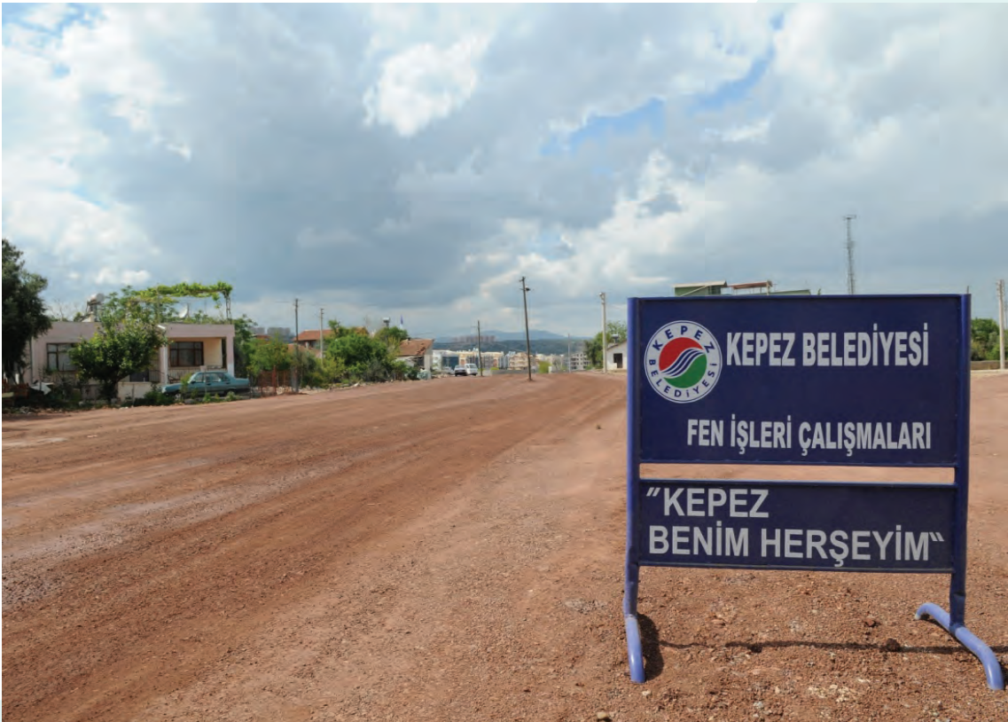
❖ Gazi Mahallesi Stabilize Yol Yapım Çalışması
