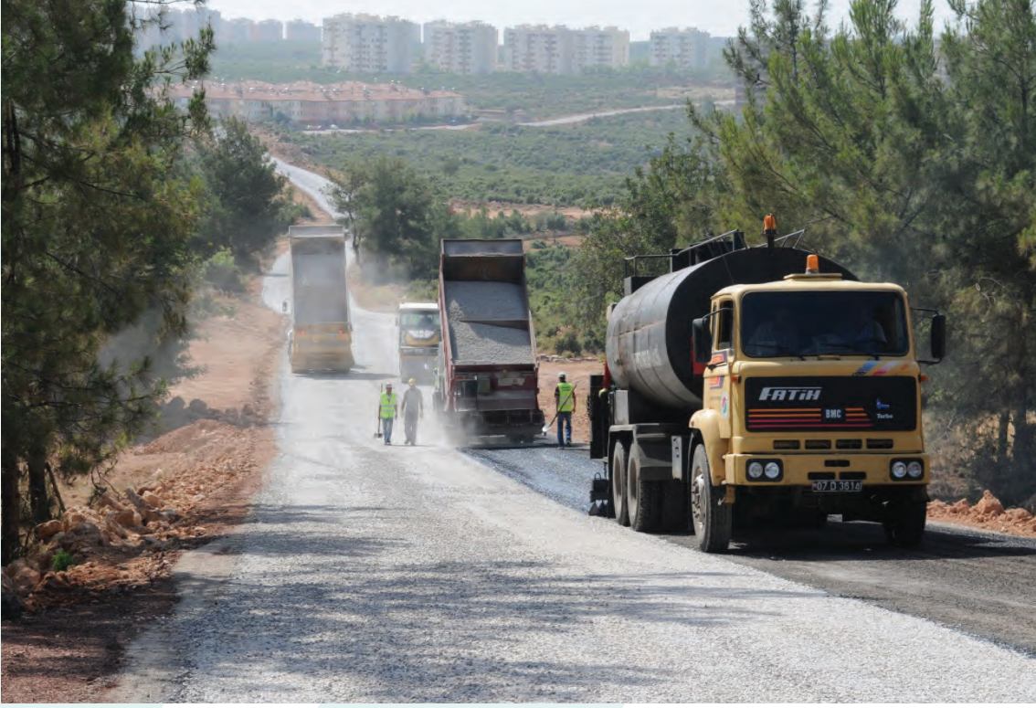
❖ Sathi Kaplama Asfalt Serme Çalışması
