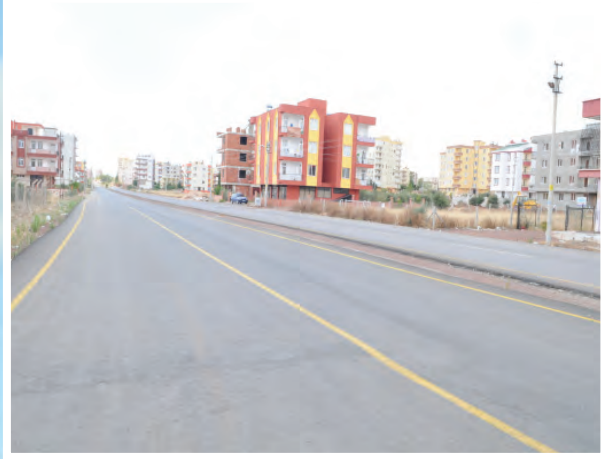
❖ Varsak Karşıyaka Mahallesi Sıcak Asfalt Çalışması (Bitmiş Hali)
