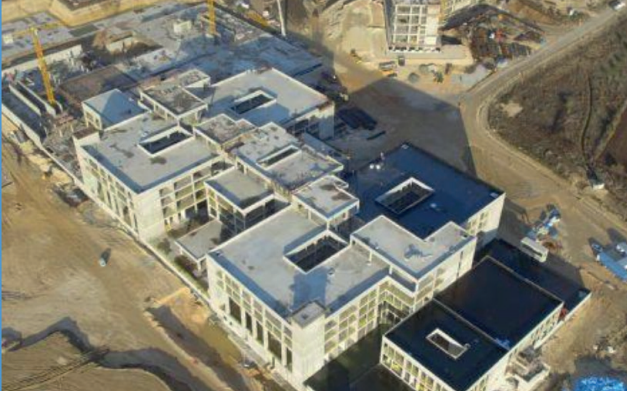
Bursa Şehir Hastanesi
