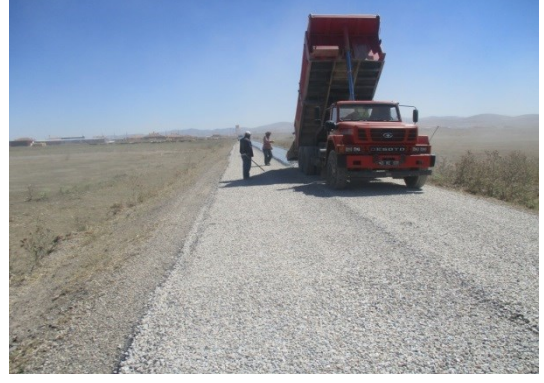
1. Kat Asfalt Çalışmaları
