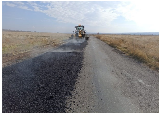
Asfalt Yama Çalışmaları
