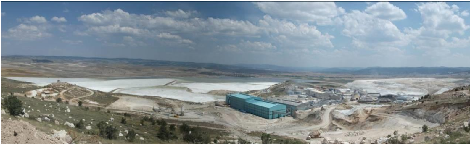
Şekil 2.2: Kırka Bor İşletme Müdürlüğünden Bir Görünüş
