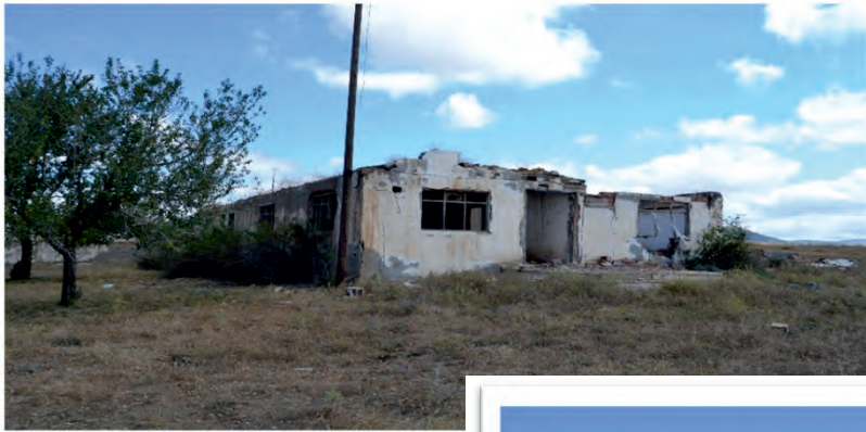
Merkez Yatmış Köyü Metruk Bina
