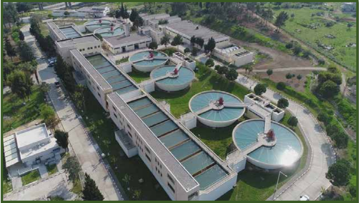
Berdan İçme Suyu Arıtma Tesis
