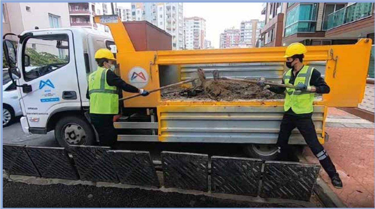
Yağmur Suyu Izgara Çalışmaları
