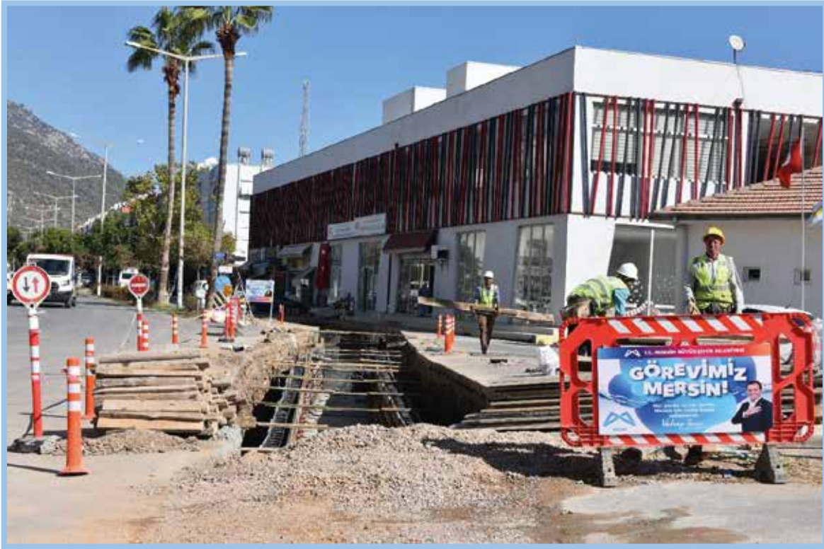
Bozyazı İlçesi Yağmur Suyu Hattı Çalışması
