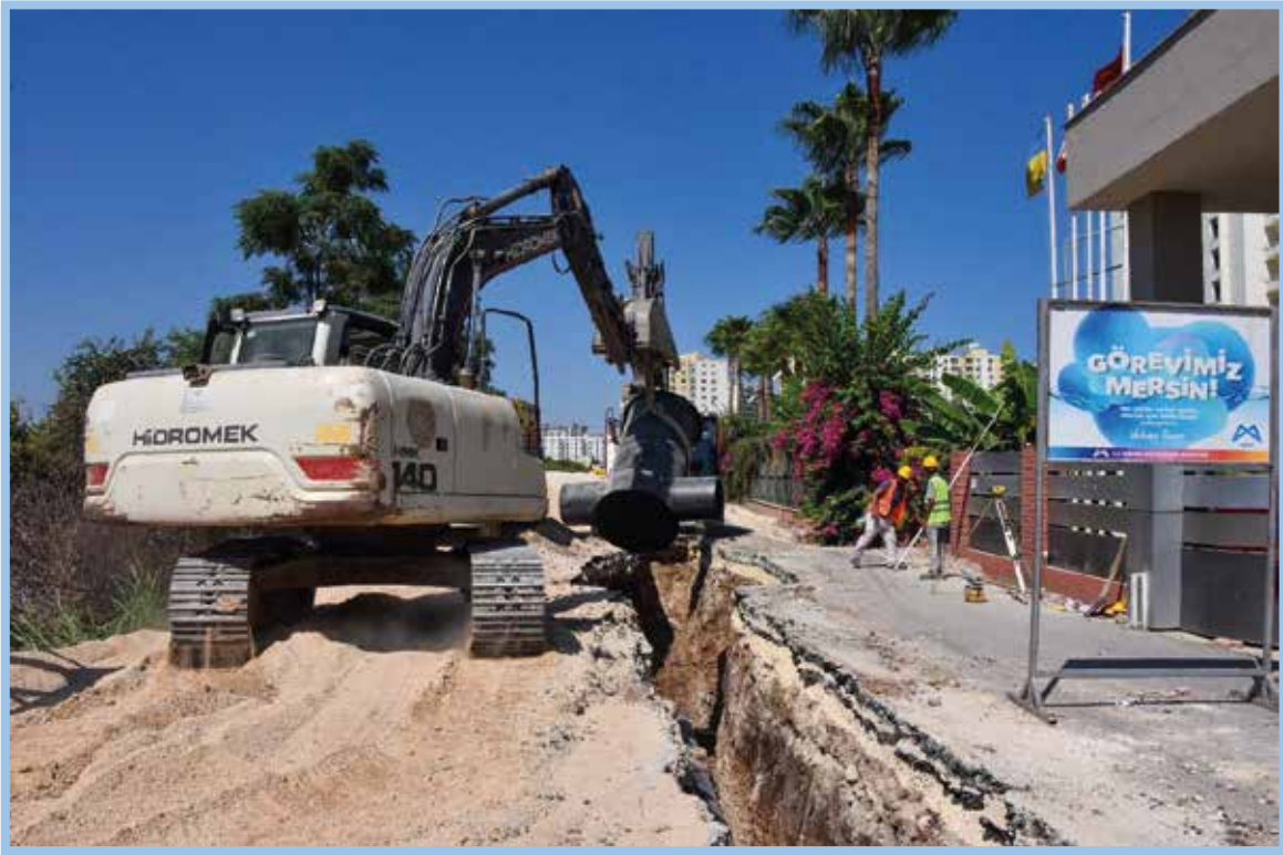
Erdemli İlçesi Kanalizasyon Hat Çalışması
