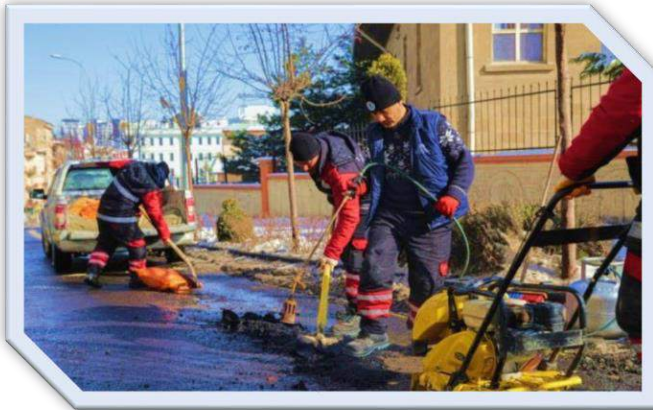
Bozuk yollar ve yaya kaldırımları onarıldı.
