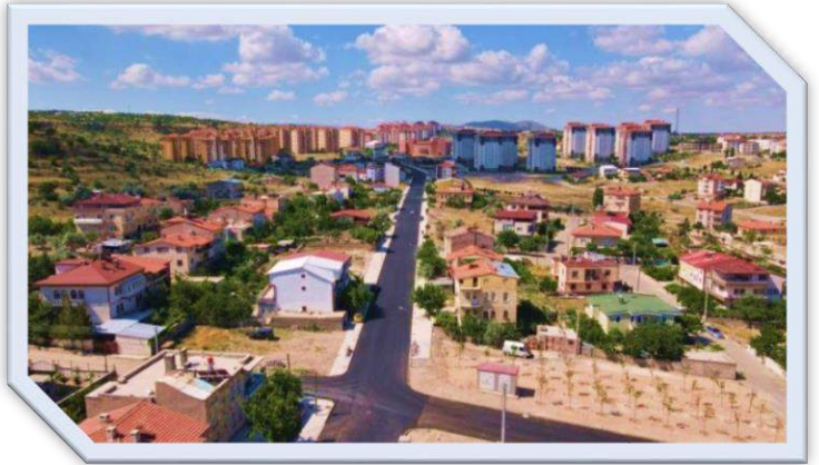
Mehmet Akif Ersoy Mahallesi'nde sıcak asfalt çalışmaları tamamlandı.
