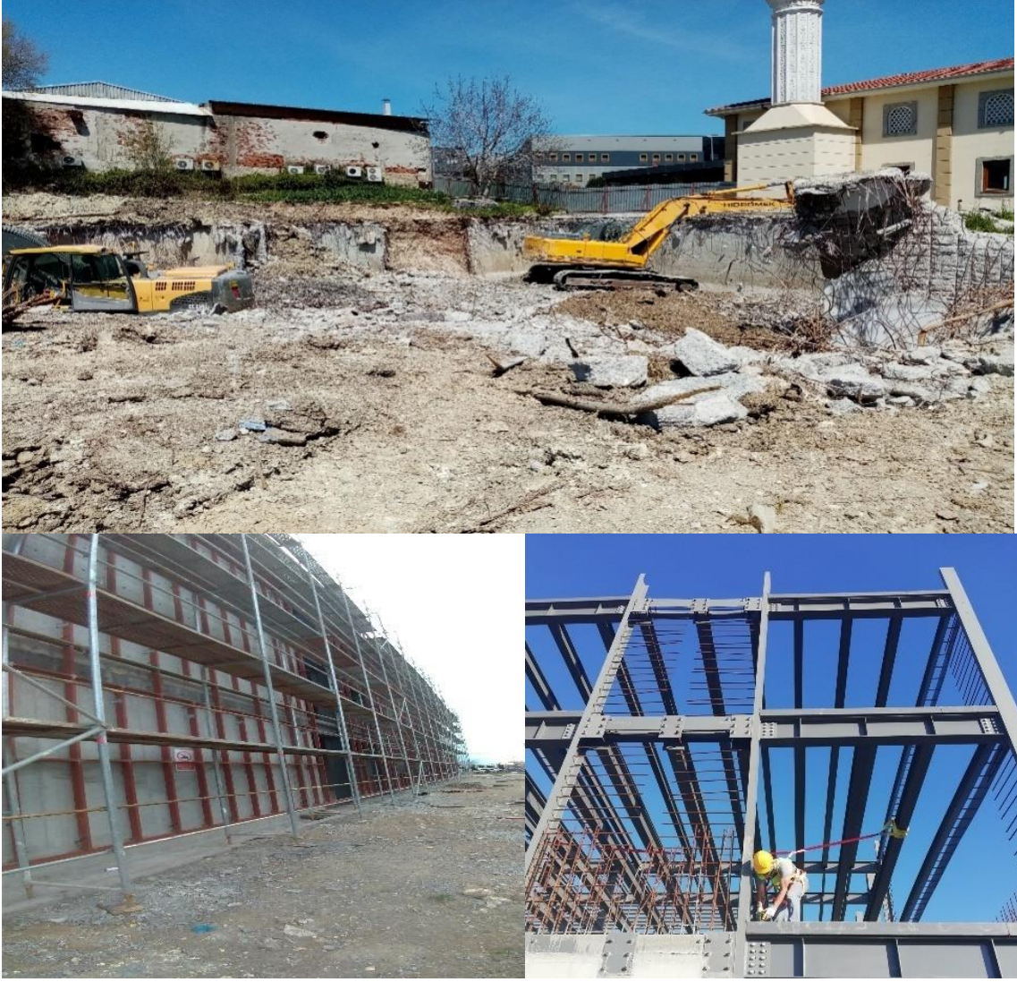
Resim 29- İstanbul Üniversitesi-Cerrahpaşa Rektörlüğü, Merkez Yerleşke, Yeniden Yapılanma Kapsamında Yapılan Çalışmalar
