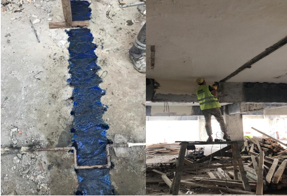
Resim 38- Cerrahpaşa Tıp Fakültesi Muhtelif Binaların Güçlendirilmesi
