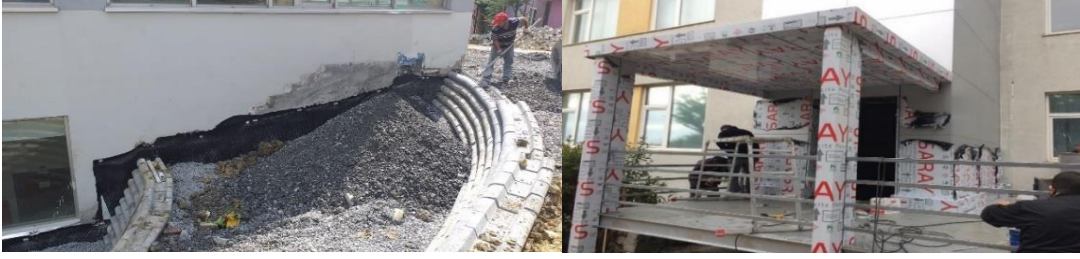
Resim 32- Cerrahpaşa Tıp Fakültesi, Onarım Çalışmaları
