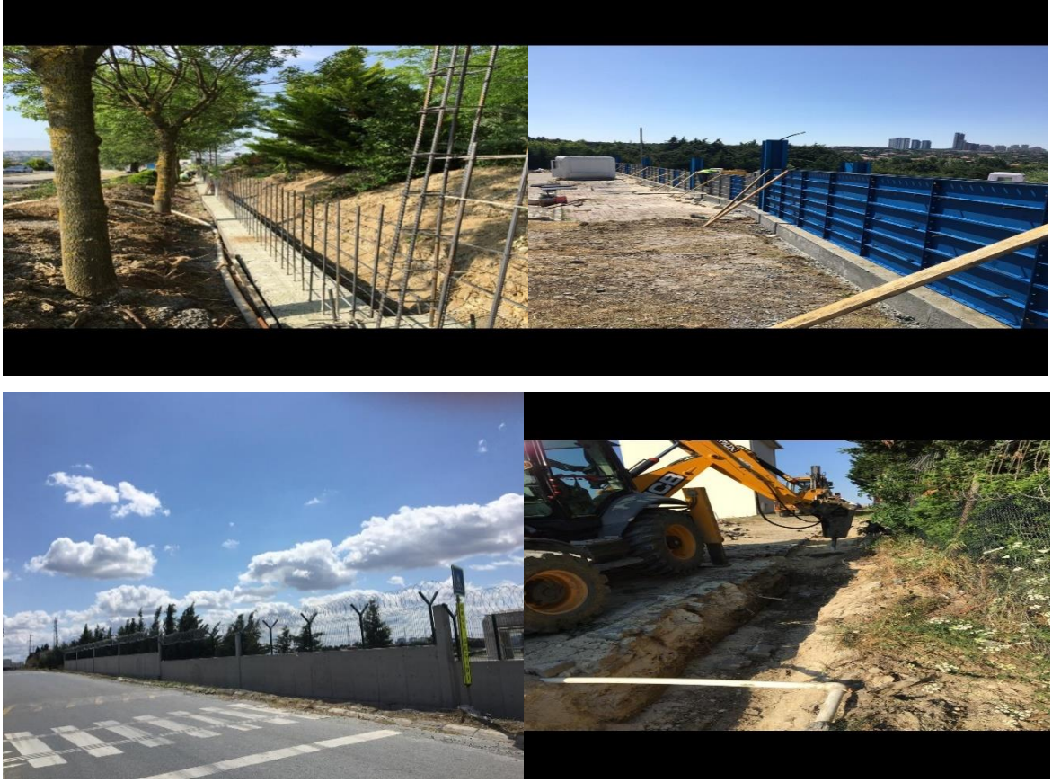
Resim 34- Muhtelif Çevre Duvarı İnşaatı
