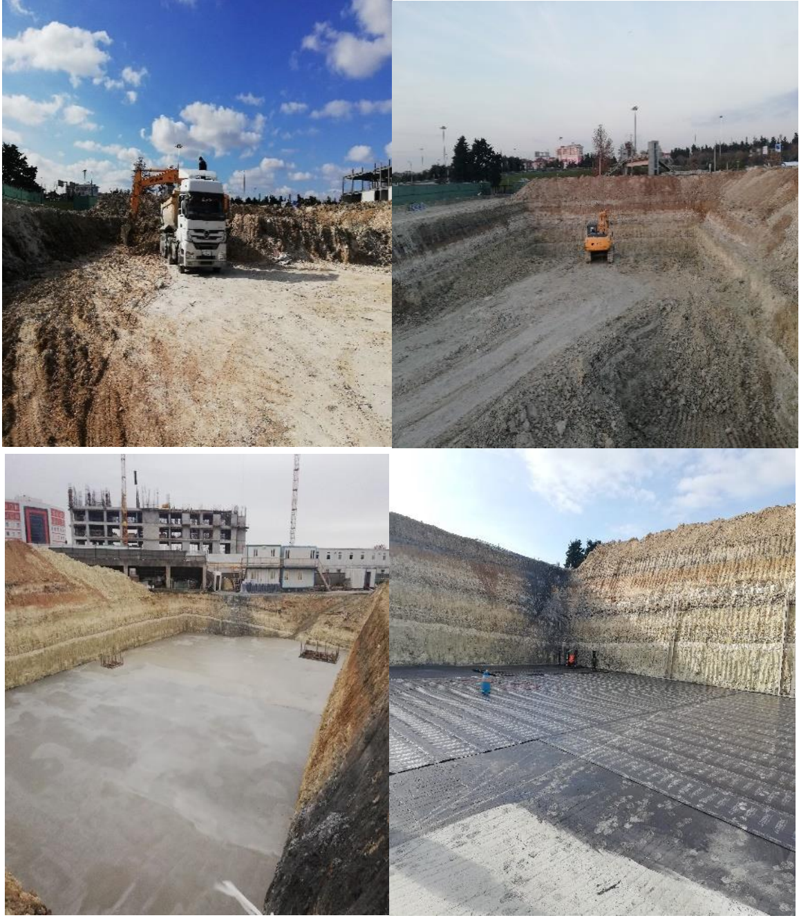
Resim 30- İstanbul Üniversitesi-Cerrahpaşa Rektörlüğü, Merkez Yerleşke Mühendislik Fakültesi Yenileme Çalışmaları
