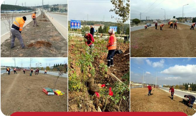
Pelitözü Kavşağı Çevre Düzenlemesi
