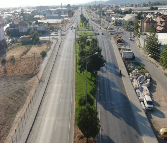
Fethiye-Antalya Çevre Yolu- Osman Kaya-Fevzi Çakmak-Cumhuriyet Bulvarları orta refüj peyzaj düzenlemesi tamamlanmıştır.
