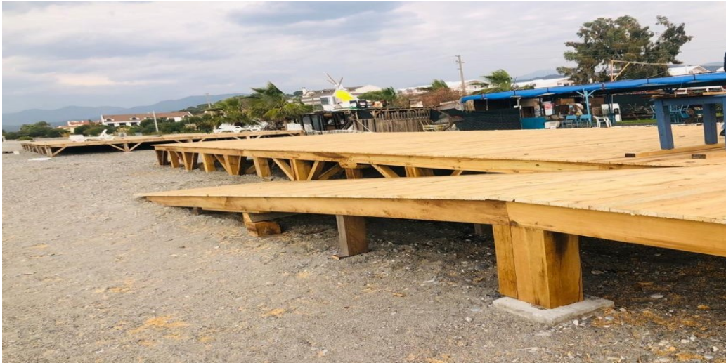
Koca Çalış Mevkii Halk Plajı Çalışmaları
