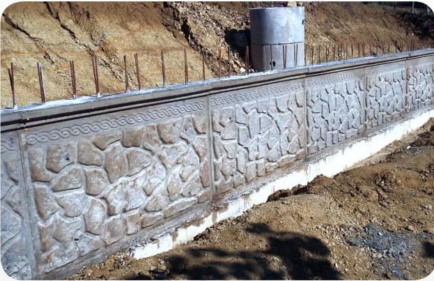
Çelik Kalıp Perde Duvar Çalışmaları
