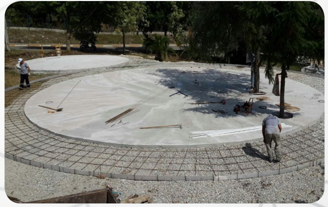
Baskı Beton Çalışmaları
