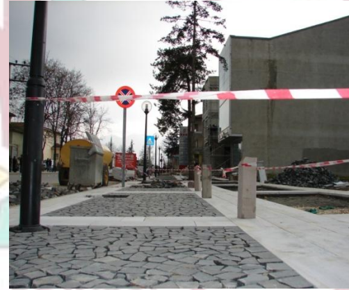
Spor sokak devamı ve Mehmet Akif caddesi Doğal Taş örme çalışması
