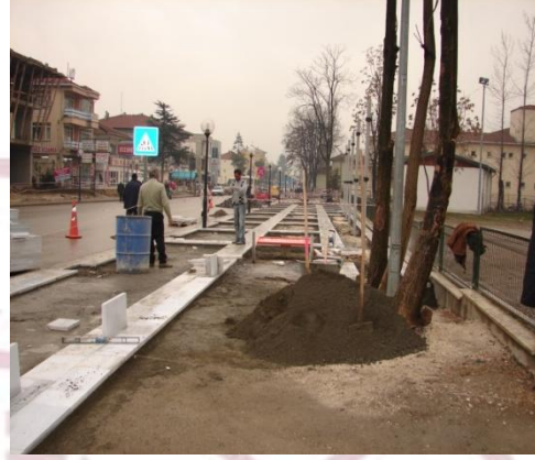
Kuyumcuzade Bulvarı Doğal Taş örme çalışması
