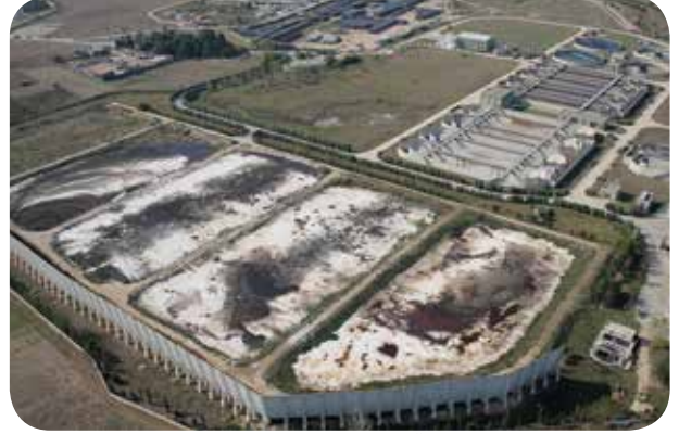
Batı (Özlüce) Atık Su Arıtma Tesis
