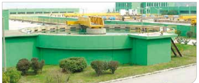
Dobruca İçmesuyu Arıtma Tesisi
