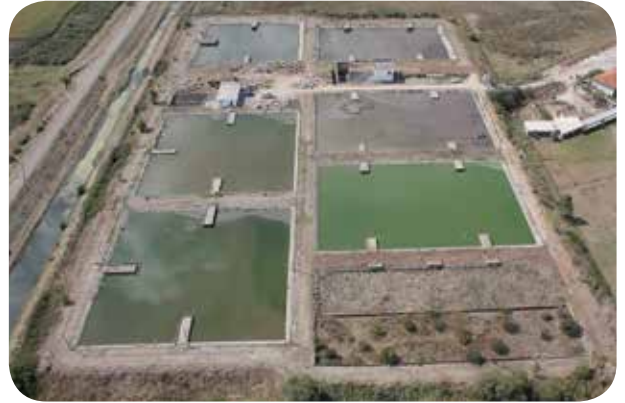
Karacabey Atık Su Arıtma Tesisi
