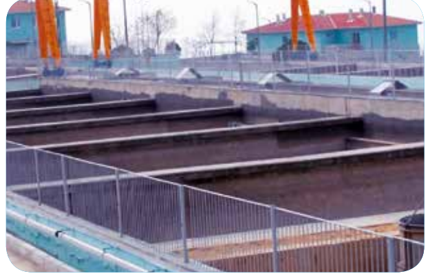
İçmesuyu Arıtma Tesisi
