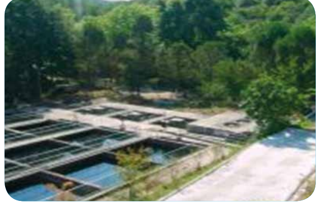
İçmesuyu Arıtma Tesisi
