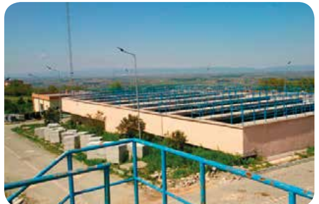
İnegöl Alanyurt İçmesuyu Arıtma Tesis
