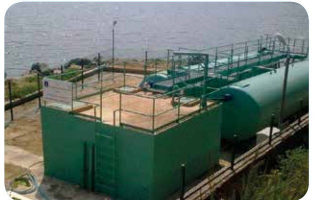
İçmesuyu Arıtma Tesisi
