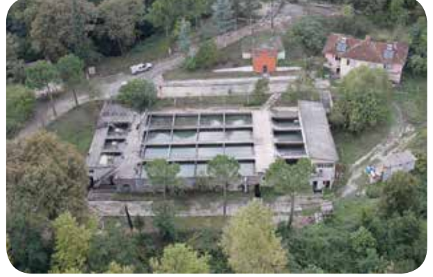
Mustafakemalpaşa Çan Deresi İçmesuyu Arıtma Tesisi
