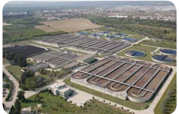
Doğu Atık Su Arıtma Tesisi
