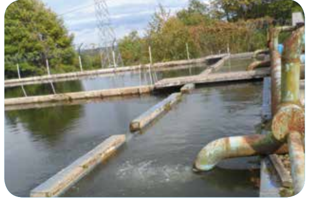
İçmesuyu Arıtma Tesisi
