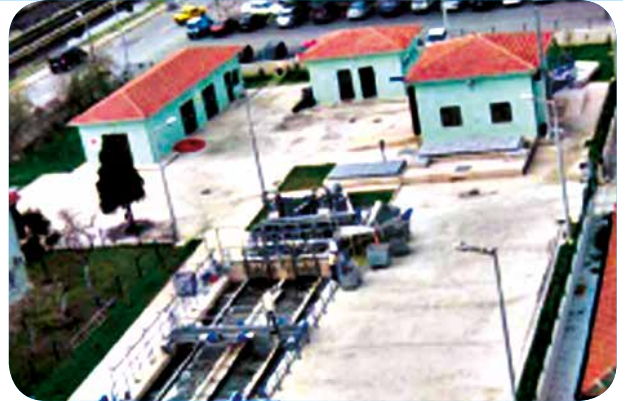
İçmesuyu Arıtma Tesisi
