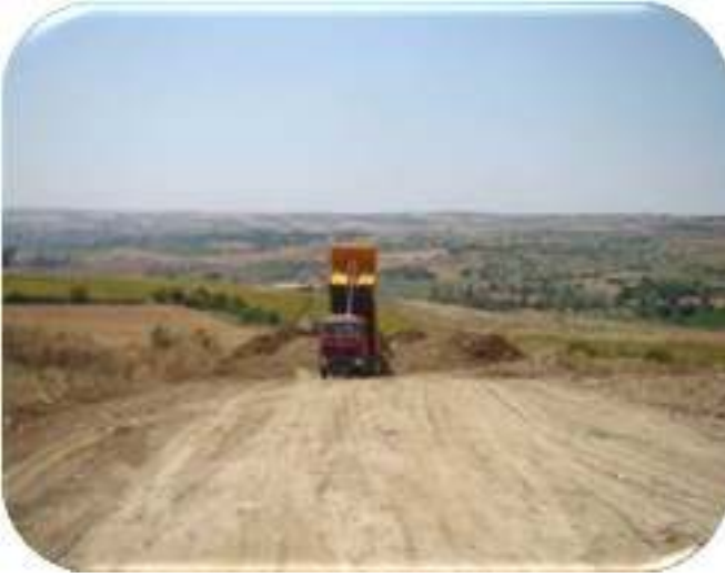
İnşaat ve hafriyat atıklarının depolanması.
