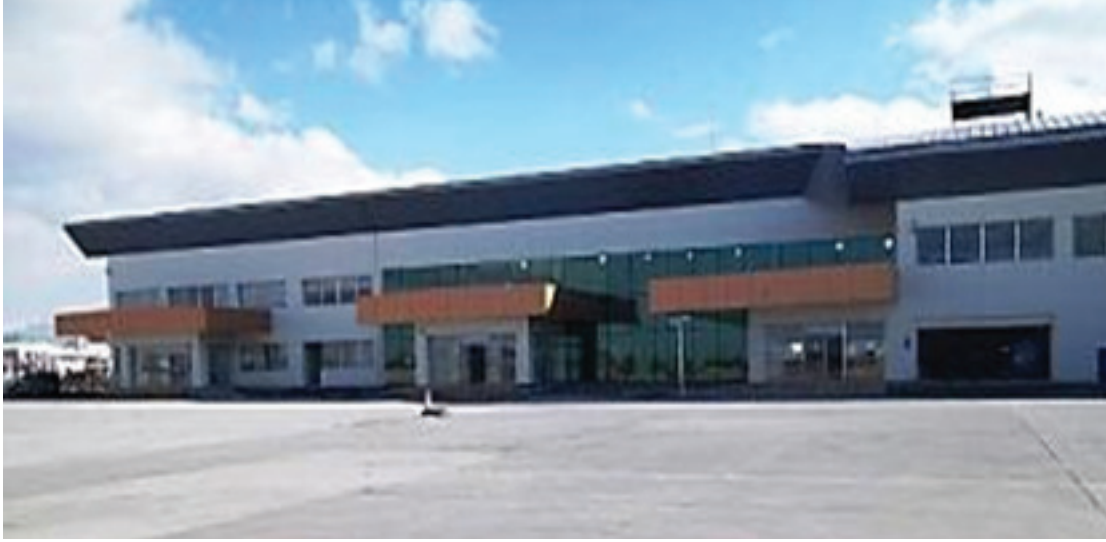
Van Ferit Melen Havalimanı Terminal Binası ile Teknik Blok ve Kule Yapımı
