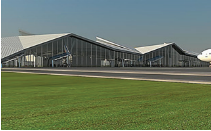
Kars Havalimanı Yapımı
