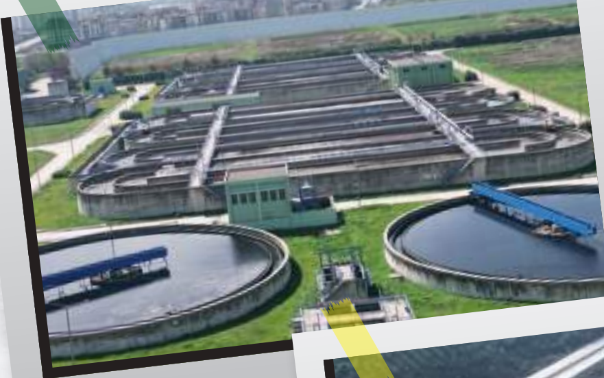
Batı Atıksu Arıtma Tesisi
