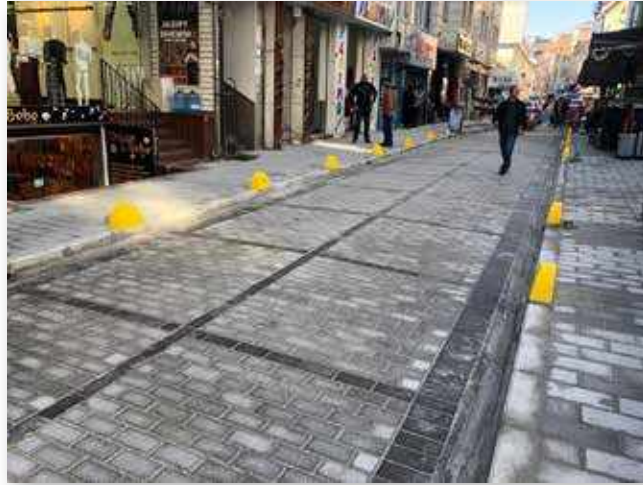
Asker Sokak Yol Yenileme Çalışmaları
