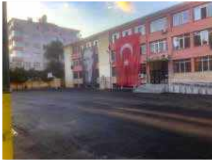
Çapa İlköğretim Okulu Bahçesinde Asfalt uygulaması
