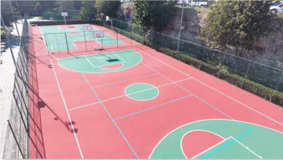
Basketbol Sahası Yeni Hali
