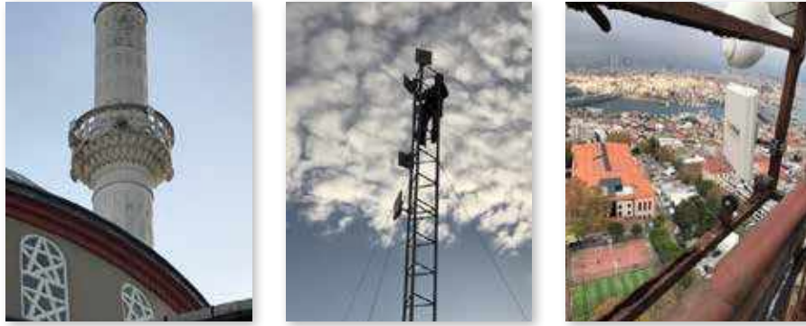
Radyolink Montaj Çalışması
