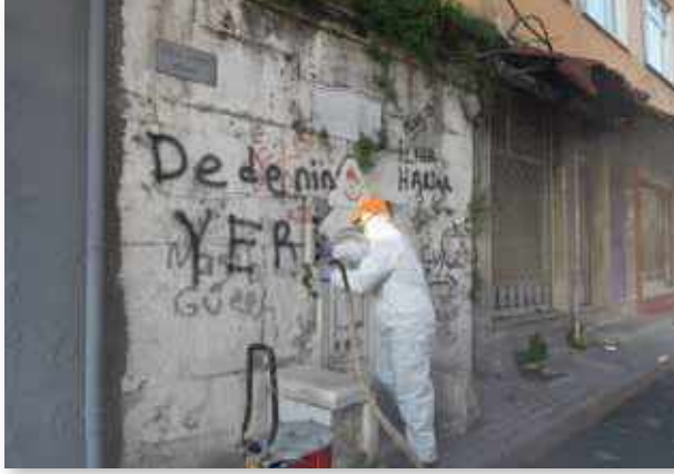
Tarihi Eserlerde Kumlama Tekniği ile Yazı Silme Çalışmaları
