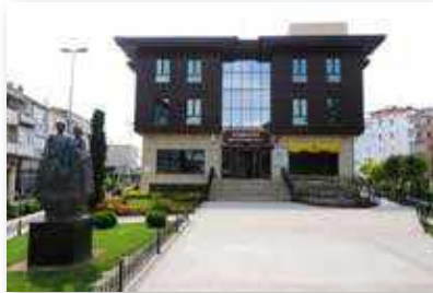
Silivrikapı Semt Konağı
