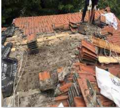
Derviş Ali Camii (Çatısı yenilenmiştir.)
