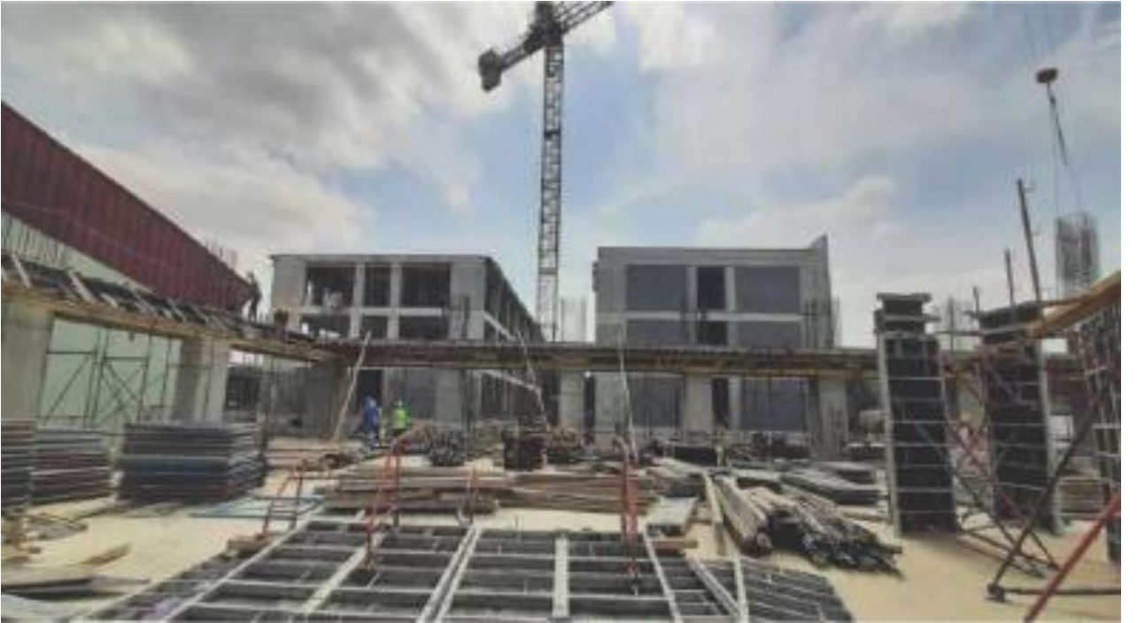
Dardanos Yerleşkesi Spor Bilimleri Fakültesi ve Spor Salonu İnşaatı
