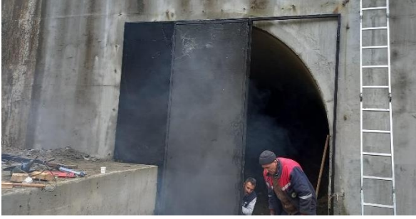
Karadere Tüneli kapısı montajı
