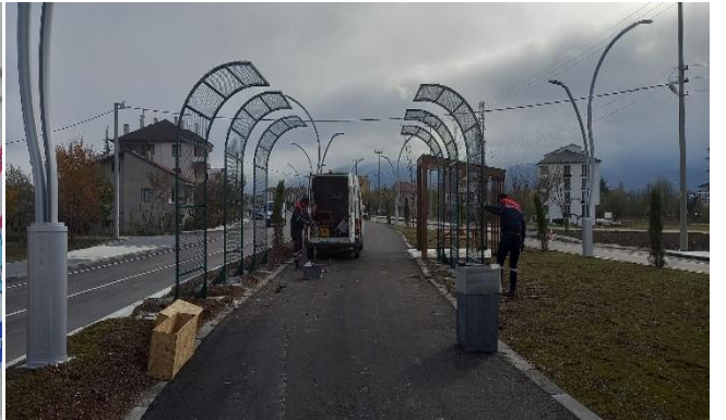
Sağlık Mahallesi kanal üzeri sarmaşık tüneli
