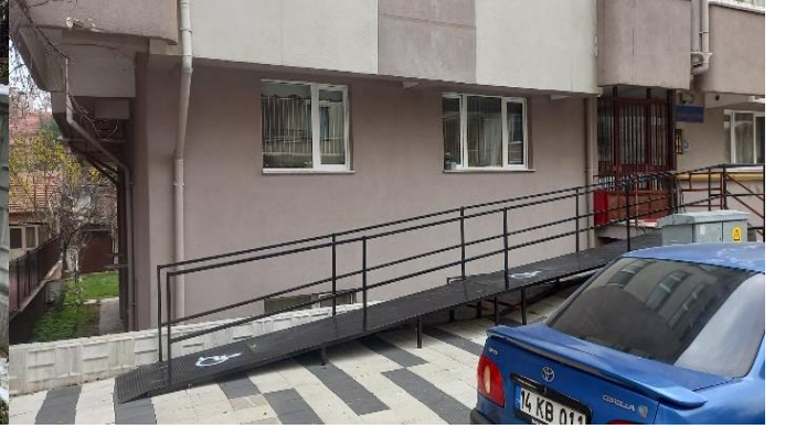
Bahçelievler Mahallesi engelli rampası
