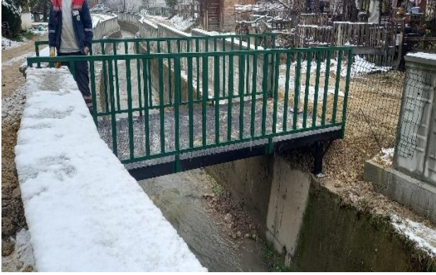
Alpağutbey Mahallesi dere üzeri yaya köprü imalatı
