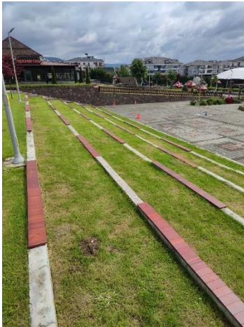
Beton üzeri ahşap oturak
