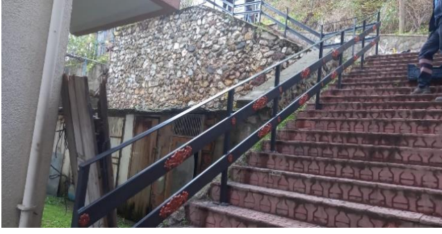
Gölyüzü Mahallesi Atatürk İlköğretim Okulu arkası korkulukları
