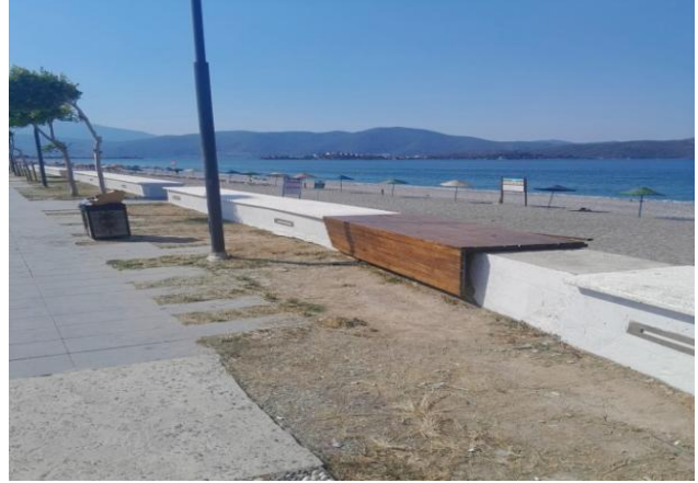
Çalış sahil bandı oturma alanı tamirat, boya ve yenileme çalışması
