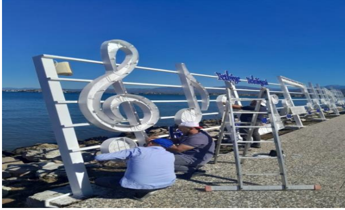
Sahil bandı nota aydınlatma, metal aksam boya ve yenileme çalışmaları
