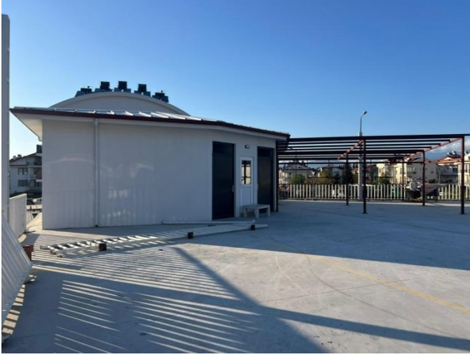
Patlangıç mahallesi 314 Sokak ve 317 sokak kesişiminde bulunan Perşembe Pazar alanına tuvalet binası yapılmıştır.
