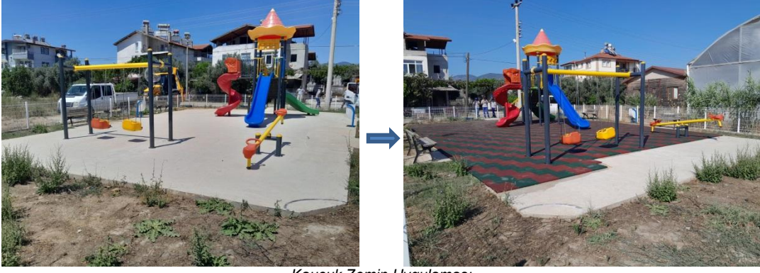
Kauçuk Zemin Uygulaması
