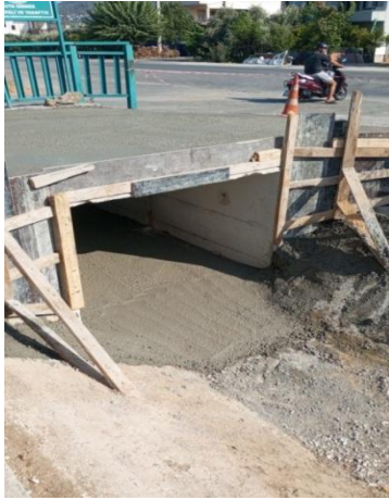
Köprü onarım çalışması
