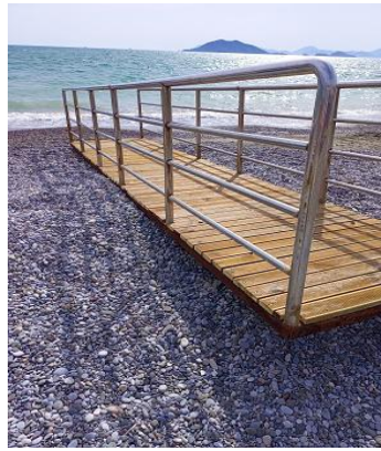
Engelli rampası imalatı
