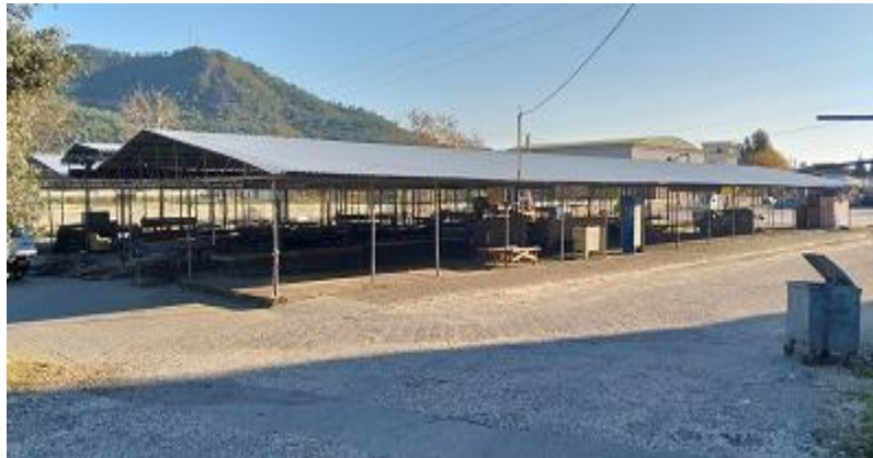
Göcek pazaryeri çatı yenileme
