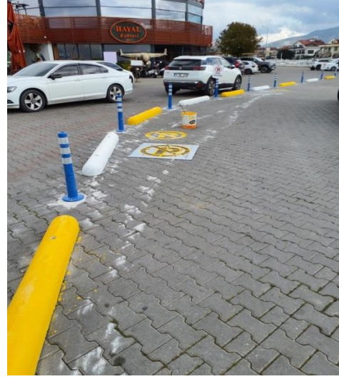
1109 adet beton bariyer montajı ve boyaması
