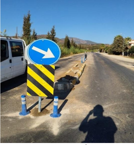
761 adet Sokak levha ve Trafik İkaz levha montajı
