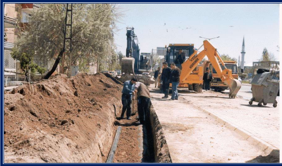
İÇMESUYU BORUSU DÖŞEME ÇALIŞMALARI
