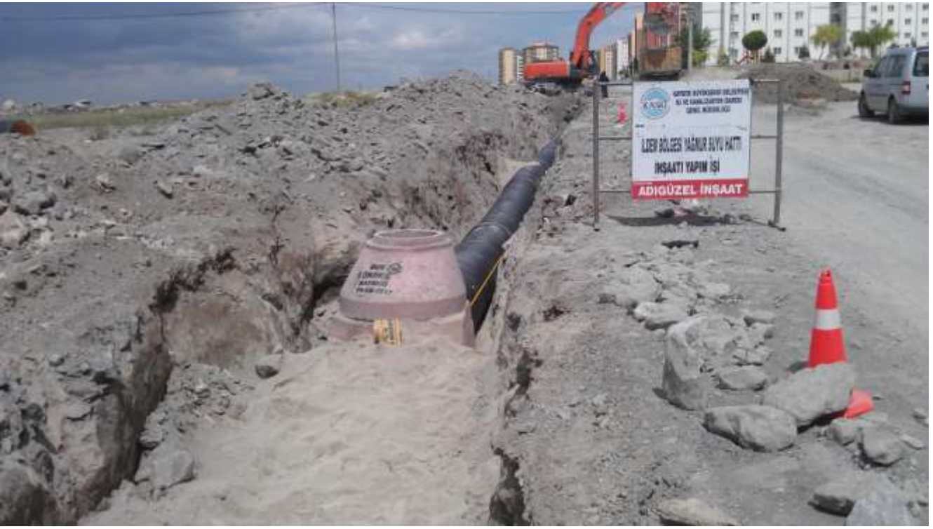
İldem Bölgesi Yağmursuyu Hattı İnşaatı İşinden Bir Görünüm
