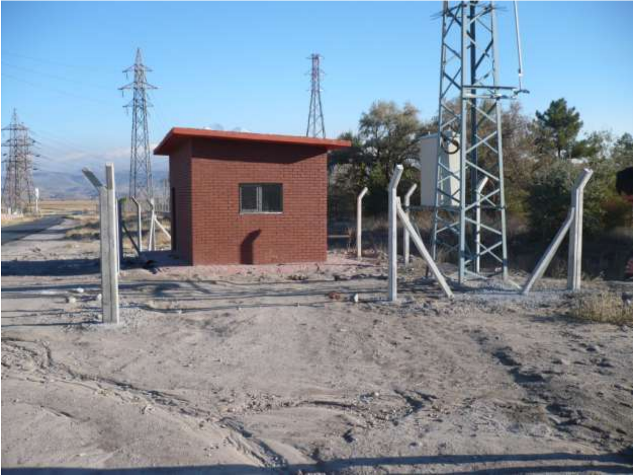
Kuyu Binaları Yapımından Bir Görünüm
