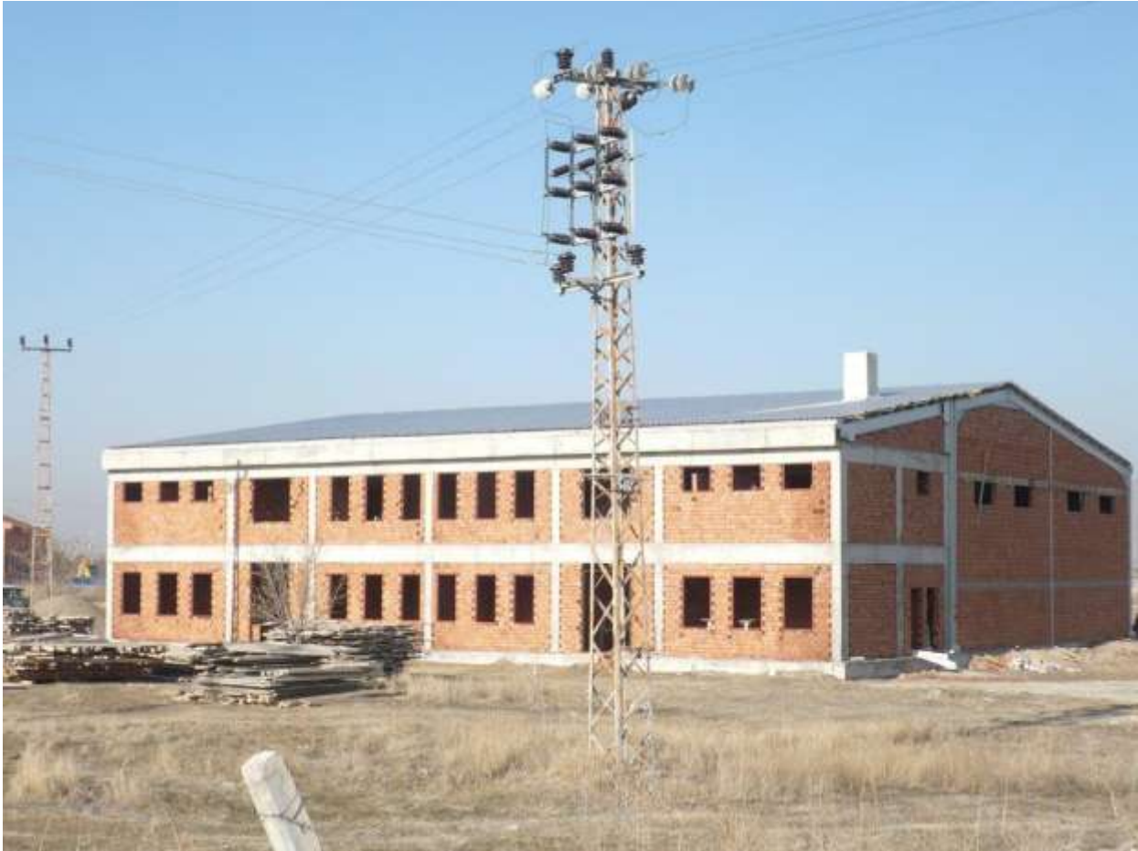
Karpuzatan Ekip Hizmet Binası Yapımından Bir Görünüm
