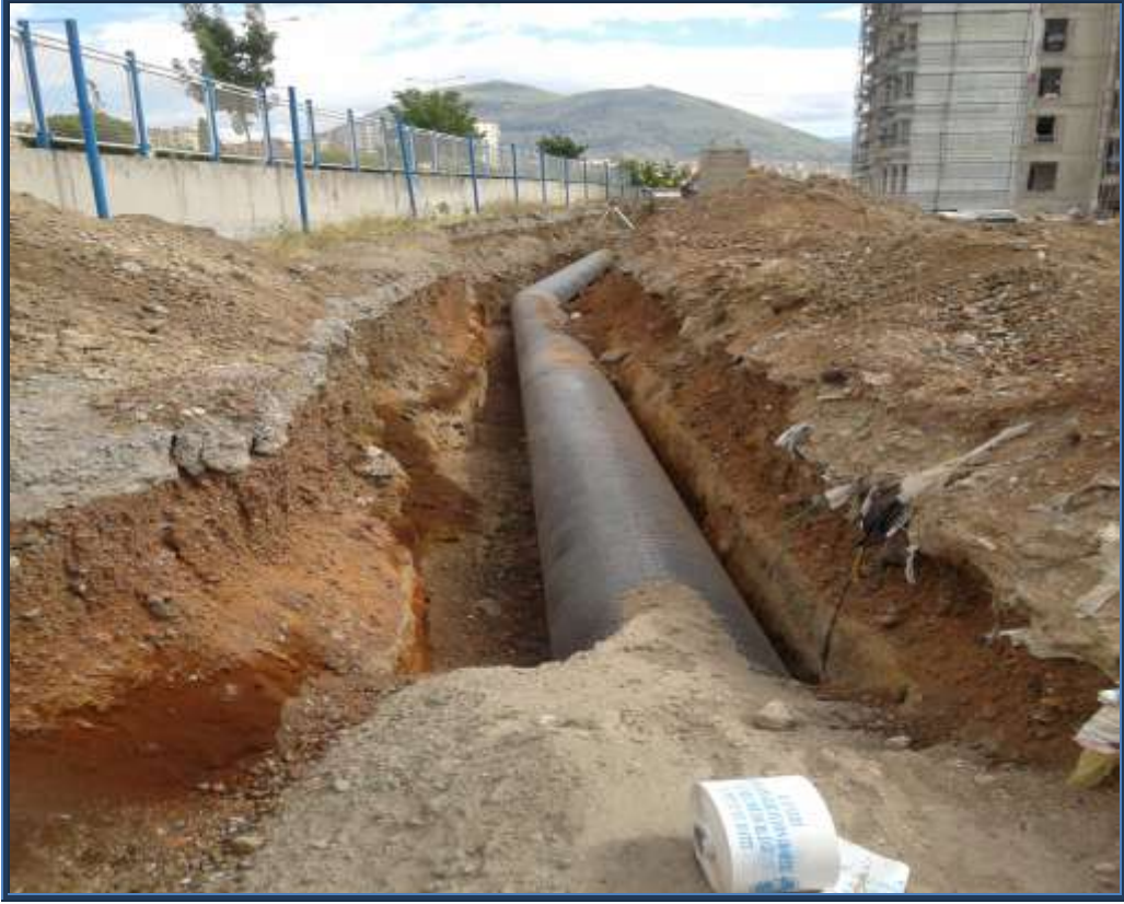
İÇMESUYU ŞEBEKE DÖŞEME ÇALIŞMALARI
