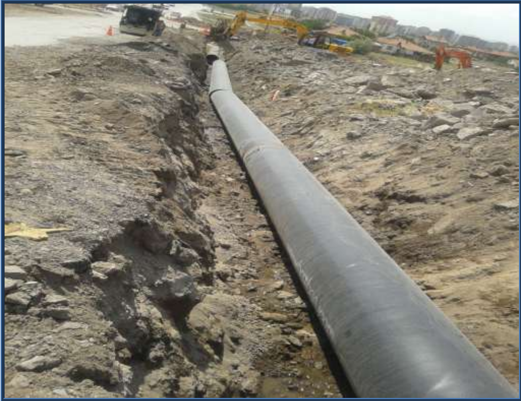
İÇMESUYU ŞEBEKE DÖŞEME ÇALIŞMALARI
