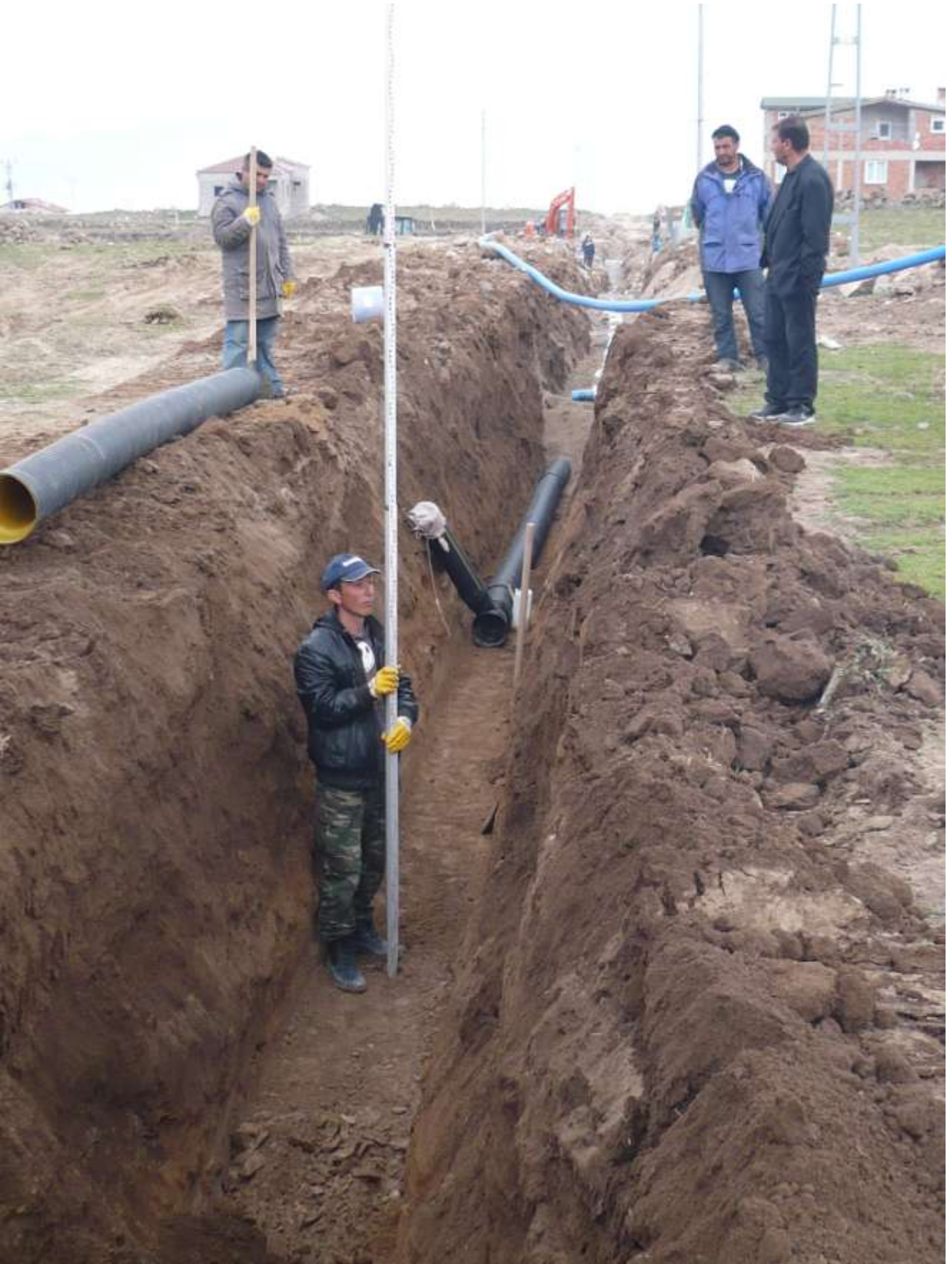
İncesu Karpuzsekisi İçmesuyu ve Kanalizasyon Şebeke Hattı İnşaatı İşinden Bir Görünüm
