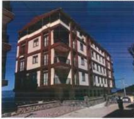
Günaydin Bursalı Mahfuz, Feriye Sokak, 2044 ada 1/6 parsel (Eski Ada/Parsel: 200/1/6).
