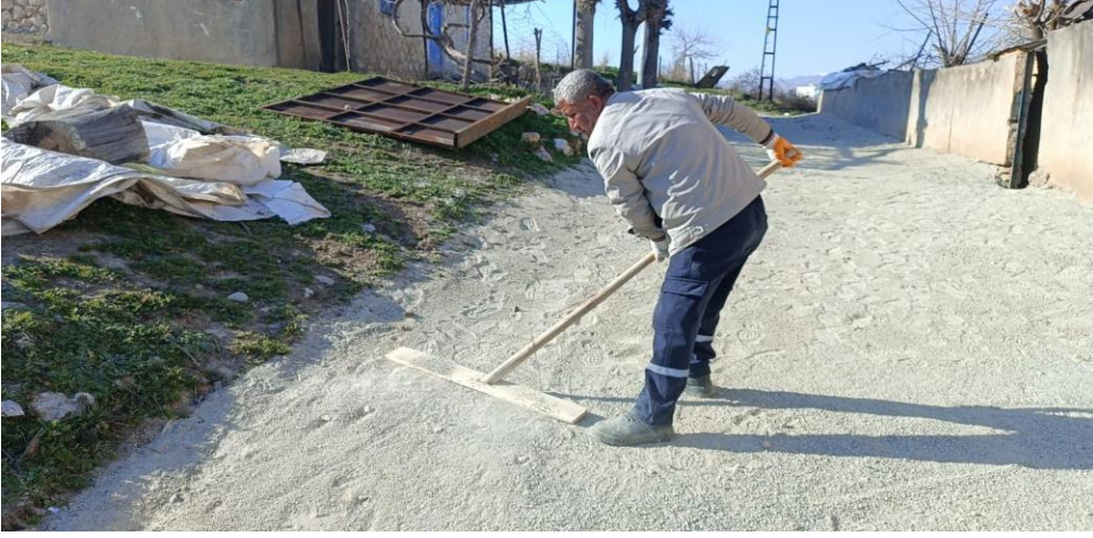
Parke Taşı Serme Çalışması: Şehir Geneli 38 Sokakta parke taşı serim çalışması yapıldı.
