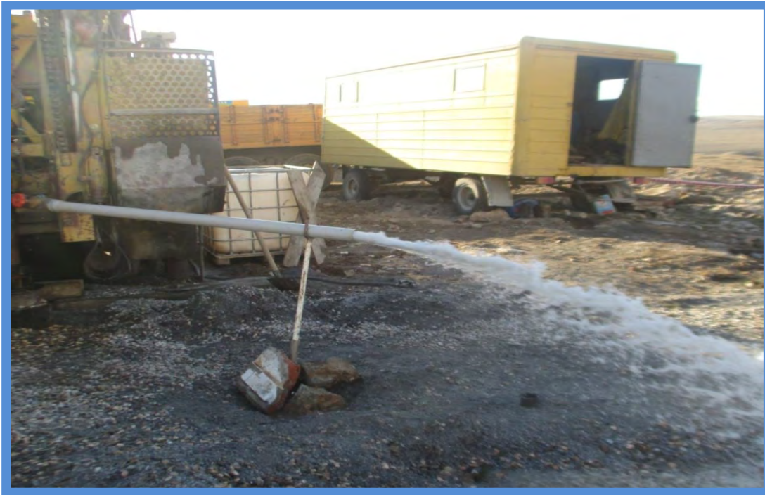
Tepebaşı İlçesi Kavacık Mahallesi Su Sondajı Çalışmaları
