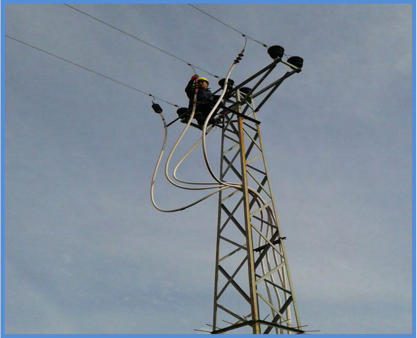
Tepebaşı İlçesi Çukurhisar Mahallesi Orta Gerilim Enerji Nakil Hattı Bakım İşİ
