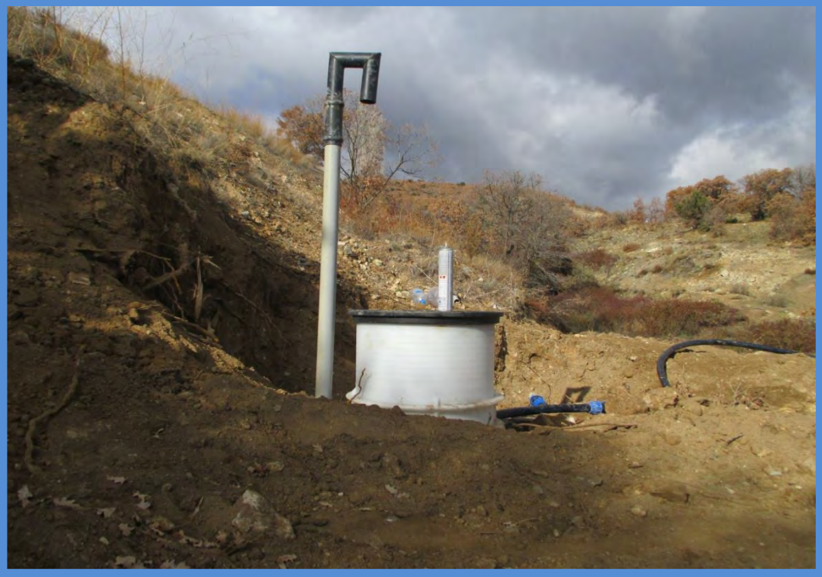
Mihalıççık İlçesi Diközü Mahallesi 500 litrelik Maslak Yapım İşi
