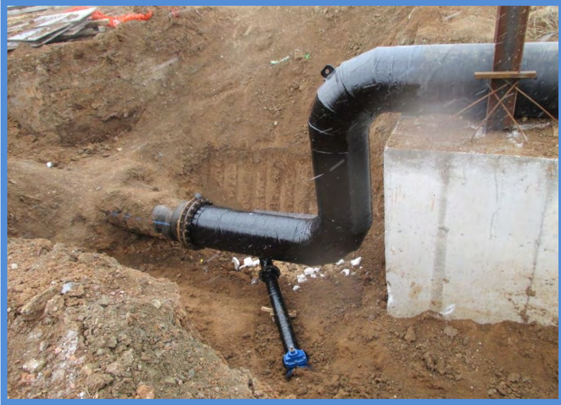
Tepebaşı İlçesi Sazova-Çamlıca Mahallesi Ø 600 Çelik Anaboru Bağlantısı Sulama Kanalı Geçidi Yapım İşi
