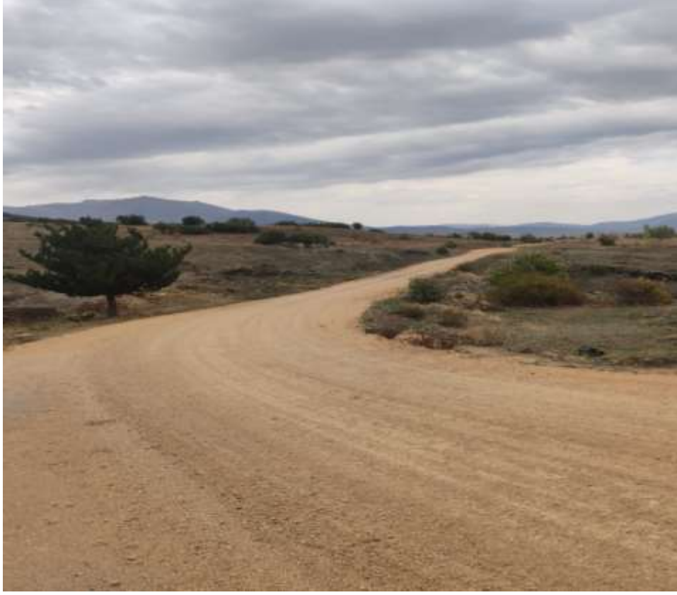
Şiran Çağıl Köyü Stabilize Çalışması
