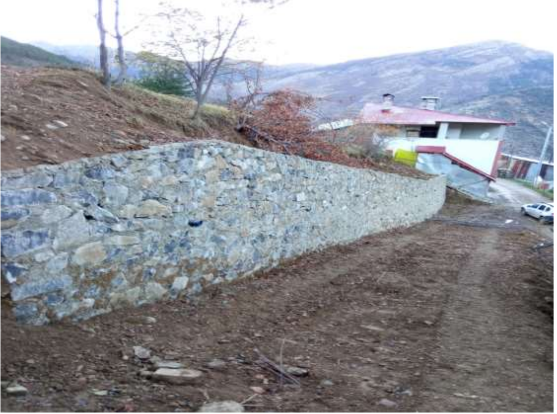
Kürtün Konacık Köyü Taş Duvar Yapım İşi
