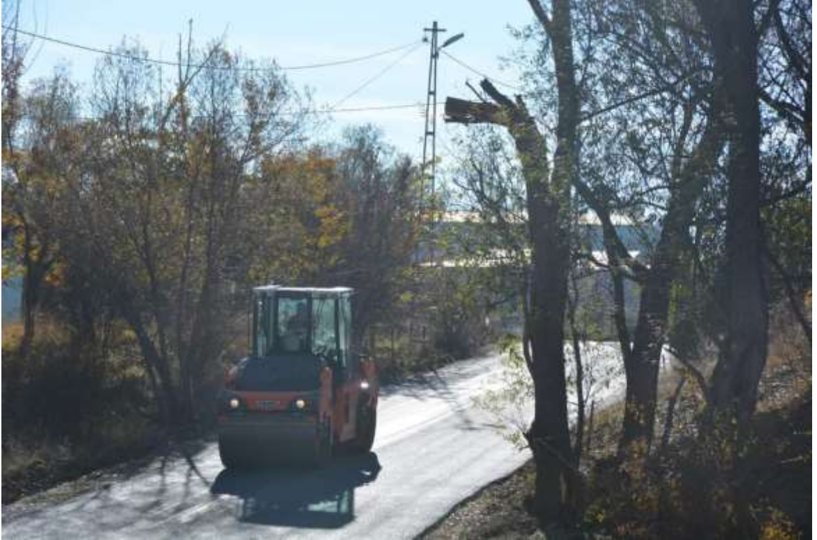
Merkez Sarıççek Köyü Grup Yolu BSK Çalışması
