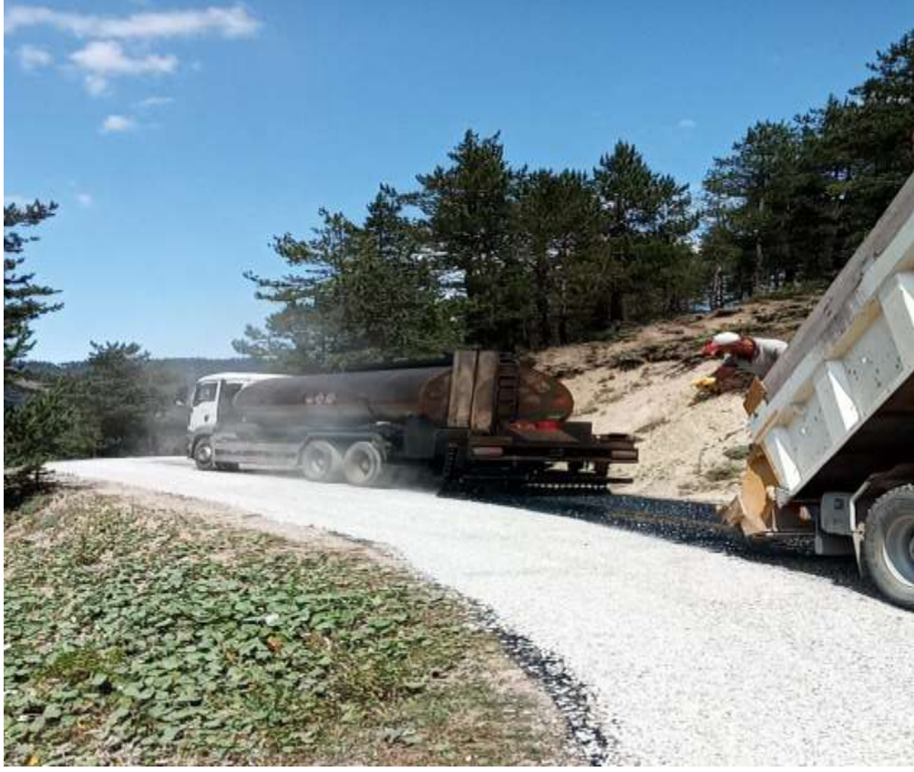
Torul Demirkapı Köyü Asfalt Çalışması
