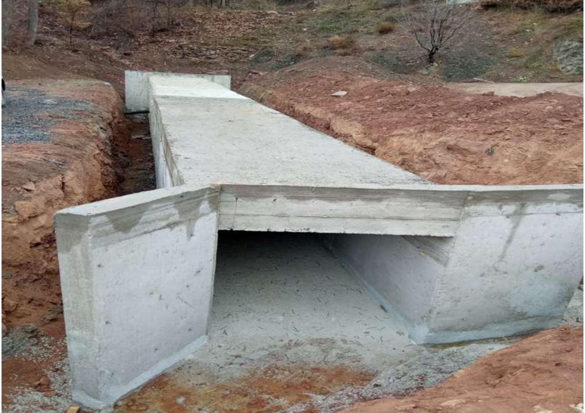
Merkez Çayırardı Köyü Menfez Yapım İşi
