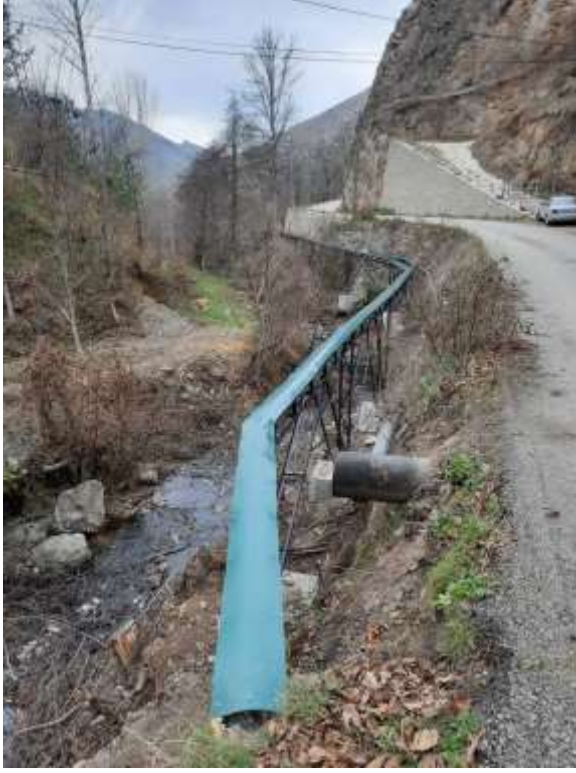
Merkez Yeşilyurt Köyü Kanalizasyon Hattı Yapım İşi Dere Geçişi Platformu
