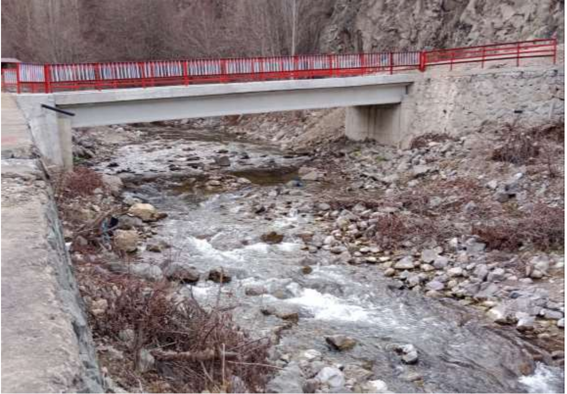
Merkez Dibekli Köyü Köprü Çalışması
