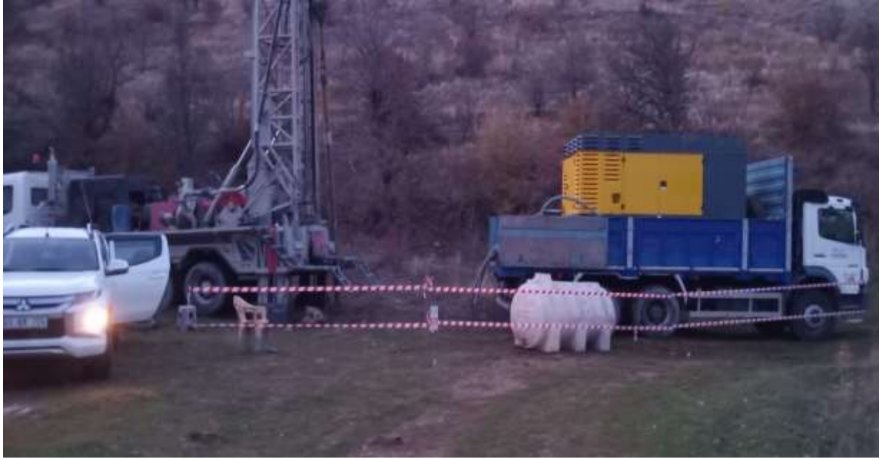
Merkez Olukdere Köyü Sondaj Çalışması
