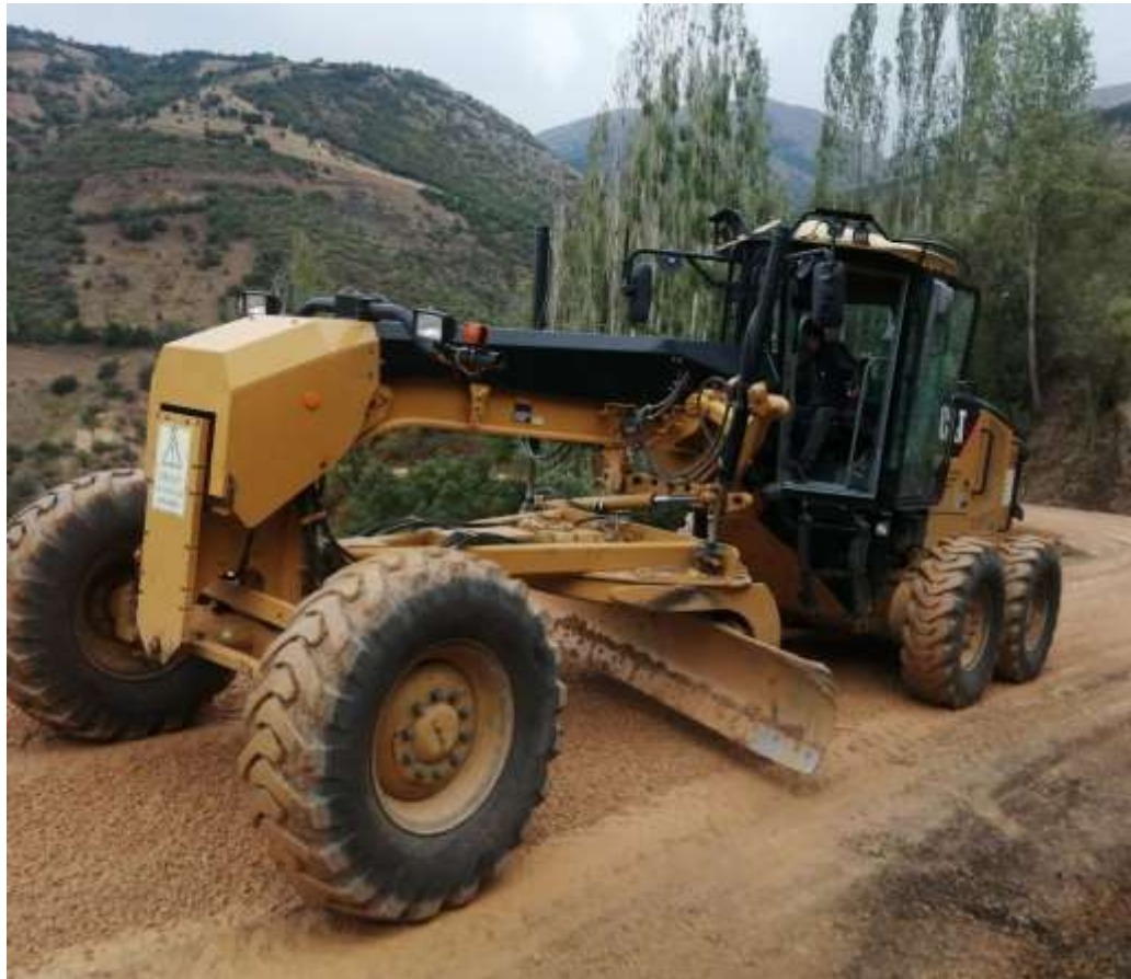
Şiran Pelitli Köyü Stabilize Çalışması
