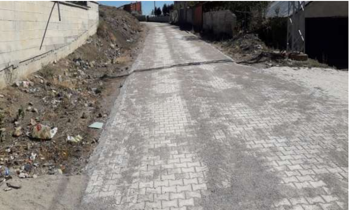
Şiran Boğazyayla Köyü Parke Yapım İşİ
