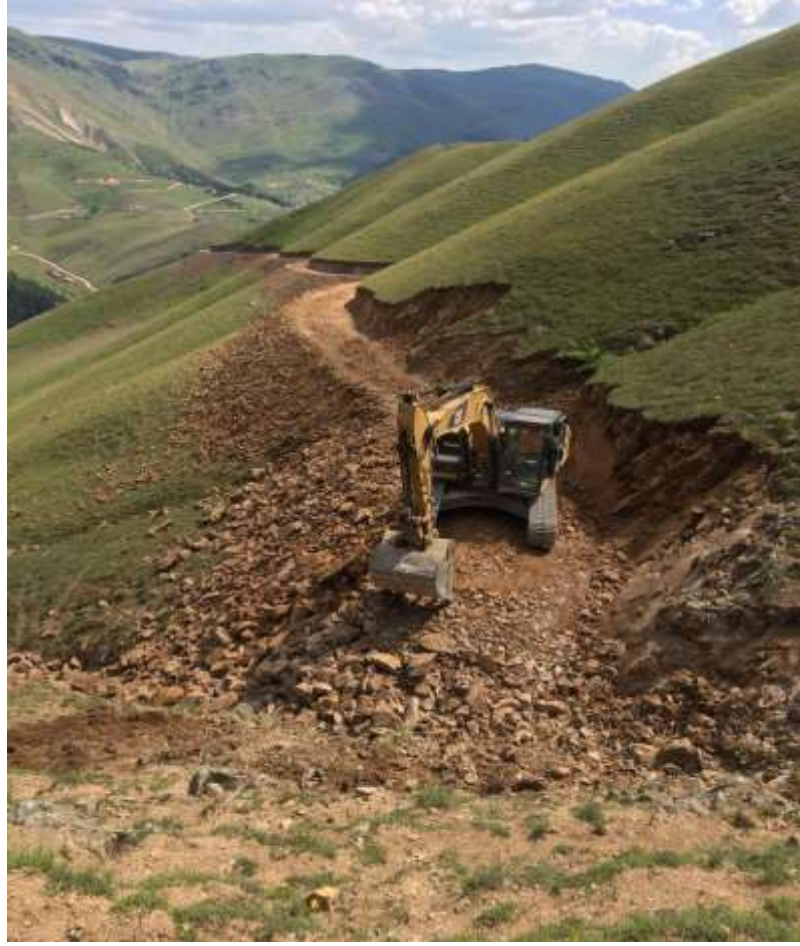
Kürtün Söğüteli Köyü Yayla Yolu Yapım İşi
