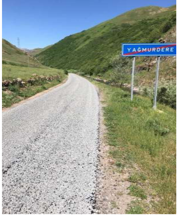
Merkez Yağmurdere Çatak Grup Yolu Asfalt Çalışması
