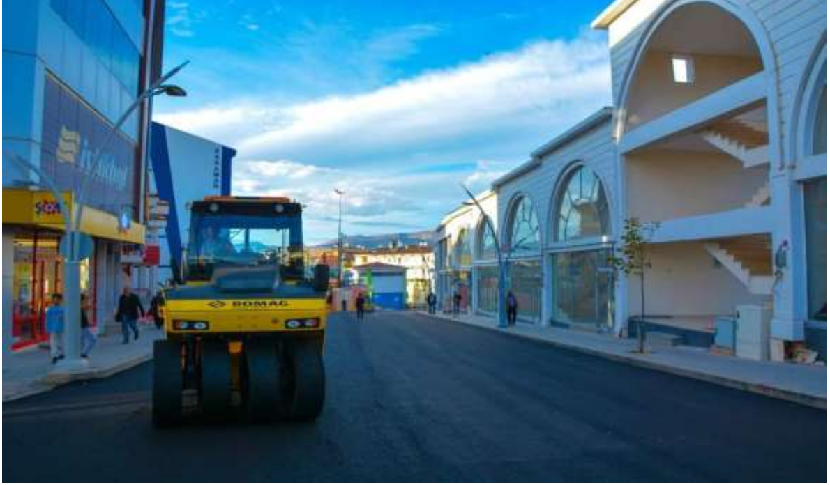
Kelkit Merkez Mahalle İçi Asfalt Yol Yapımı
