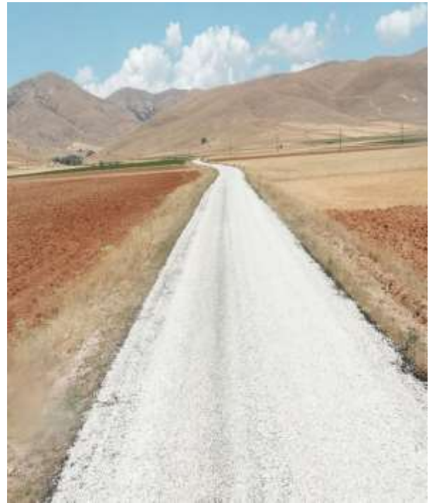
Köse Oylumdere Köyü Asfalt Çalışması
