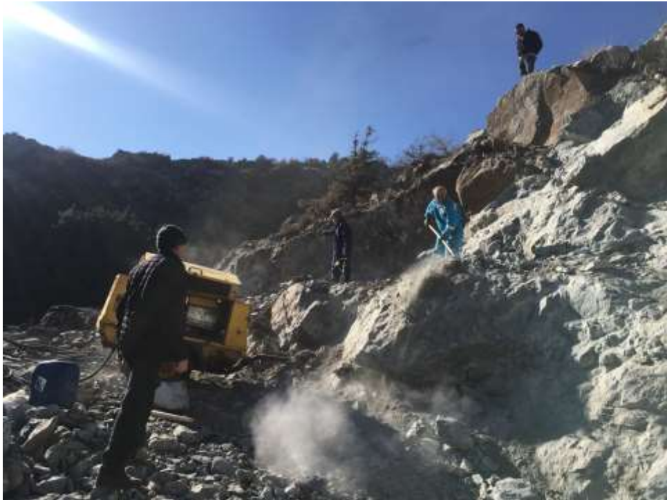
Merkez Dibekli Köyü Yayla Yolu Yapım İşi
