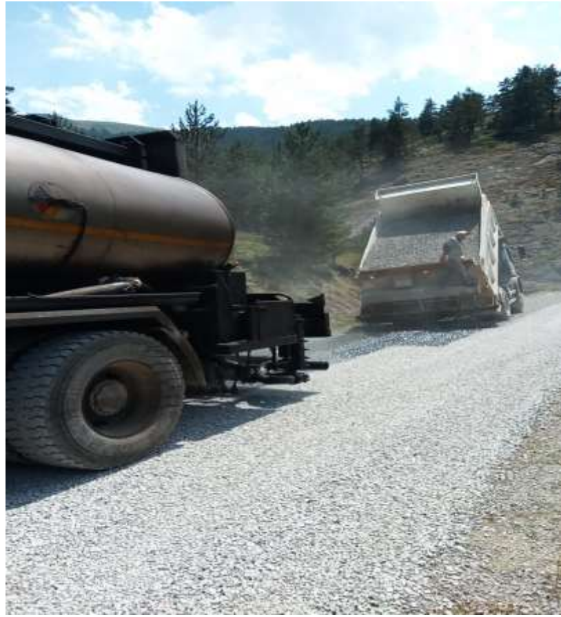
Merkez Yukarı Alıçlı Köyü Asfalt Çalışması
