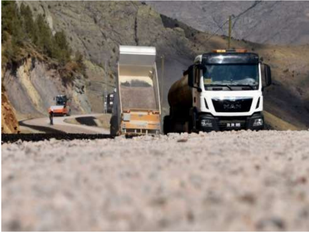
Merkez Sarginkaya Asfalt Çalışması
