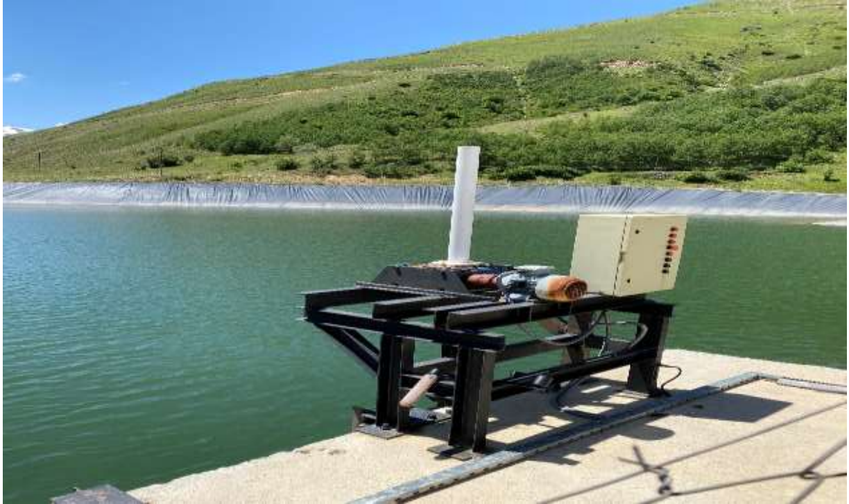
Torul-Güzeloluk Köyü-Hidroelektrik Santrali
