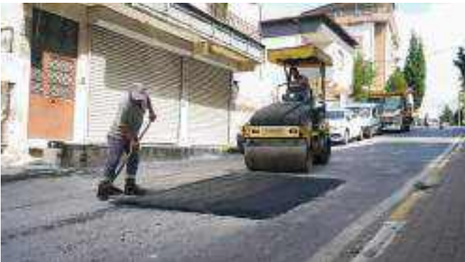
Asfalt Yama Çalışması
