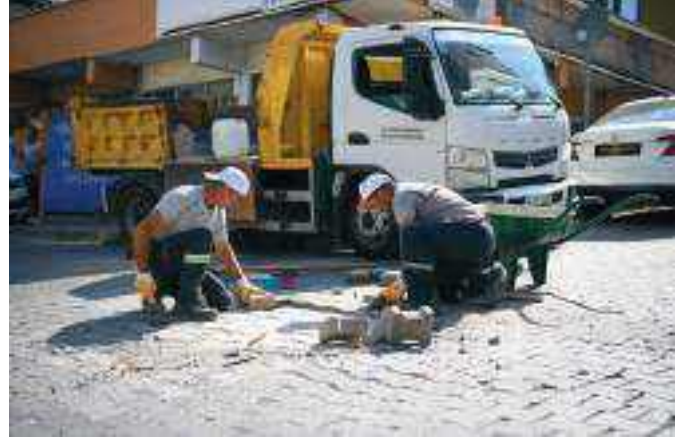
Yol Yüzeyine Parke Taşı Çalışması
