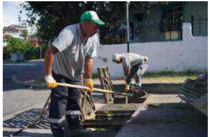
Yağmur Suyu Izgarası Temizliği
