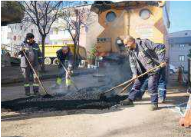
Asfalt Yama Çalışması
