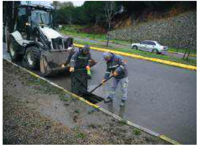
Yağmur Suyu Izgarası Temizliği
