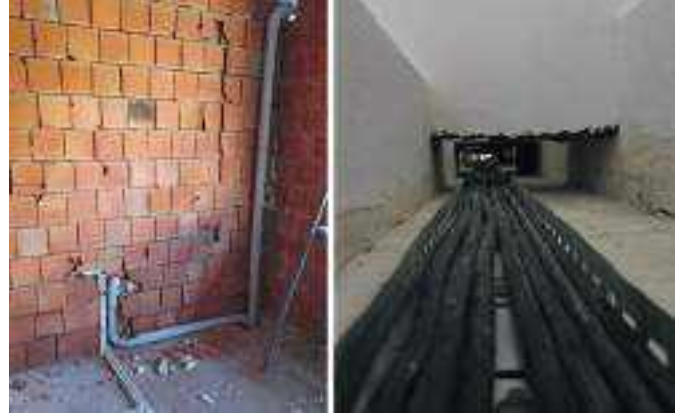
(Mekanik ve Elektrik Tesisatı Kontrolleri Örnek Fotoğrafları)
