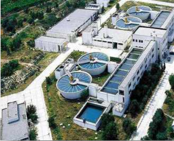
Tarsus Berdan İçmesuyu Arıtma Tesisi
