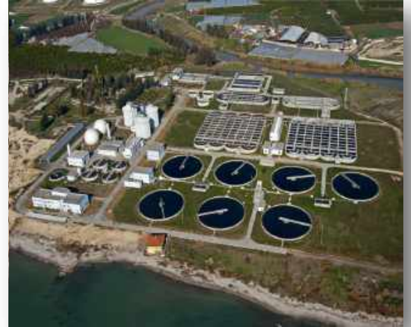
Mersin Merkez Karaduvar Atıksu Arıtma Tesisi
