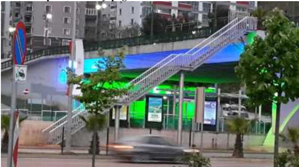
İhlamur köprüsüne ilave yaptığımız merdiven
