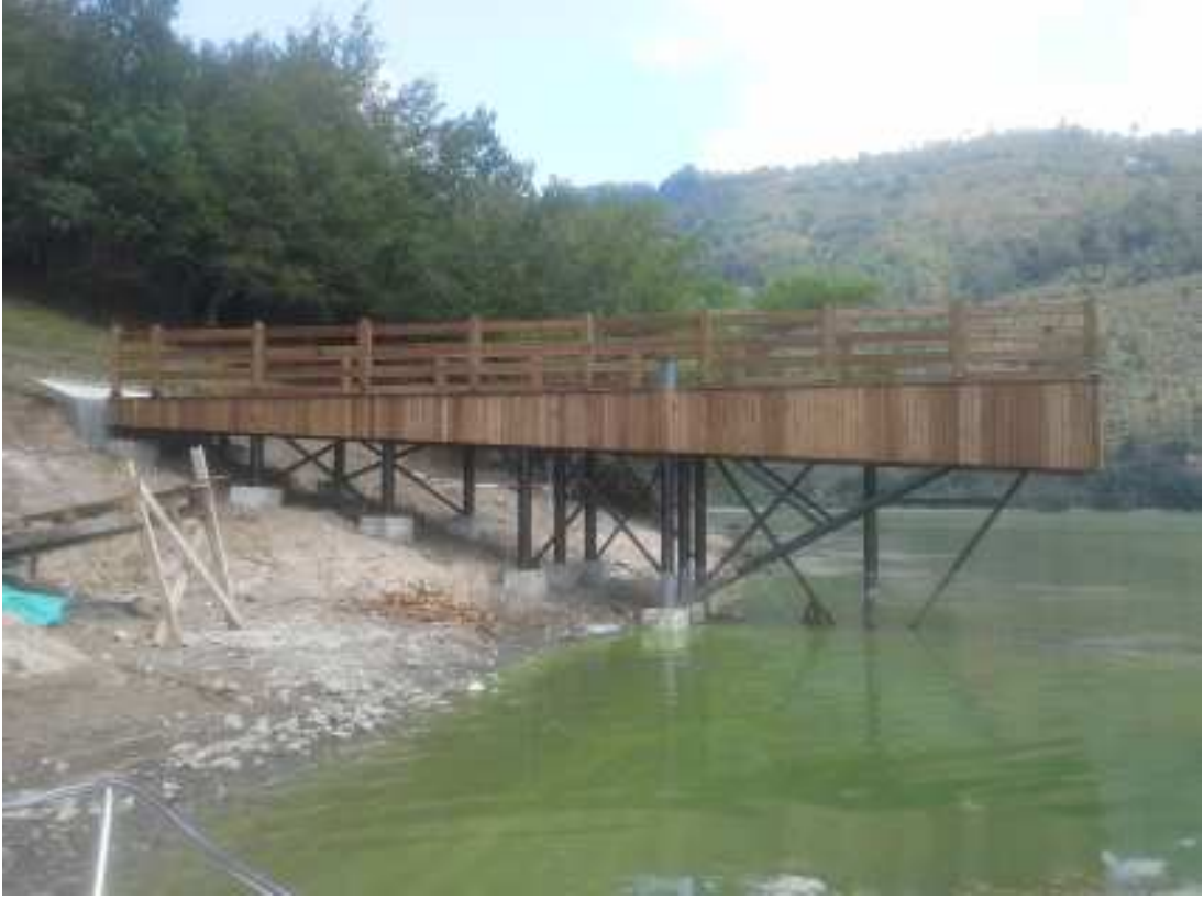
Ayvacak'taki ada üzerinde yaptığımız iskele
