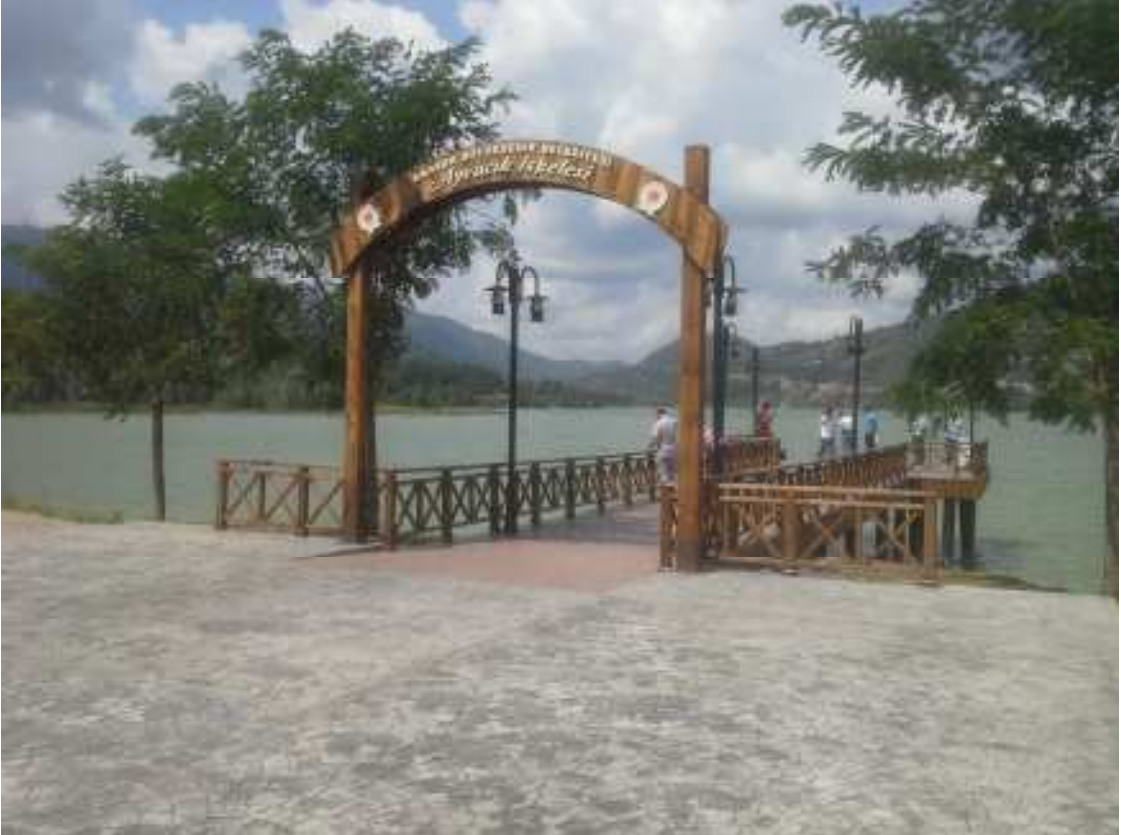
Ayvacak şehir merkezinde yaptığımız iskele
