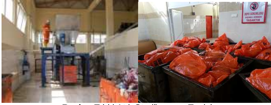
Resim: Tıbbi Atık Sterilizasyon Tesisi
