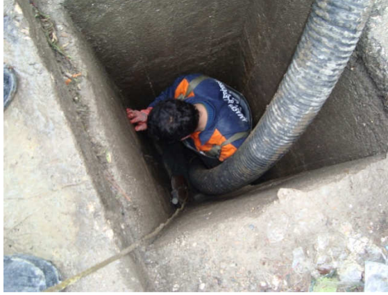
(Kanalizasyon baca temizliği)(İçme Suyu Hat Tamirâtı)
