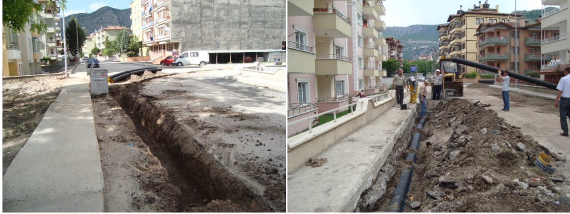
(Bahçeleriçi Mah. Yağmur suyu hat çalışması)(Bahçeleriçi Mah.Yağmur suyu hat çalışması)
