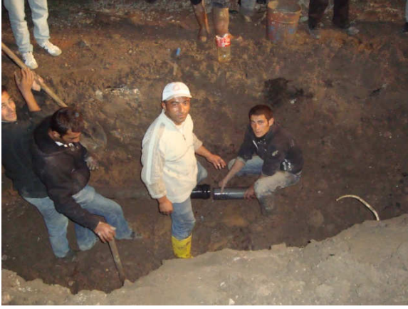
(İçme suyu tamirat çalışması)
