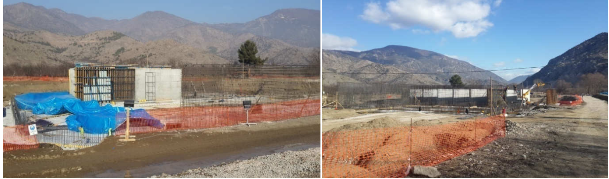
(Amasya Atıksu arıtma tesis inşaatı)(Amasya Atıksu arıtma tesis inşaatı)
