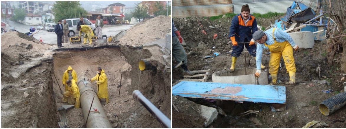
(İçme suyu tamirat çalışması )(Kanalizasyon tamirat çalışması)
