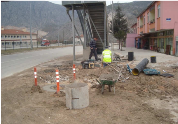
(Kanalizasyon baca tamirâtı)
