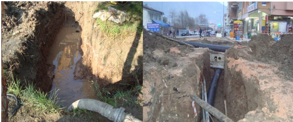
(Akbilek Mah.Kanalizasyon hat çalışması)
