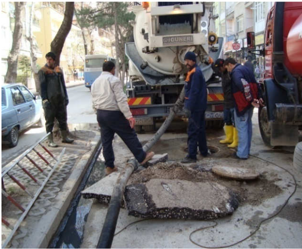
(Hızırpaşa Kanalizasyon hat temizliği) (Hacılar Meydanı Kanalizasyon hat temizliği)
