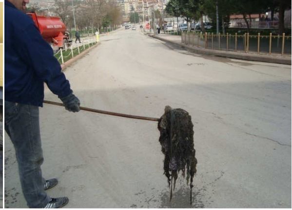
(Kanalizasyon vidanjörle su çekilmesi)(Kanalizasyon baca temizliği)
