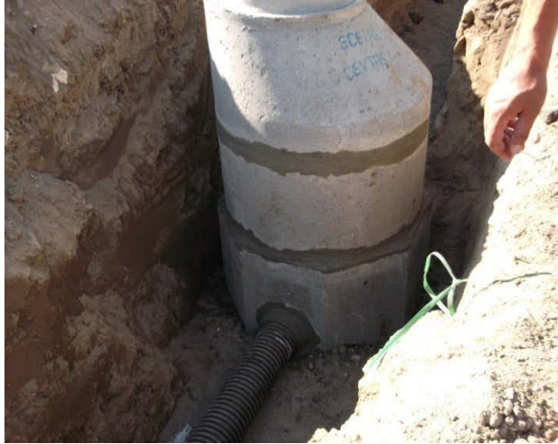
(Kanalizasyon hat yapımı)(Kanalizasyon parsel yapımı)
