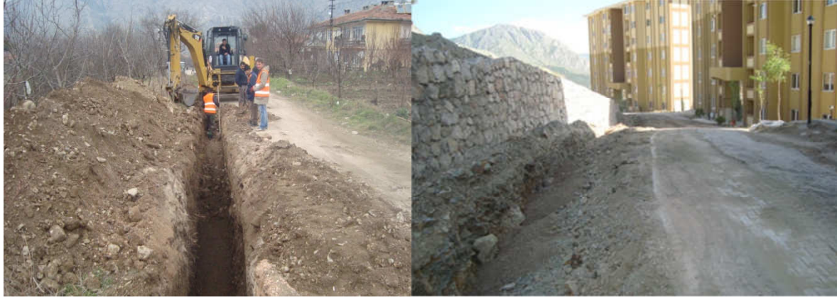
(Ormanbağları Mah. Kanalizasyon çalışması)(Şeyhcu Mah. Kanalizasyon çalışması)
