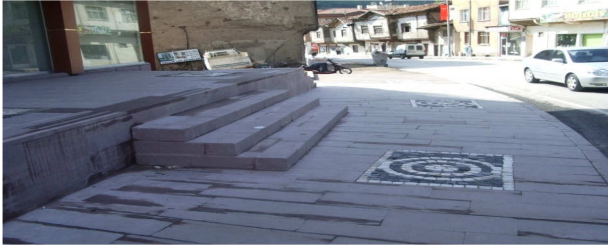
Kaldırım- Tretuvar çalışmaları
