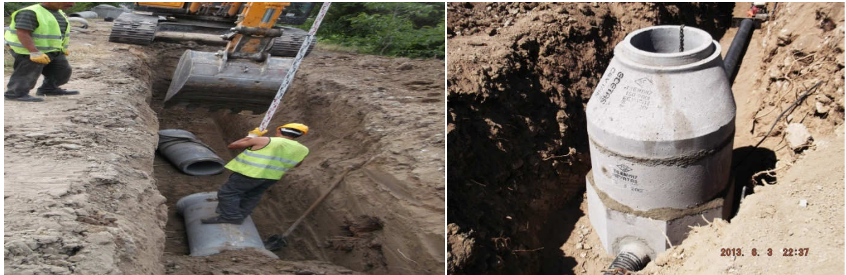
(Kanalizasyon hat yapımı)(Kanalizasyon hat yapımı)
