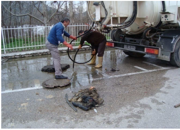
(Kanalizasyon vidanjörle su çekilmesi)(Kanalizasyon baca temizliği)
