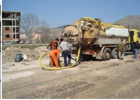
(Kanalizasyon vidanjörle su çekilmesi)(Kanalizasyon baca temizliği)
