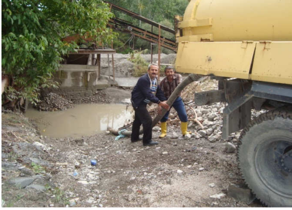
(Kanalizasyon vidanjörle su çekilmesi)(Kanalizasyon baca temizliği)
