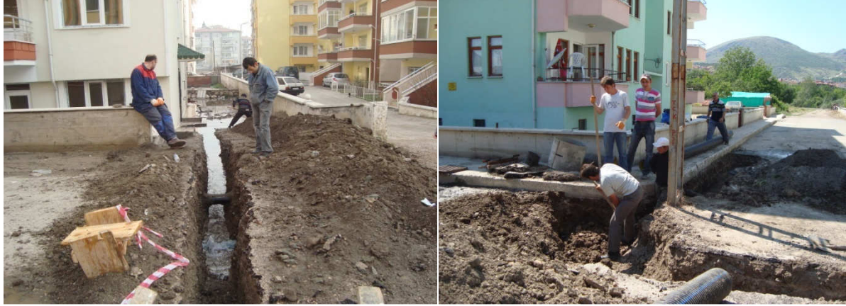
(Hacıarmeydanı Mah. Yağmur suyu hat çalışması)(HacıarmeydanıMah.Yağmur suyu hat çalışması)
