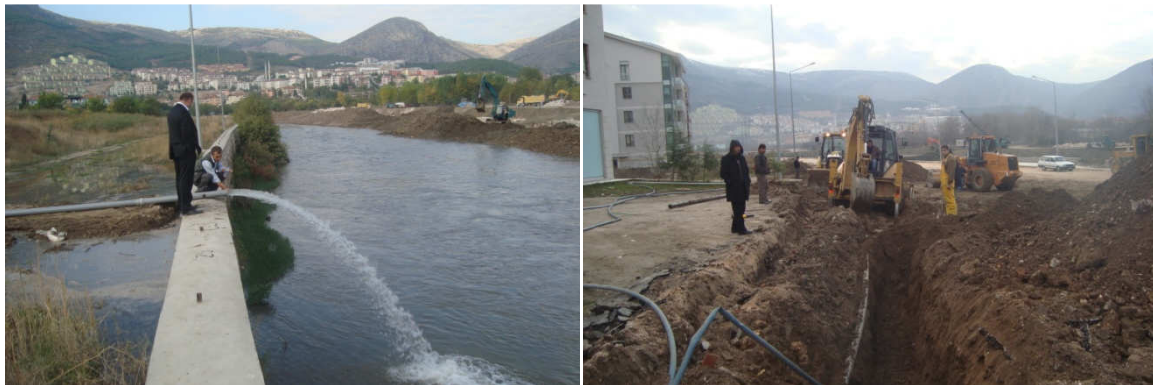
(Akbilek Mah. İçme suyu hat çalışması )(AkbilekMah. İçme suyu hat çalışması)
