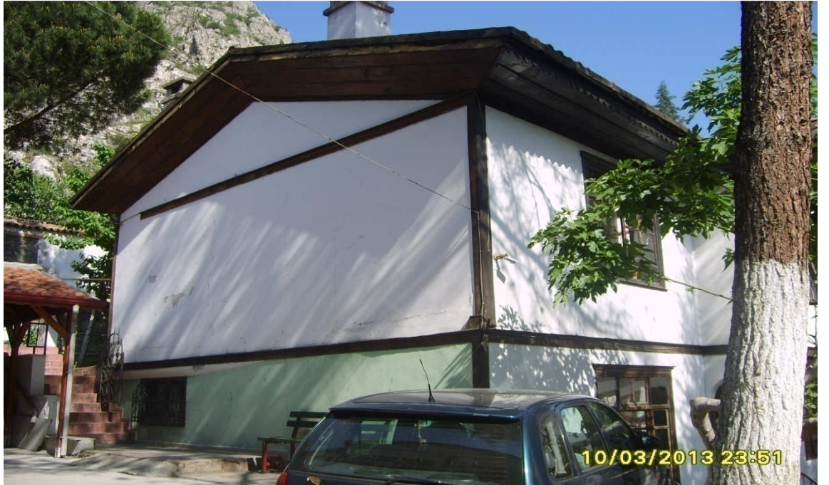
Yapının Onarım Öncesi Fotoğrafı
