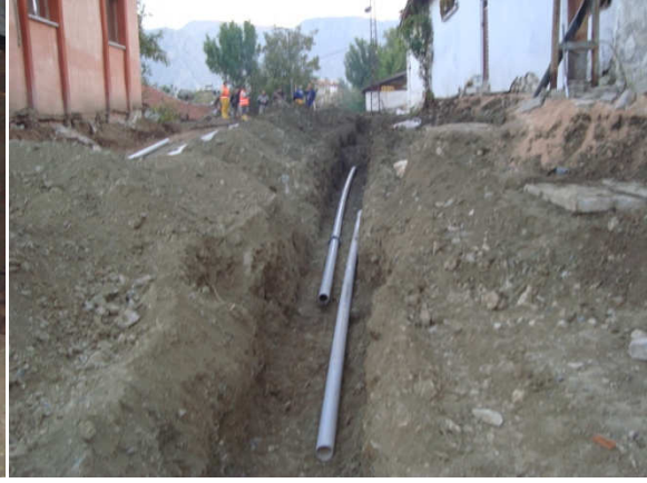
(İçme suyu hat çalışması)
