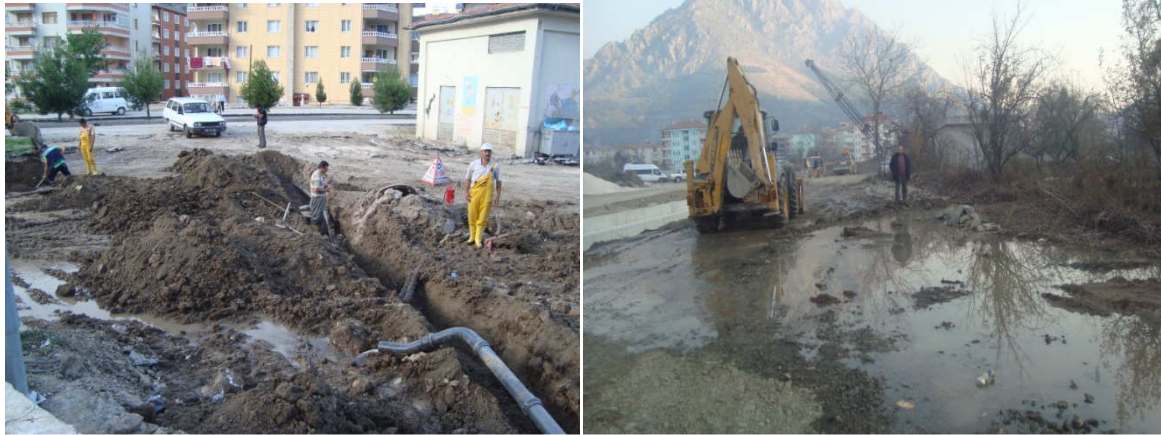
(Hacılar Meydanı Mah.İçme suyu hat çalışması)(Hacılar Mey.Mah. İçme suyu hat çalışması)
