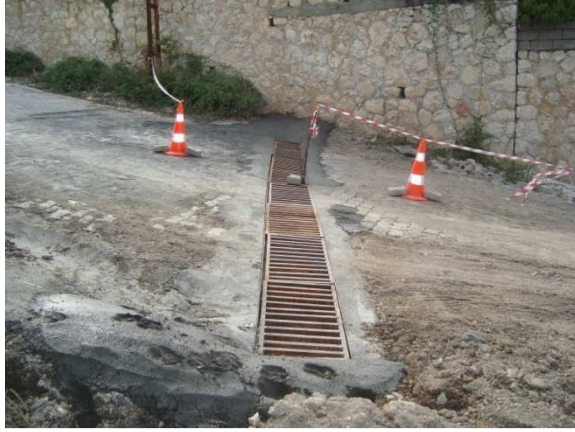
( Yağmur suyu ana ızgara tamirati) (Yağmur suyu çalışması)
