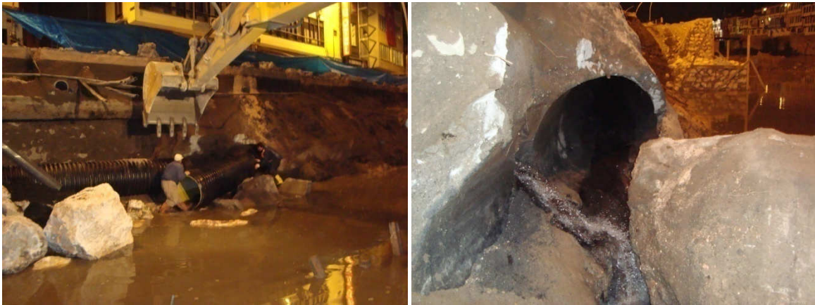
(Kanalizasyon tamirat çalışması)(Kanalizasyon tamirat çalışması)
