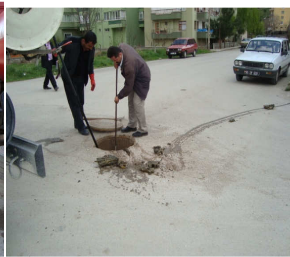
(Hızırpaşa Kanalizasyon hat temizliği) (Hacılar Meydanı Kanalizasyon hat temizliği)
