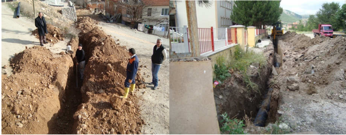
(Şeyhcui Mah. Kanalizasyon hat çalışması )(AkbilekMah. Kanalizasyon hat çalışması)
