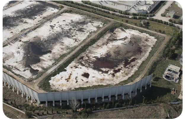
Batı (Özlüce) Atık Su Arıtma Tesis
