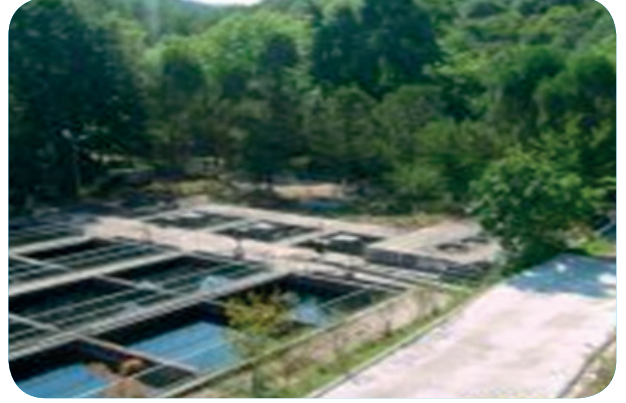
İçmesuyu Arıtma Tesisi
