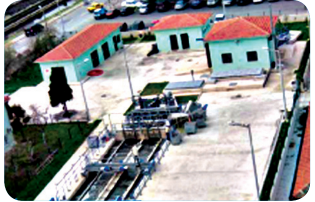
İçmesuyu Arıtma Tesisi
