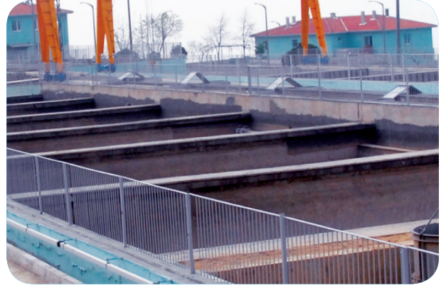
İçmesuyu Arıtma Tesis
