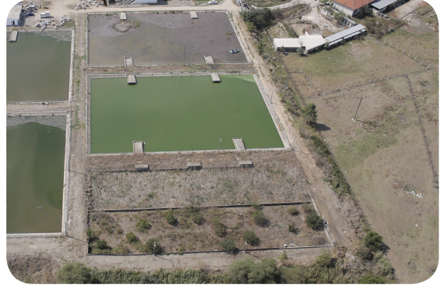
Karacabey Atık Su Arıtma Tesisi
