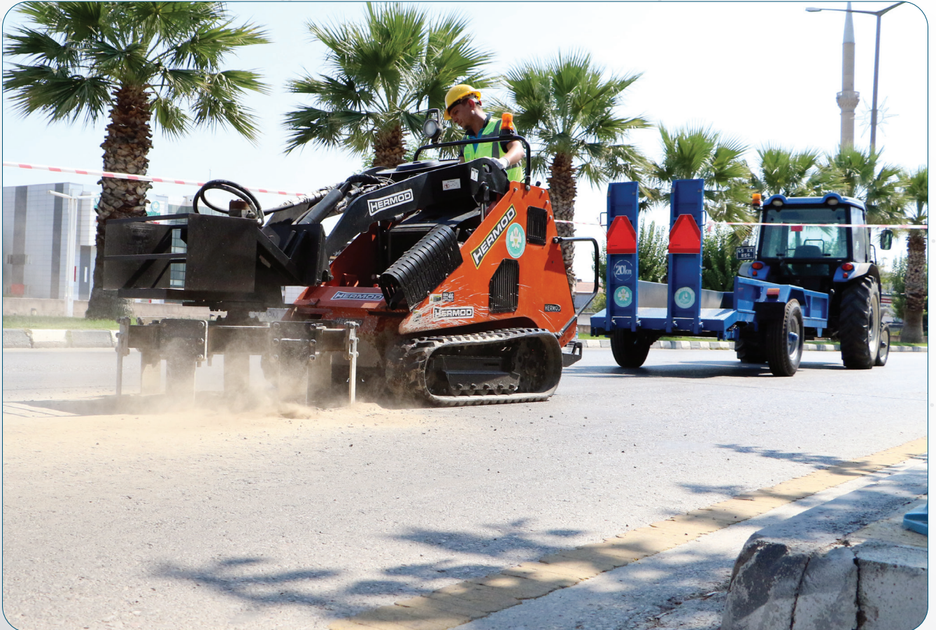
Yunusemre Laleli Mahallesi Punch Makinesi ile Muayene Bacası Yükseltme
