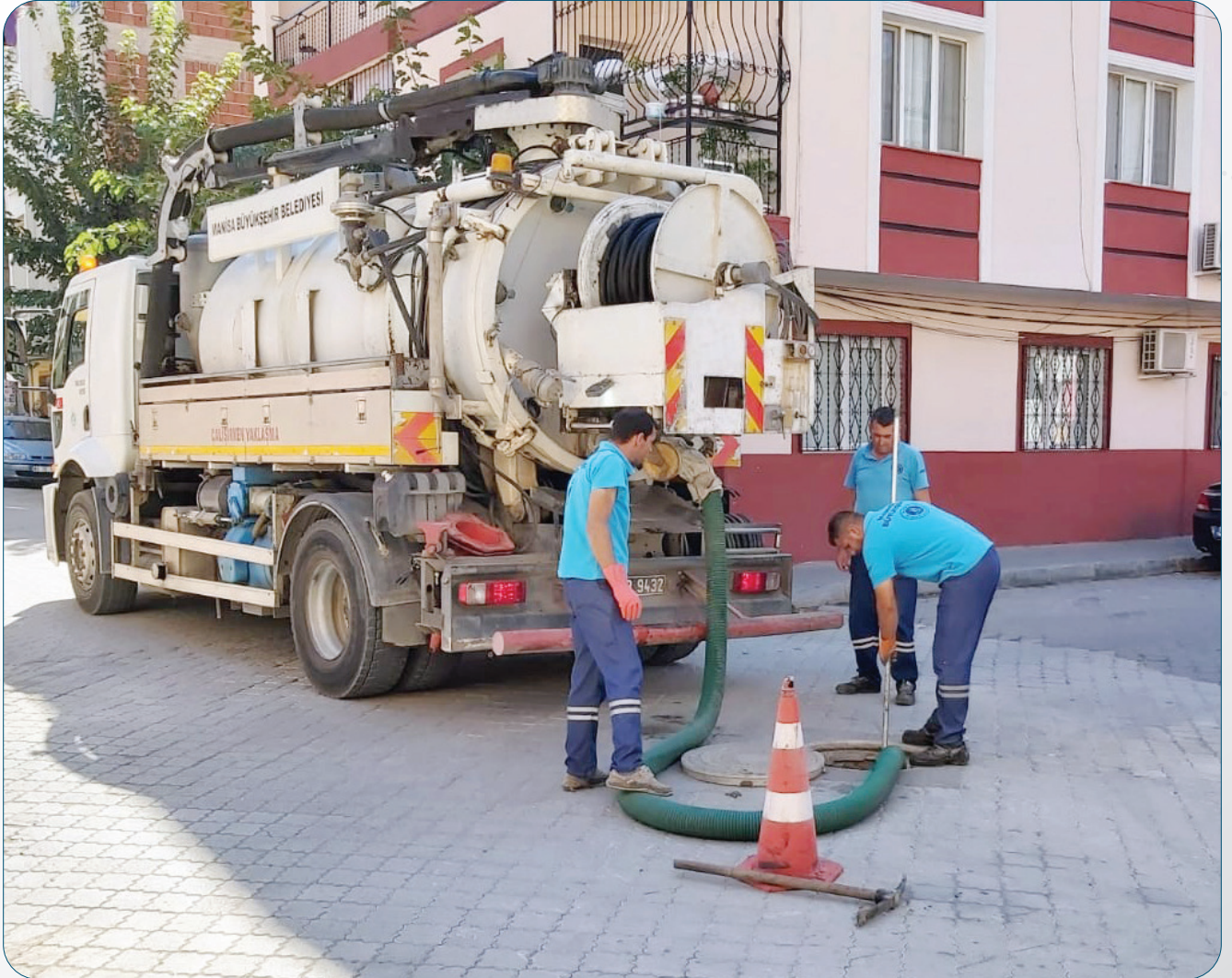
Turgutlu Kanalizasyon Hattı Temizliği
