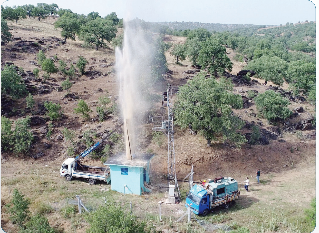
Köprübaşı Yeşilköy Mahallesi Kompresörle Sondaj Temizliği
