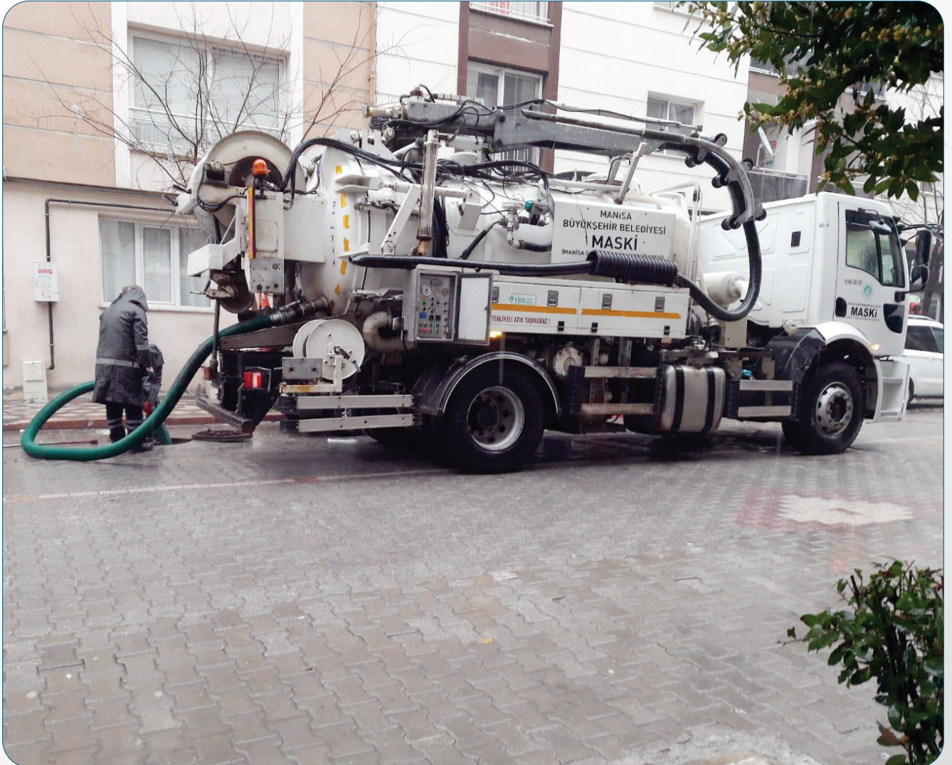
Manisa Merkez Yağmur Suyu Hattı Temizliği
