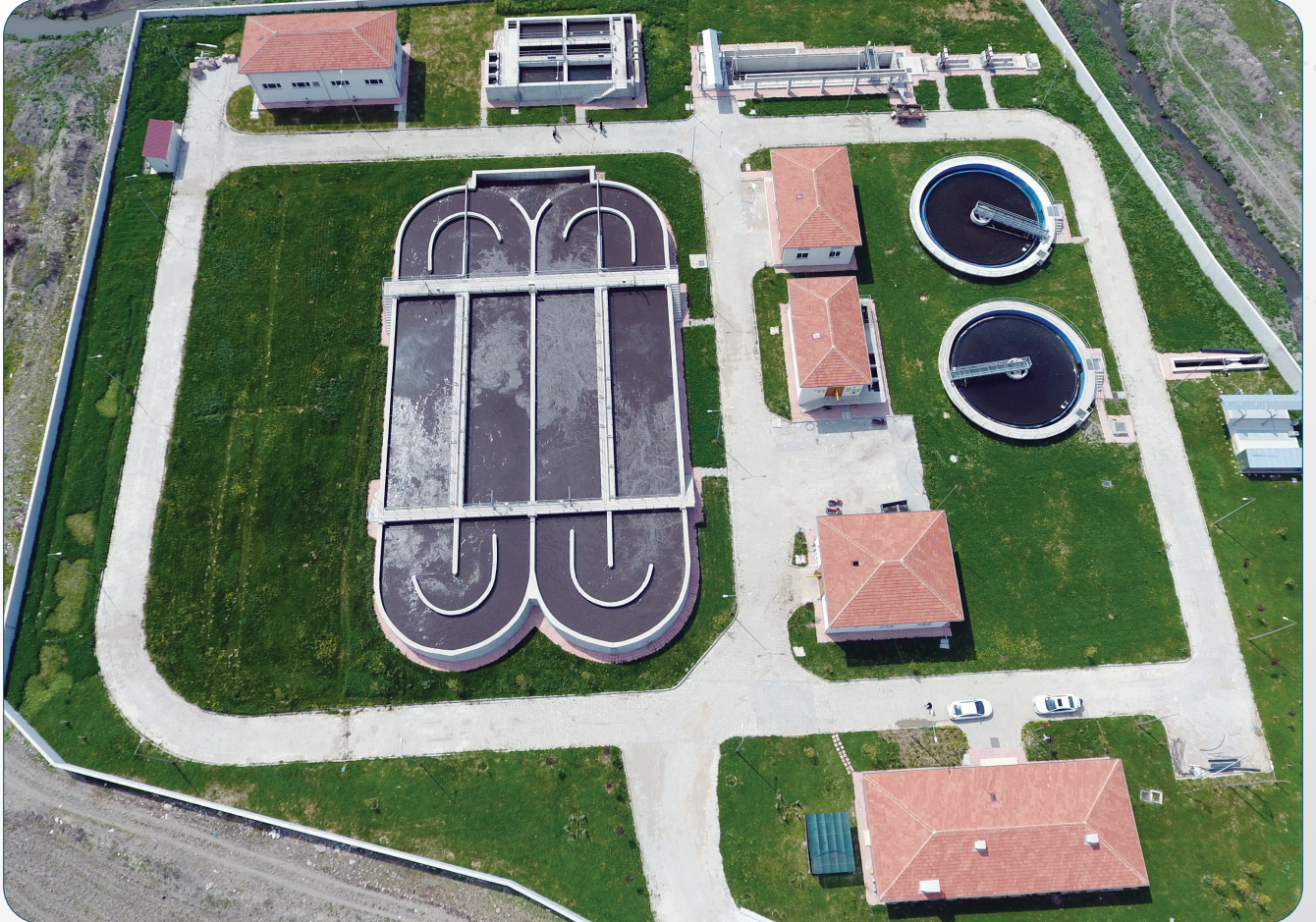
Kırkağaç Atıksu Arıtma Tesisi
