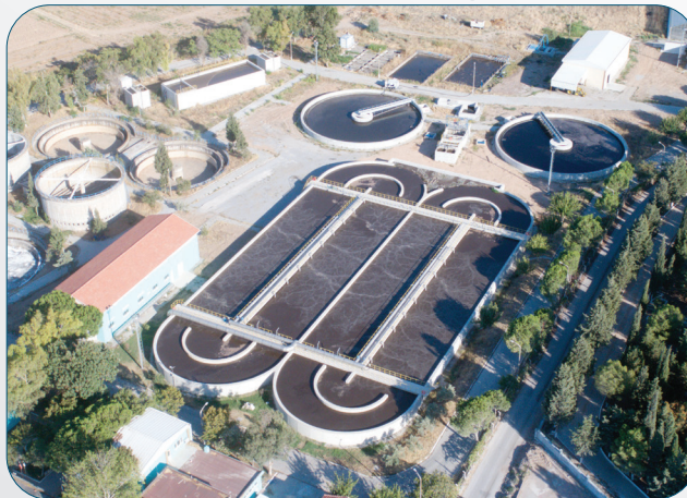
Akhisar Atıksu Arıtma Tesisi
