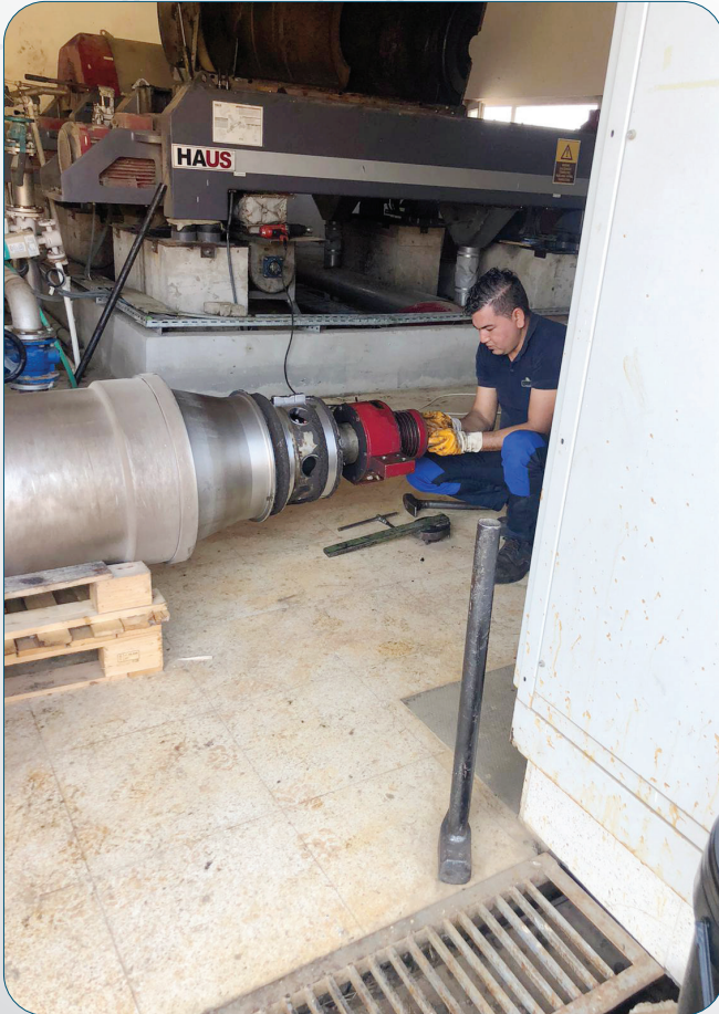
Salıhlı Atıksu Arıtma Tesis Dekantör Bakımı
