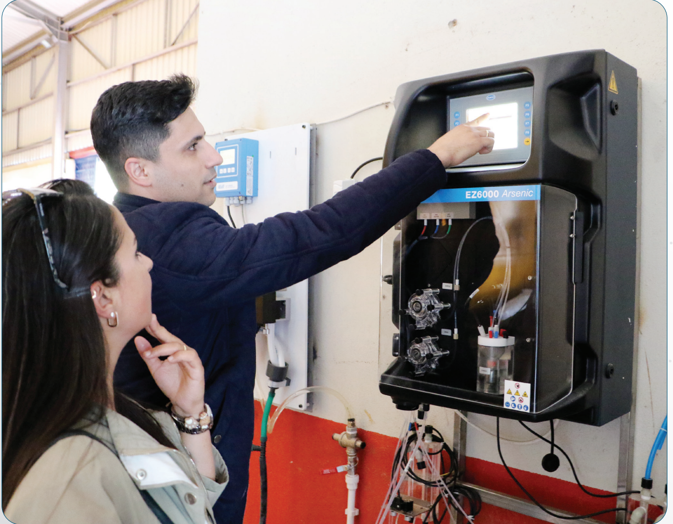
Şehzadeler Akpınar İçme Suyu Arıtma Tesisi
