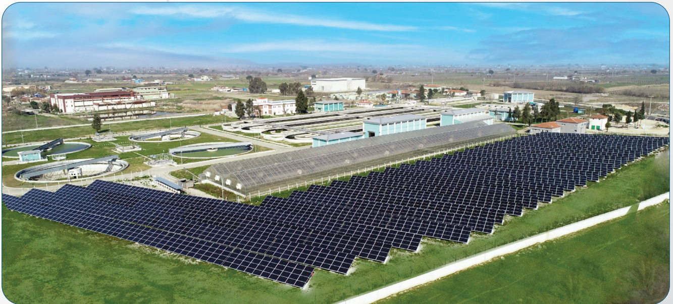
Manisa Merkez Atıksu Arıtma Tesisi ve Güneş Enerji Santrali
