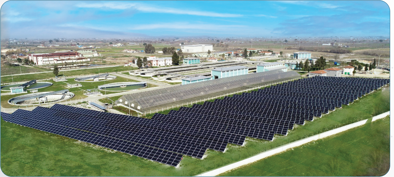
Manisa Merkez Atıksu Arıtma Tesisi ve ZEKA'dan Hibe Destekli Güneş Enerji Santrali
