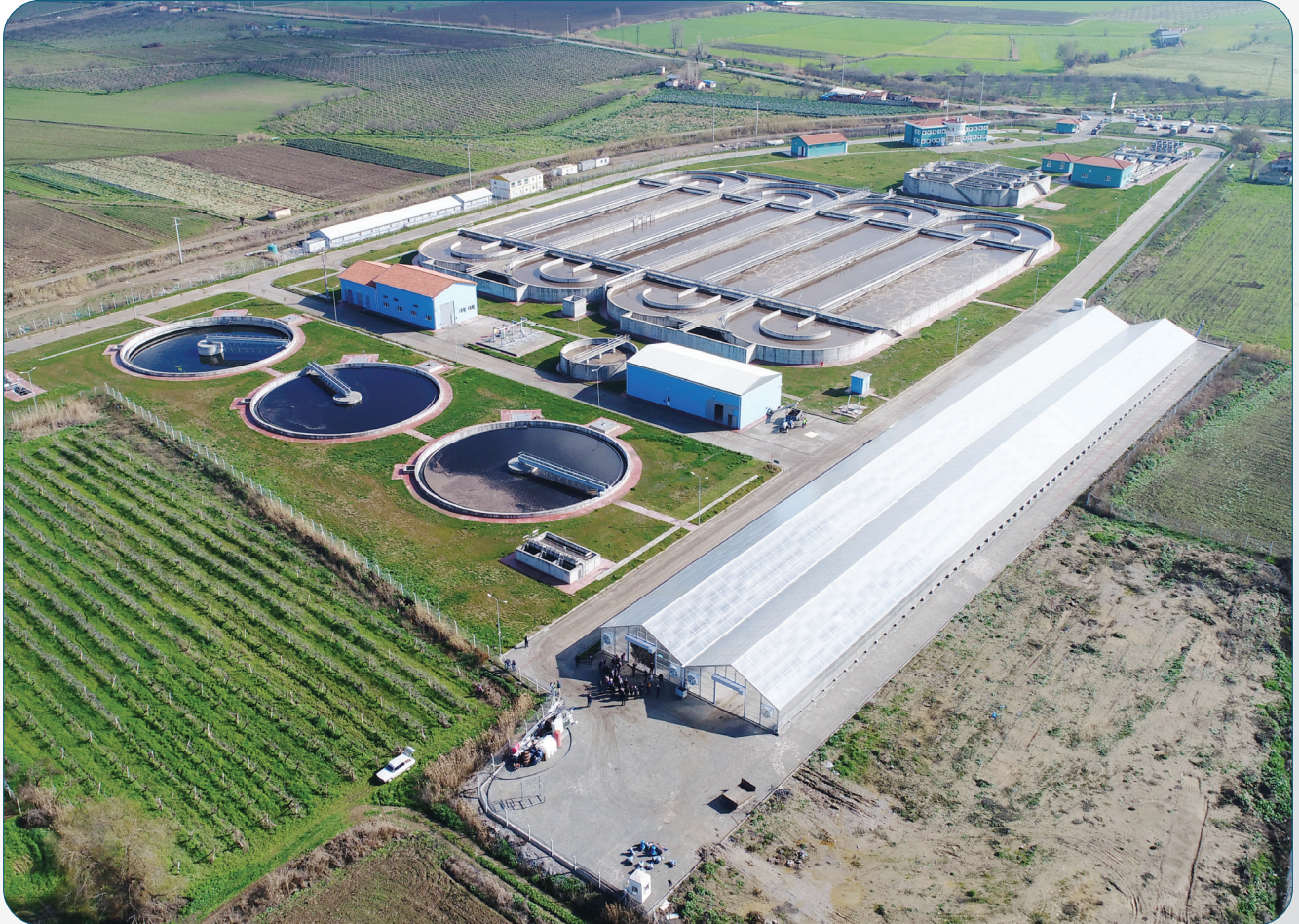
Turgutlu Atıksu Arıtma Tesisi
