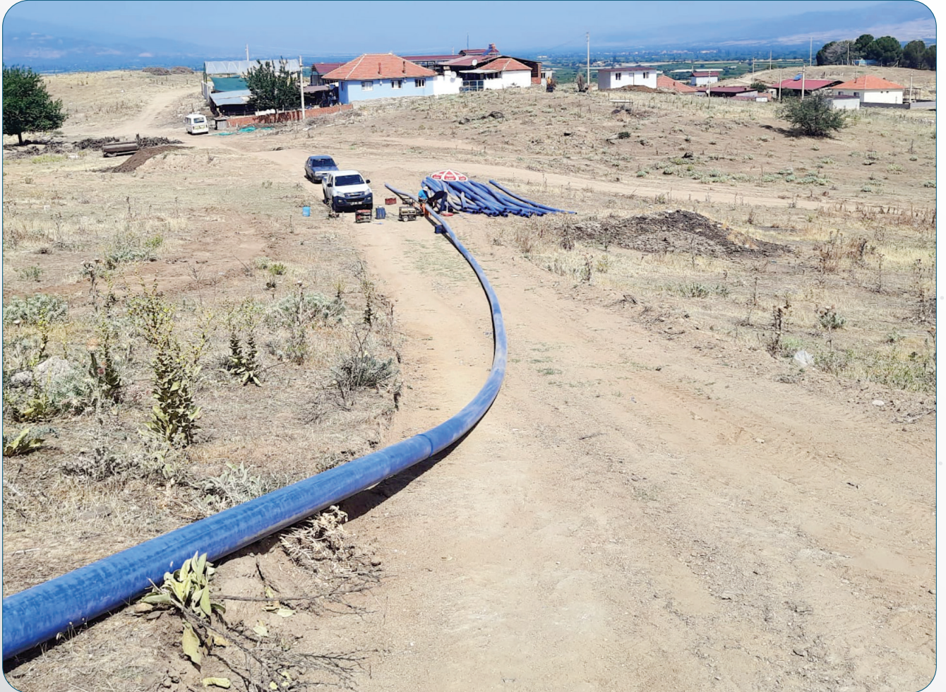
Sarıgöl Çimentepe Mahallesi İçem Suyu Terfi Hattı Döşeme Çalışması
