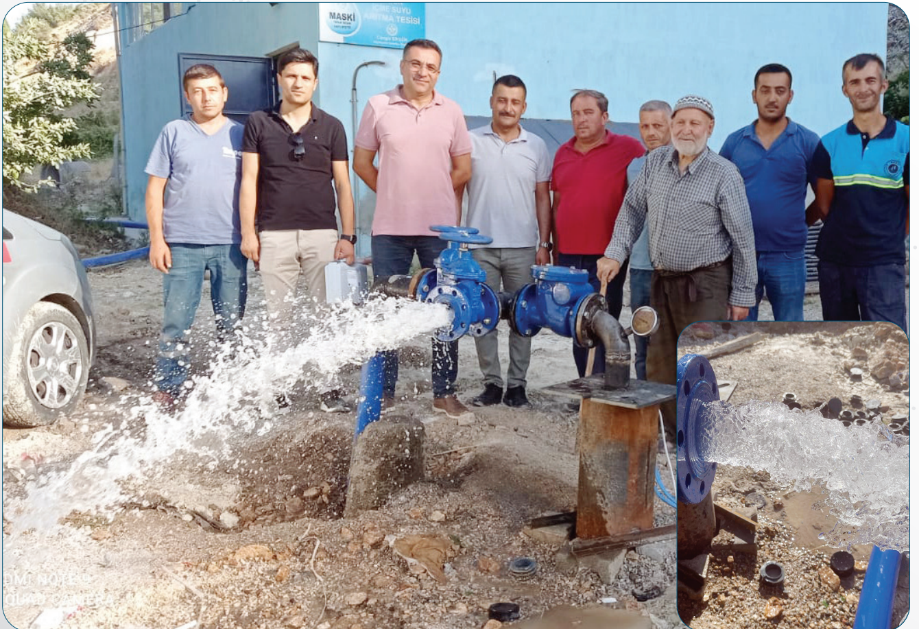
Kırkağaç Bakır Mahallesi Sondaj
