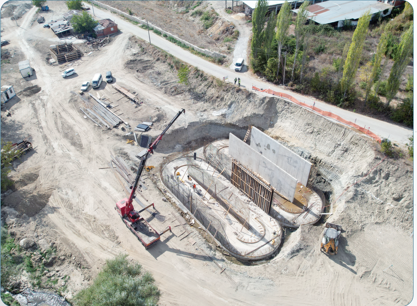
Demirci Atıksu Arıtma Tesisi
