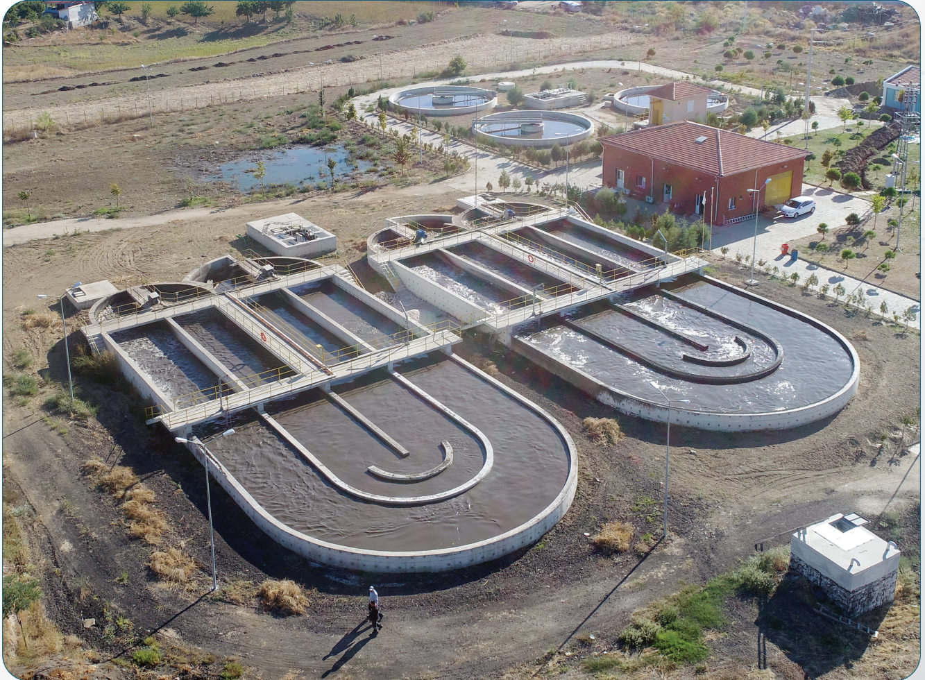
Kula Atıksu Arıtma Tesisi
