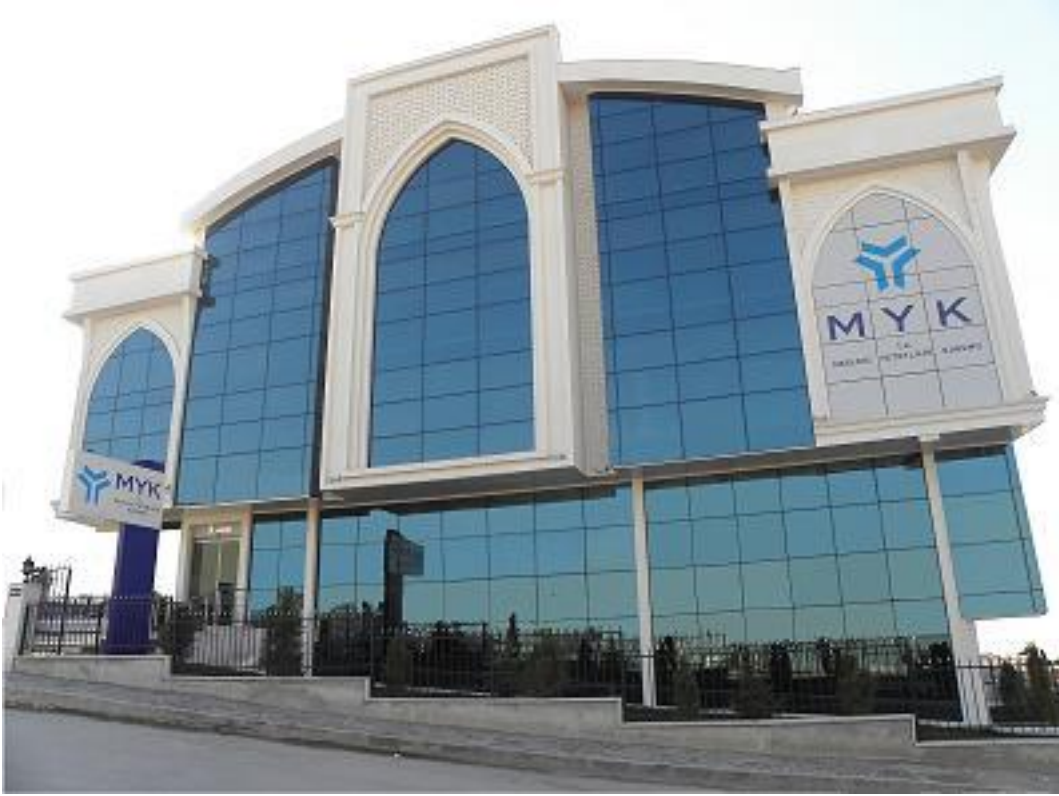
Resim 1- MYK Hizmet Binası
