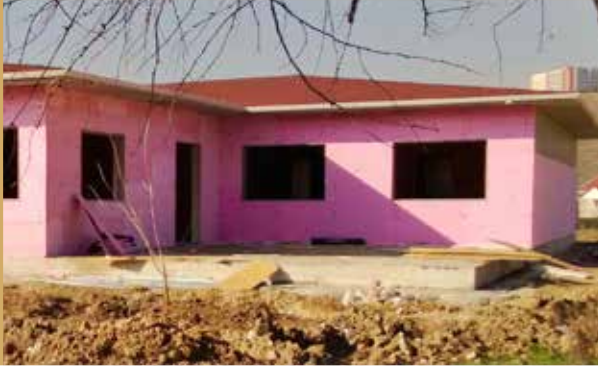
Çayyolu mahallesine 518 m 2 yaşlılara saygı derneği % 60 olup inşaatı devam etmektedir.
