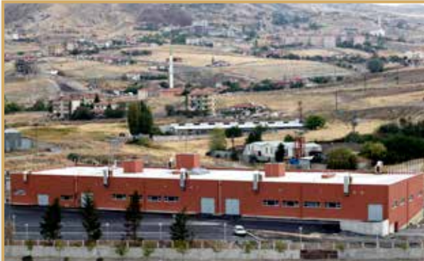
Yakacık mevkiinde 9088 m 2 alana sahip Park ve Bahçeler Müdürlüğünün İdari ve Atölye Binalarının Yapım işi tamamlandı.
