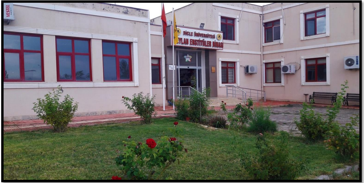
Ceylan Enstitüler Binası
