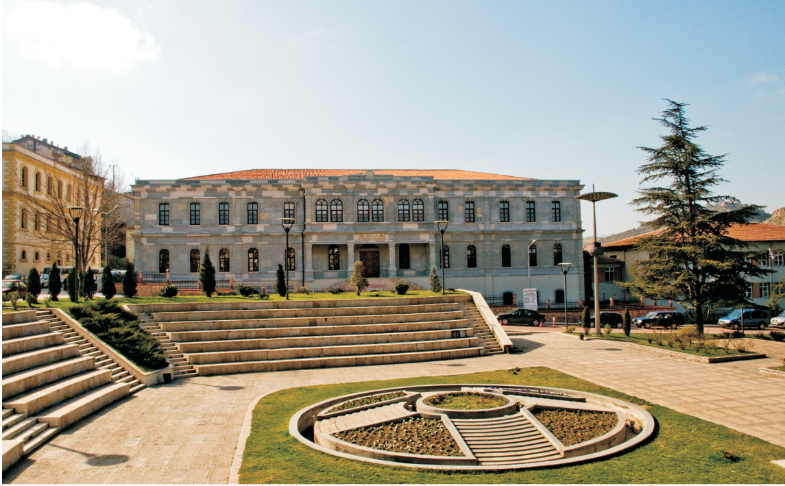
Resim 1- Rektörlük Binasından Görünüm
