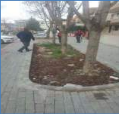
İstiklal Mah.Hekimler Sokak ağaç etrafı bordur içine toprak doldurma ve tesviye
