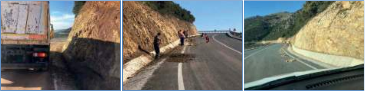
Dışkaya,Ericek ve Toki Yol Güzergahı v kanalı taş ve toprak temizliği
