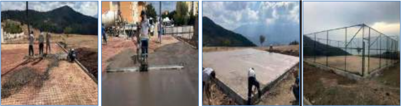
TOKİ Basketbol Sahası yapımı
