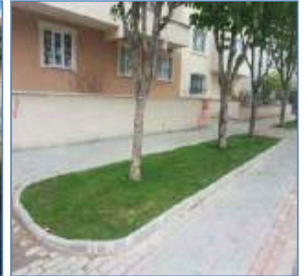
İstiklal Mah.Hekimler Sokak ağaç etrafı bordur içine toprak doldurma ve tesviye
