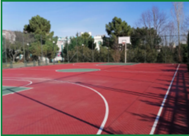
2. Basketbol Sahasının Akrilik Zemin Kaplama Malzemesi İle Kaplanarak Yenilenmesi
