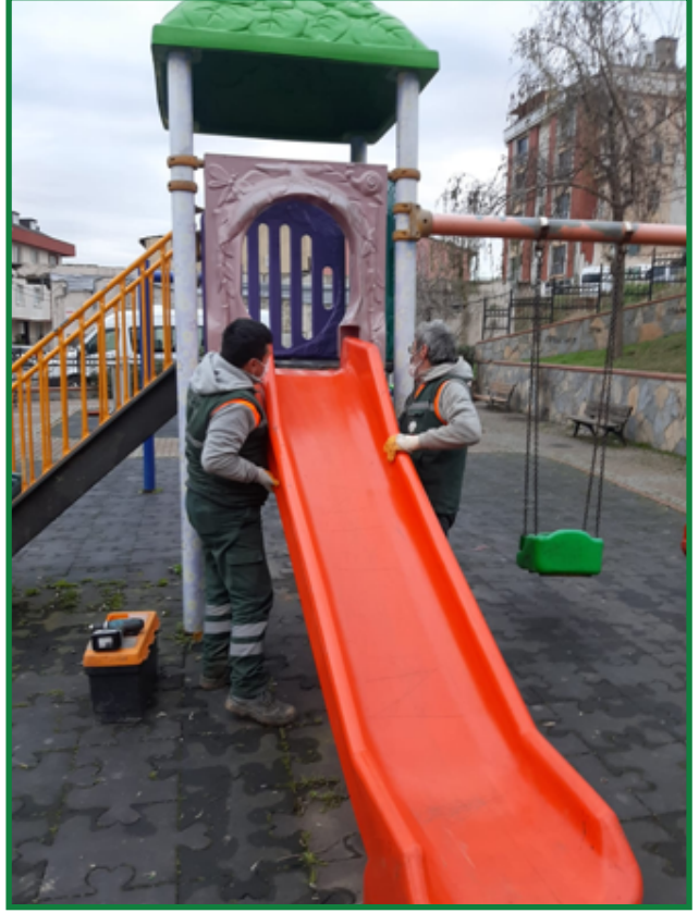
Parklarda Çocuk Oyun Grubu Onarım (Yeni Kaydırak Montajı) Çalışması
