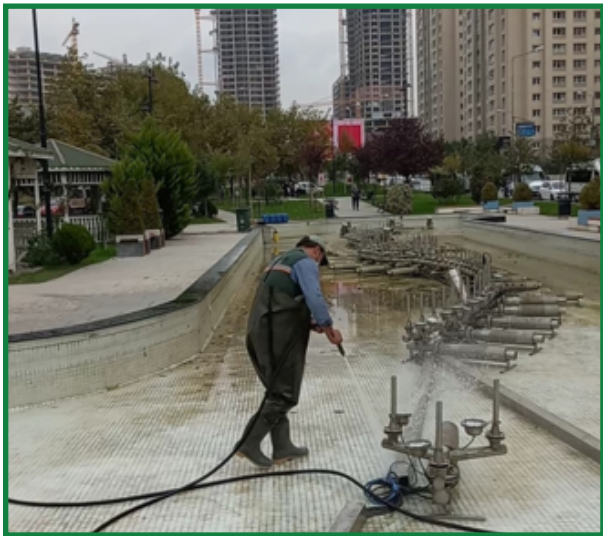
Parklarda Süs Havuzu Temizliği Yapılması
