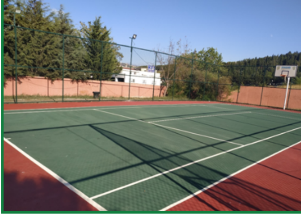
Askent Sitesi Parkı Basketbol Sahasının Akrilik Zemin Kaplama Malzemesi İle Kaplanarak Yenilenmesi
