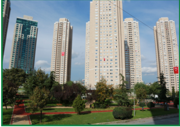
Tamamen Yenilenen Emekevler Parkı 2. Kısım
