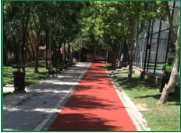
Muhtar Tacim Ayvadaş Parkı Yürüme Yolu Kauçuk Tamirâtı Yapımı
