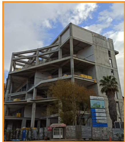
İçal Aydınoglu Kültür Merkezi İnşaatı
