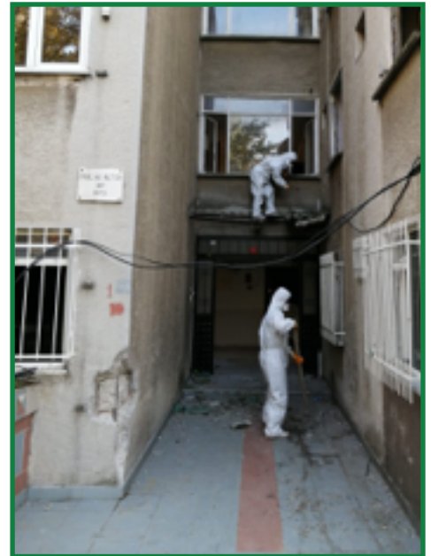
Asbest numune alımı
