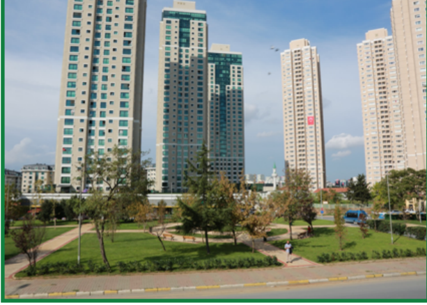
Tamamen Yenilenen Emekevler Parkı 1. Kısım
