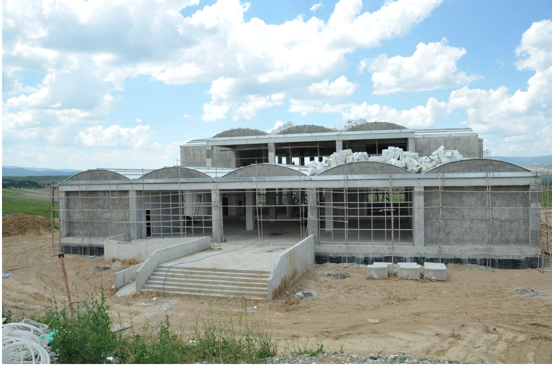
(Merkez Kafeterya İnşaatı)
