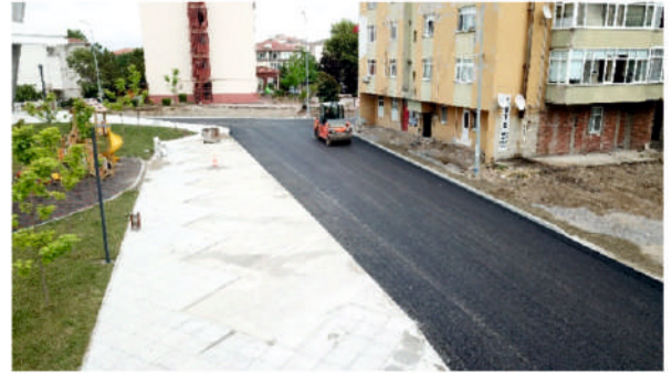
İncilli Mahallesi, 620 Nolu Sokak 1. Kısım
